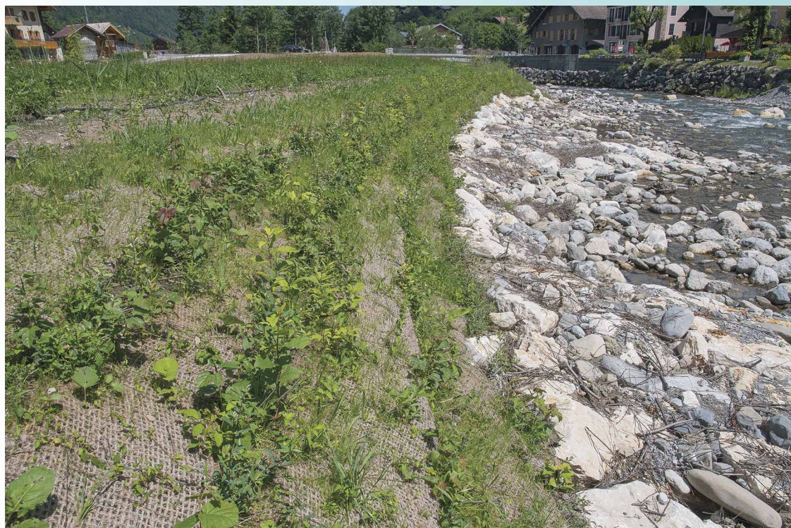
Figure 20. Ouvrage de génie végétal (technique mixte sur un torrent de montagne).
