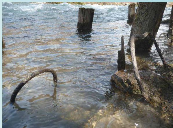
Figure 7. Fils de fer et fer à bétons créant de potentiels pièges une vingtaine d'année après la construction d'un ouvrage.
