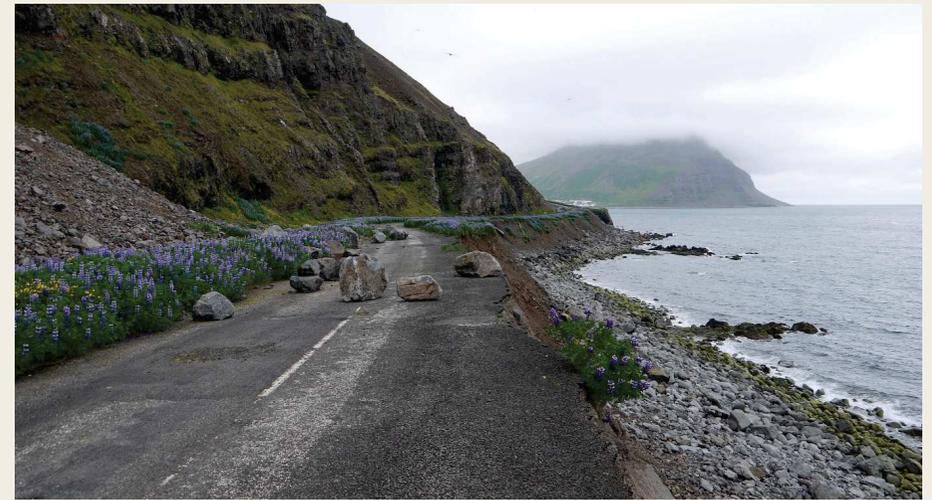
Figure 8 : Les chutes de pierres, sur un versant basaltique dans l'axe d'un cône torrentiel (dont la partie distale est visible à gauche du cliché), et l'érosion littorale ont conduit les autorités islandaises à fermer la route côtière permettant de relier Ísafjörður et Bolungarvík dans la région des Westfjords. Un tunnel creusé dans la montagne permet depuis 2010 de relier les deux localités distantes d'une quinzaine de kilomètres (66°05'N, 23°09'W)
