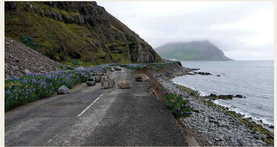
Figure 8 : Les chutes de pierres, sur un versant basaltique dans l'axe d'un cône torrentiel (dont la partie distale est visible à gauche du cliché), et l'érosion littorale ont conduit les autorités islandaises à fermer la route côtière permettant de relier Ísafjörður et Bolungarvík dans la région des Westfjords. Un tunnel creusé dans la montagne permet depuis 2010 de relier les deux localités distantes d'une quinzaine de kilomètres (66°05'N, 23°09'W)
