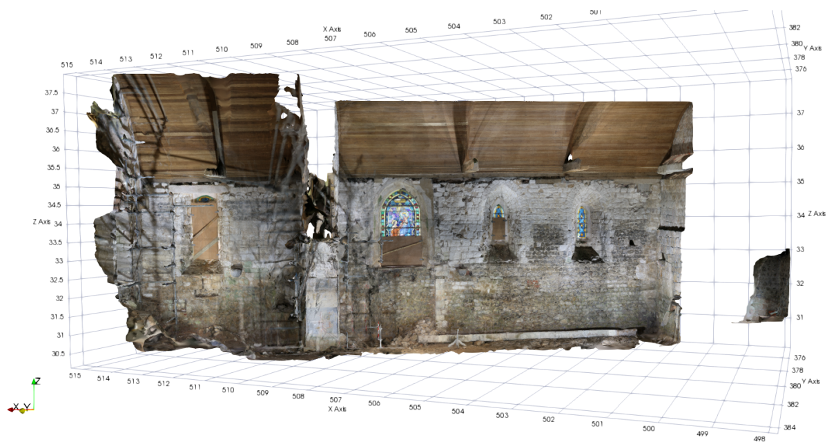
FIGURE 5.3 – Demi-MNT intérieur de la chapelle, vu de l'extérieur depuis le nord
