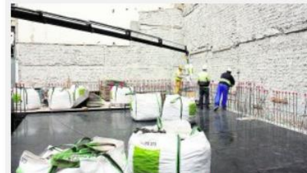
Tres operarios realizan trabajos en el futuro Museo de
