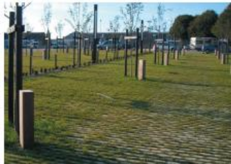
Réduire l'imperméabilisation des parking, St Pol de Léon
