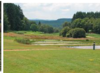
Epuration des eaux par lagunage à Sarrazan, Corrèze
