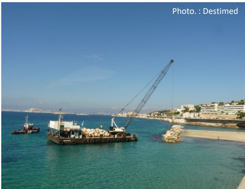
Rechargement des digues, Marseille (2018)
