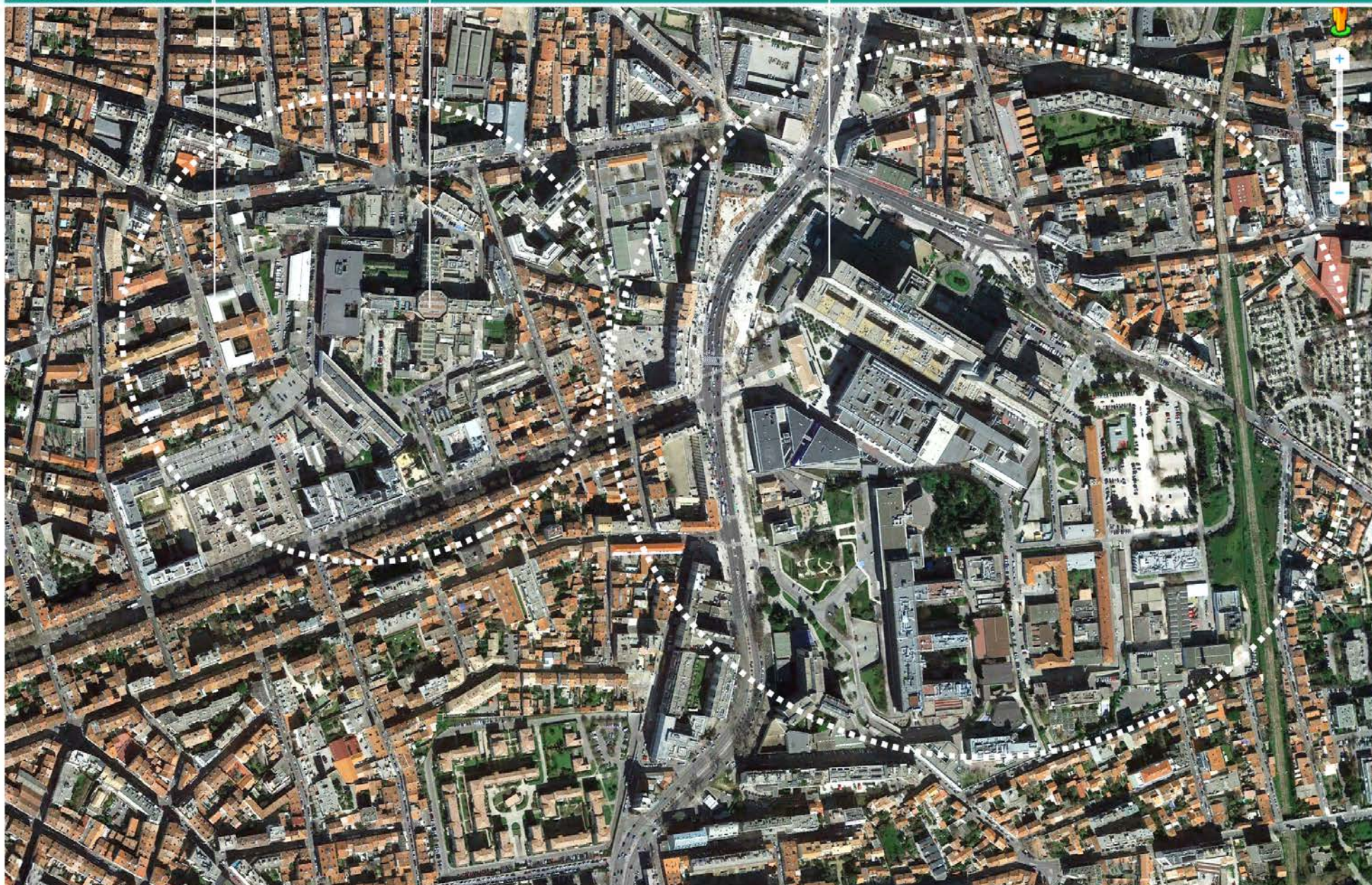
Figure 9 : APHM : les deux sites Timone et Conception état existant 2021. Source : rapport Plans Urbanisme pour l'APHM par ISA-Villien, 2021. Archives P. Villien
