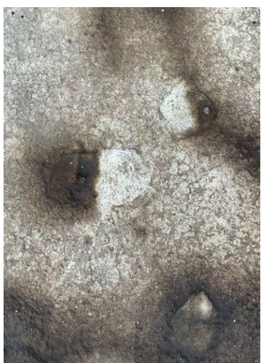
Fig.89 : Rebouchage ciment et attache métallique, US 3231 (photographie : J. Brangé).
