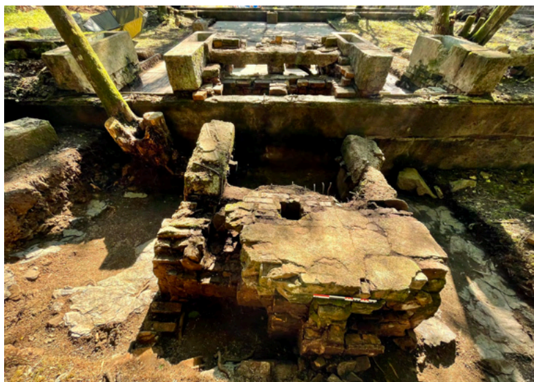
Fig.81 : Hotte de l'ELA 10, effondrée le long du mur gouttereau nord-est (photographie : M. Landolt).
