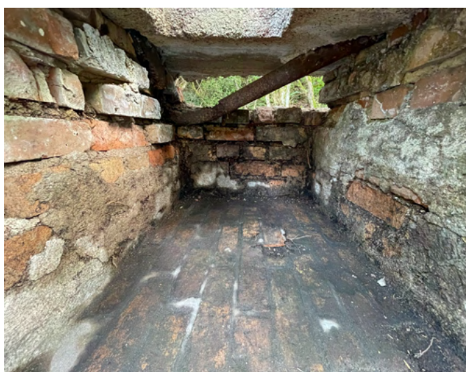
Fig.79 : Intérieure de l'espace de stockage du combustible (photographie : M. Landolt).
