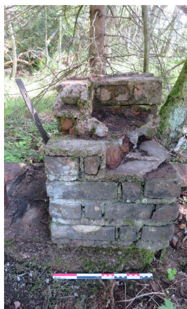
Fig.230 : Cheminée, mur gouttereau sud-est (photographie : M. Landolt).
