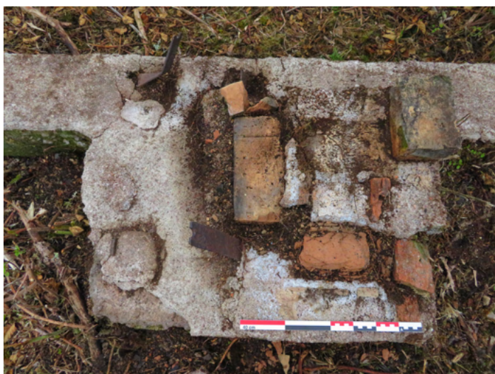
Fig.213 : Cheminée, mur gouttereau sud-est (photographie : M. Landolt).
