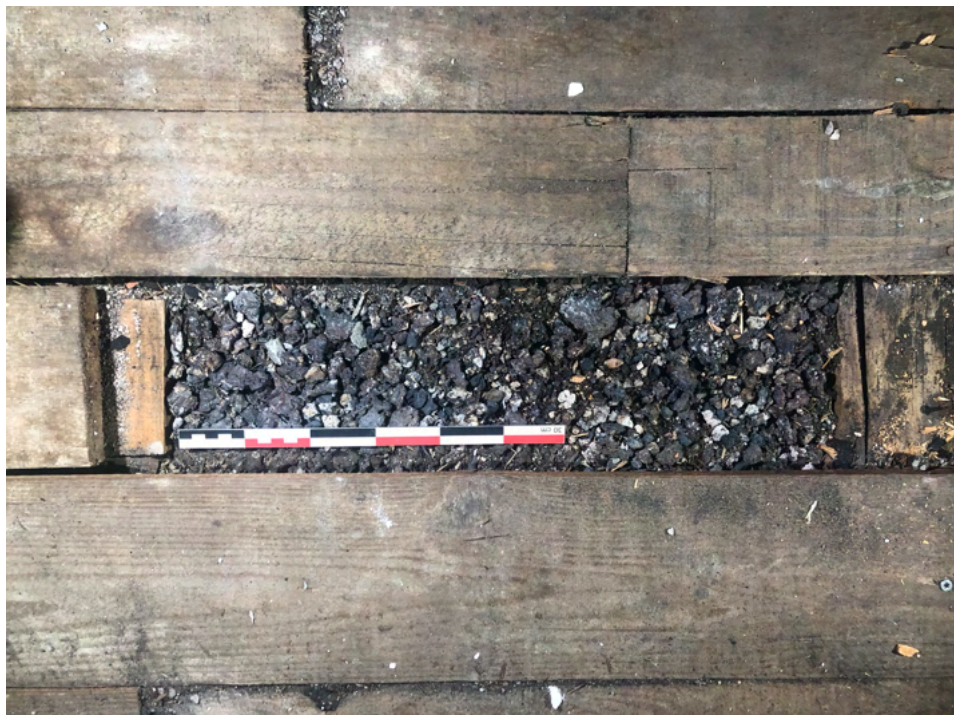
Fig.398 : Résidus scorifiés de forge réutilisé comme isolation dans les comble d la chambre à gaz du camp de Natzweiler, ENA 67(photographie : M. Landolt).
