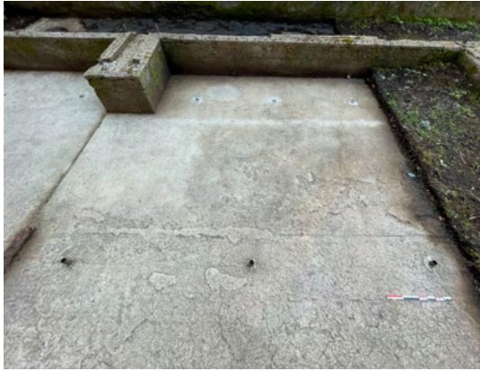
Fig.92 : Attaches métalliques et rebouchage, US 3232 et 3237 et empreintes rectilignes, US 3234 et 3235 (photographie : J. Brangé).
