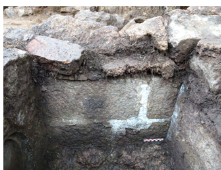
Fig.149 : Intérieur du regard 107.16 (photographie : J. Brangé).
