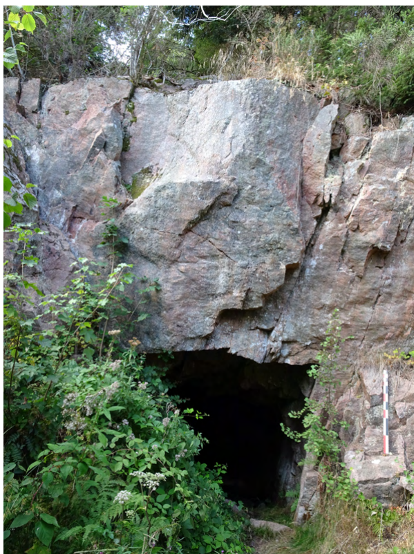
Fig.194 : Vue actuelle de l'entrée du tunnel 1, ENA 123 (M. Landolt).
