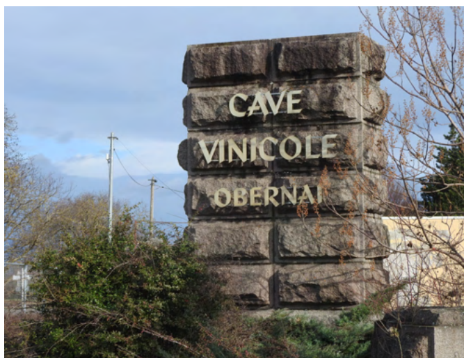
Fig.382 : Blocs entreposés sur le site de la cave viticole Divinele d'Obernai (photographie : J. Brangé).
