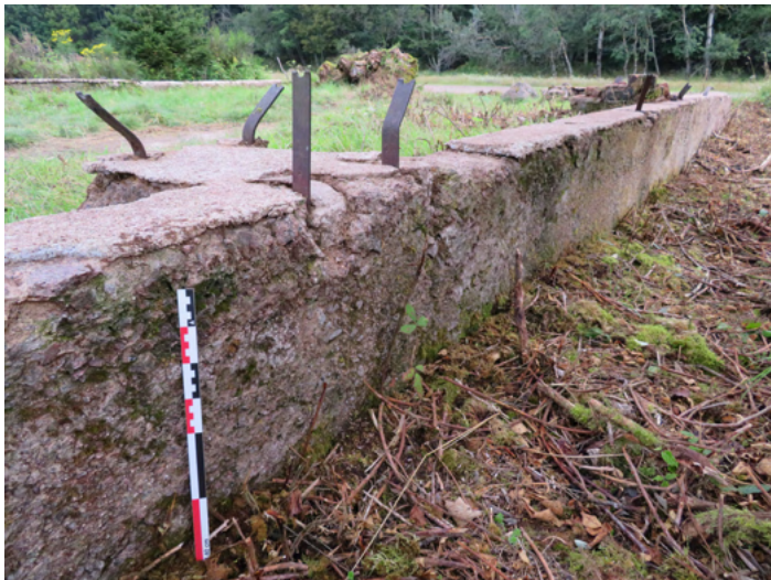
Fig.207 : Mur gouttereau sud-est ; on peut distinguer l'enduit de finition sur la partie supérieure du mur (photographie : M. Landolt).
