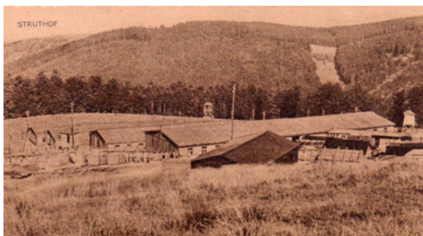
Fig.22 : Vue de la construction du camp haut au début de l'année 1942 par les déportés (NATZ19_PH_ARCH_002, carte postale édition Lucien Kohler, CERD).
