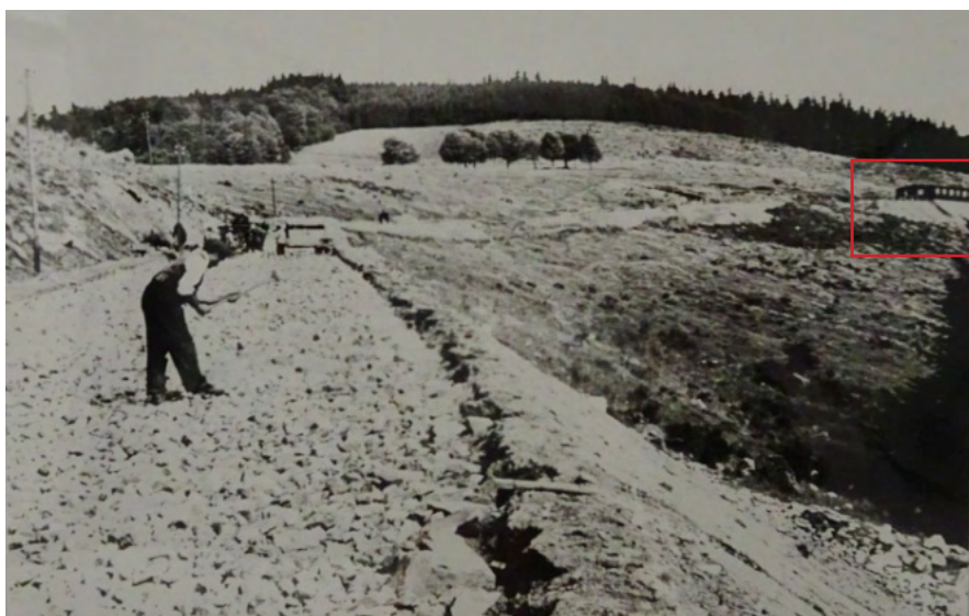
Fig.240 : Vue de la route menant à la carrière vers 1941 ; la baraque des gardiens est encadrée (NATZ19_PH_ARCH_243, CERD).
