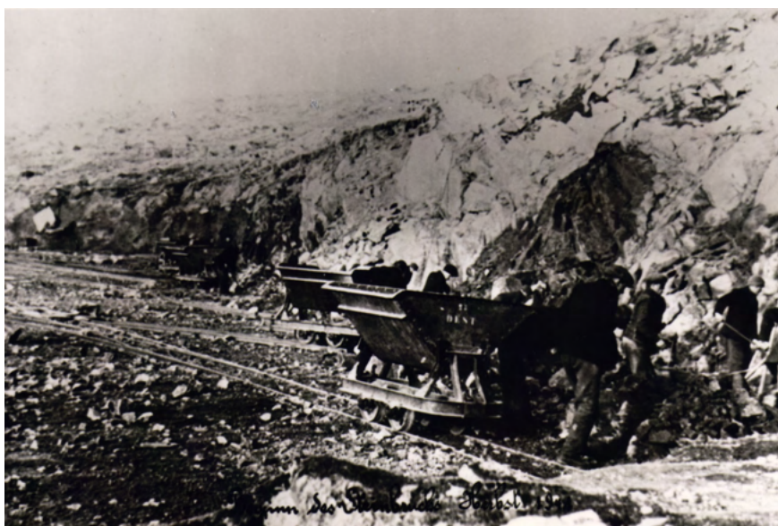
Fig.40 : Travail d'extraction du granite au sein de la carrière au printemps 1941; les wagonnets sont marqués DESt (NATZ19_PH_ARCH_094, CERD).
