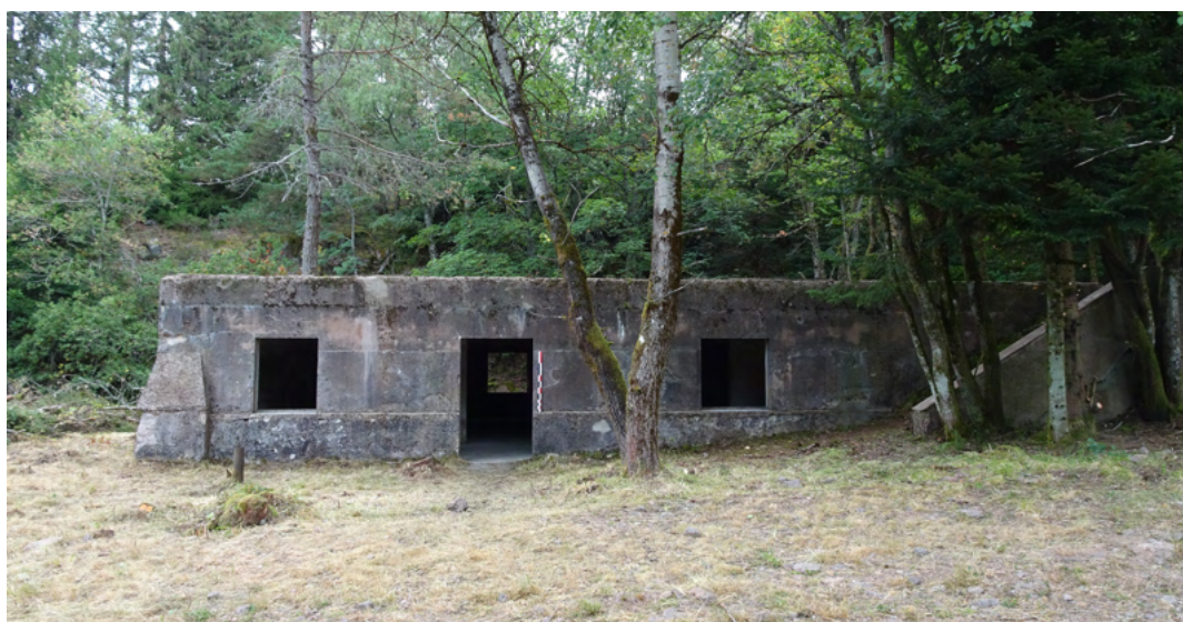
Fig.67 : Façade sud-ouest de la forge, campagne de prospection 2020 (J. Brangé).
