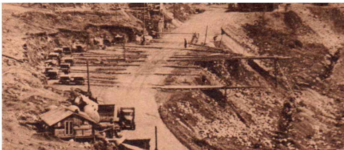
Fig.115 : Rejet des déchets du front de taille avec le système de rails et wagonnets (NATZ19_PH_ARCH_001, CERD).
