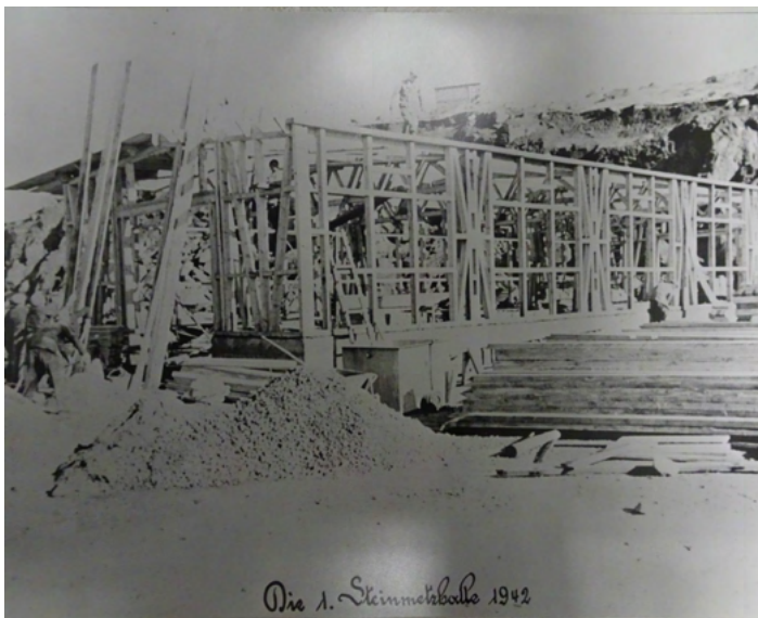
Fig.209 : Construction de la halle 1 en 1942 (NATZ19_PH_ARCH_091, CERD).
