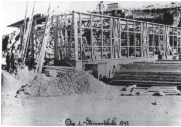
Fig.41 : Construction de la première halle en 1942 (NATZ19_PH_ARCH_091, CERD).
