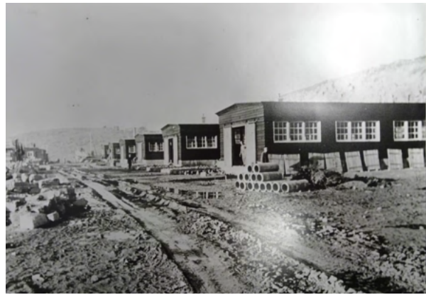
Fig.42 : Carrière au printemps 1943. Toutes les halles du côté ouest ne sont pas encore construites (NATZ19_PH_ARCH_014, CERD).
