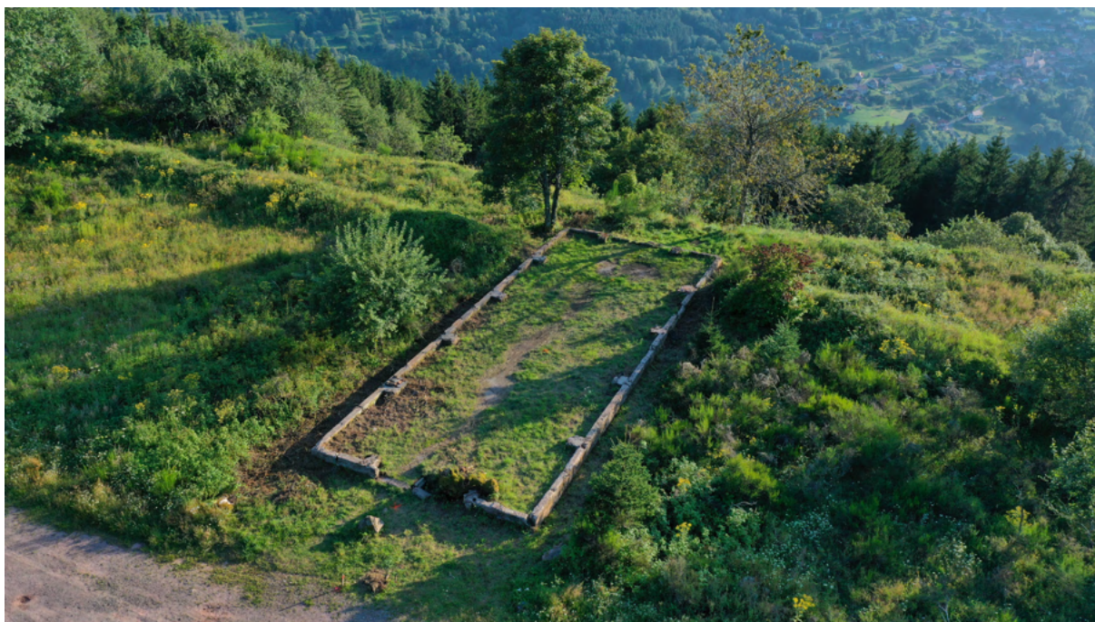
Fig.204 : Halle 9 (ENA 111) ; on peut distinguer le talus de part et d'autre de la baraque (photographie : A. Vantillard).
