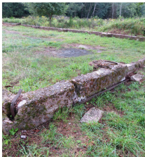
Fig.212 : Rail pour la porte coulissante, pignon sud-ouest (photographie : M. Landolt).
