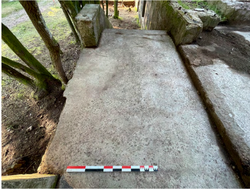
Fig.163 : Couloir avec ses traces de boucharde de cimentier sur la dalle en béton, SD5 (photographie : M. Landolt).
