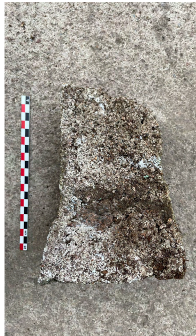
Fig.132 : Fragment de joints en béton (photographie : M. Landolt).
