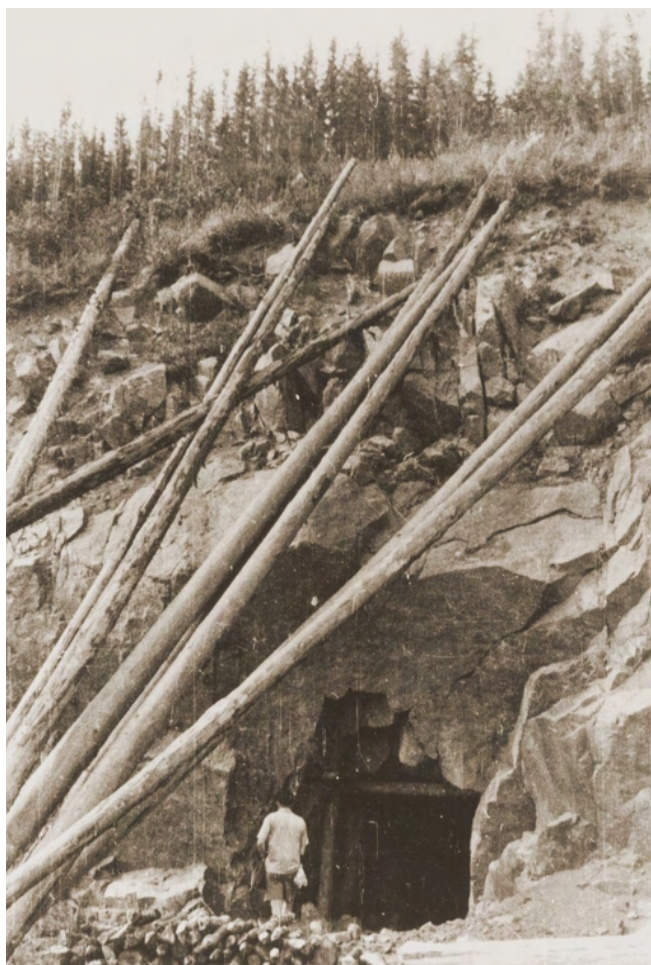
Fig.45 : Entrée du tunnel 2 (ENA 124) en 1944 (NATZ19_PH_ARCH_378, CERD).
