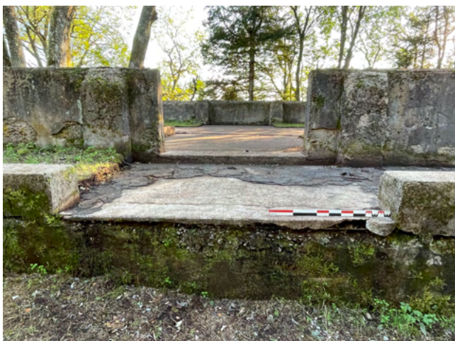
Fig.177 : Toile goudronnée sur le sol du couloir, pièce 5, ENA 106 (photographie : M. Landolt).
