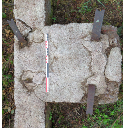
Fig.206 : Plot en béton pour les poteaux en bois (photographie : M. Landolt).
