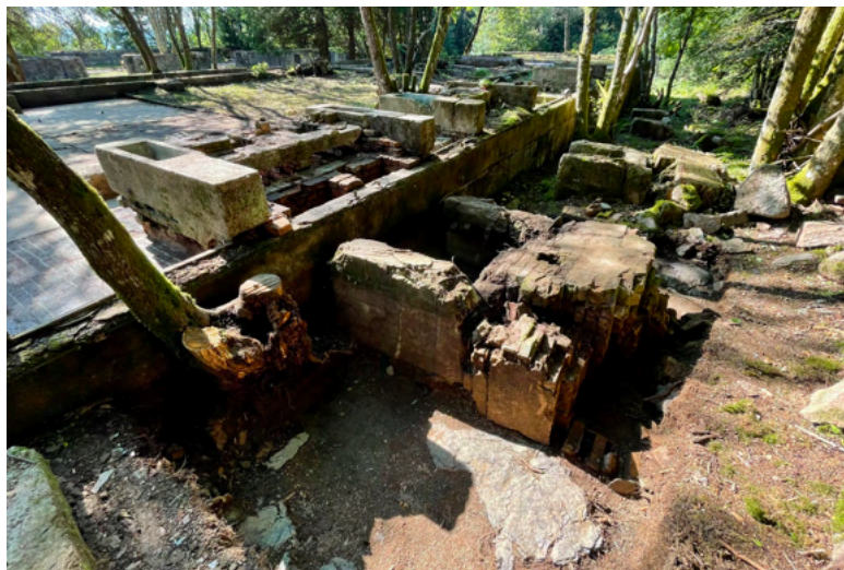
Fig.80 : Hotte de l'ELA 10, effondrée le long du mur gouttereau nord-est (photographie : M. Landolt).
