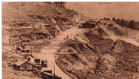
Fig.23 : Exploitation de la carrière au printemps 1942. On peut remarquer les rampes d'évacuation des déchets de taille ( NATZ19_PH_ARCH_001, carte postale édition Lucien Kohler, CERD).
