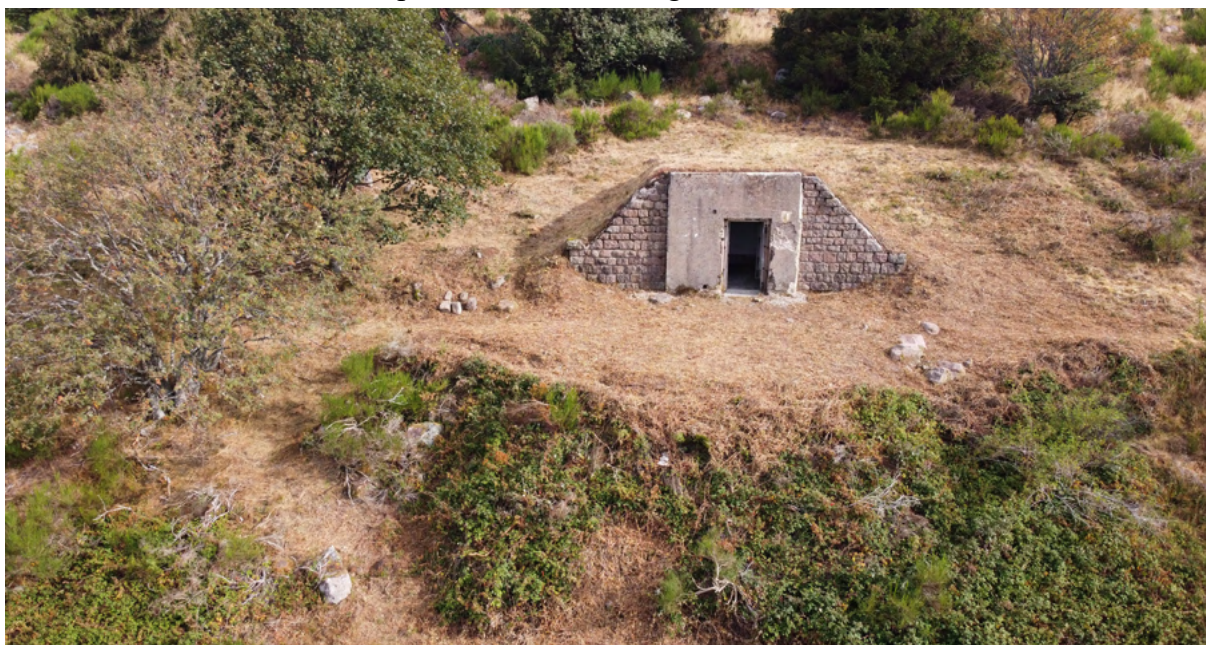
Fig.39 : Vue de la poudrière 1, ENA 98 (photographie : A. Vantillard).
