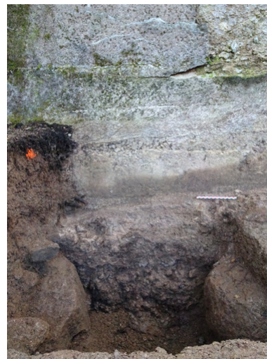
Fig.117 : Fondation du mur sud-ouest, ENA 107 (photographie : J. Brangé).
