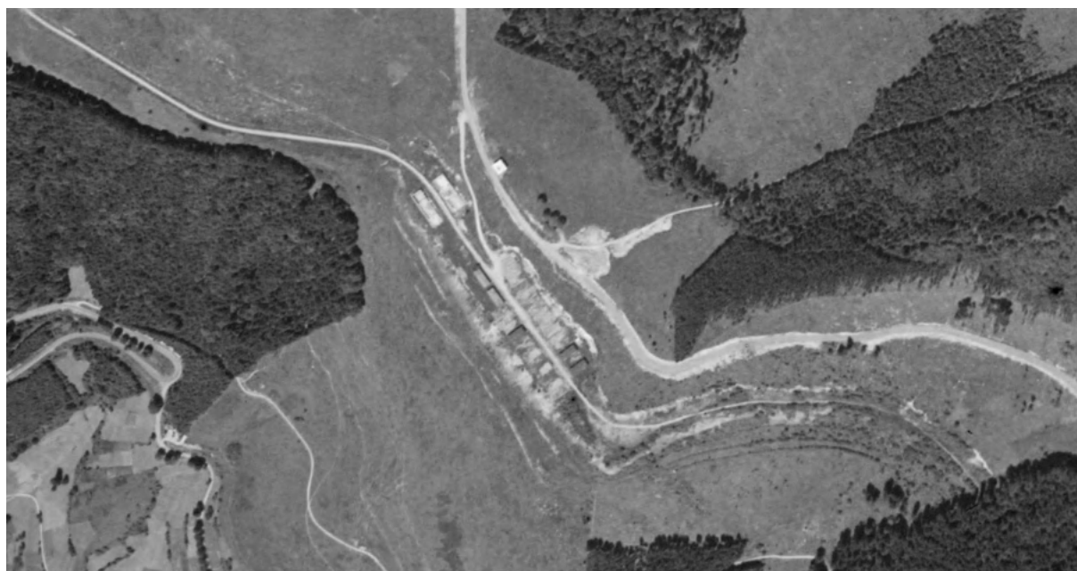
Fig.201 : Photographie aérienne de la carrière en 1956 ; trois halles sont encore en élévation, ENA 111, 121 et 122 (NATZ19_PH_ARCH_337, IGN).
