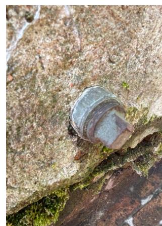
Fig.77 : Bouchon du tuyau de vidange du bac de trempe (photographie : M. Landolt).
