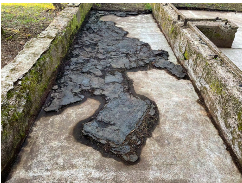
Fig.97 : Niveau de démolition, toile goudronnée, couloir extérieur (photographie : J. Brangé).
