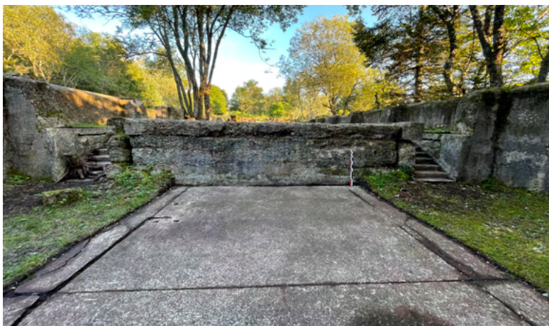
Fig.174 : Vue général partie nord-ouest (pièce 1) du sondage du dépôt, ENA 106 (photographie : M.
