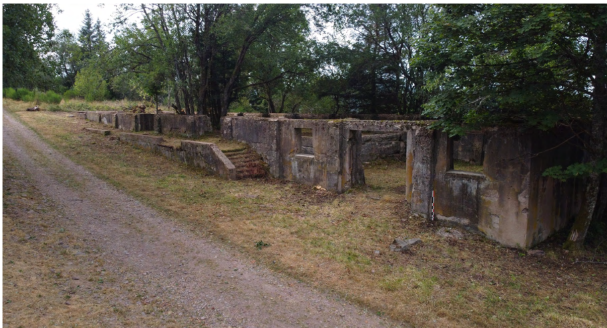
Fig.51 : Vue du bâtiment dépôt (photographie : A. Vantillard).
