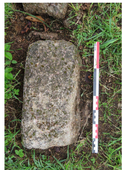
Fig.210 : Bloc en béton aggloméré, pignon sud-ouest (photographie : M. Landolt).
