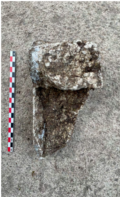
Fig.130 : Fragment de joints en béton (photographie : M. Landolt).
