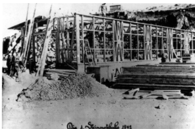
Figure 15 : Cliché de la construction de la première halle de la carrière en 1942 (NATZ19_PH_ARCH_091, CERD).
