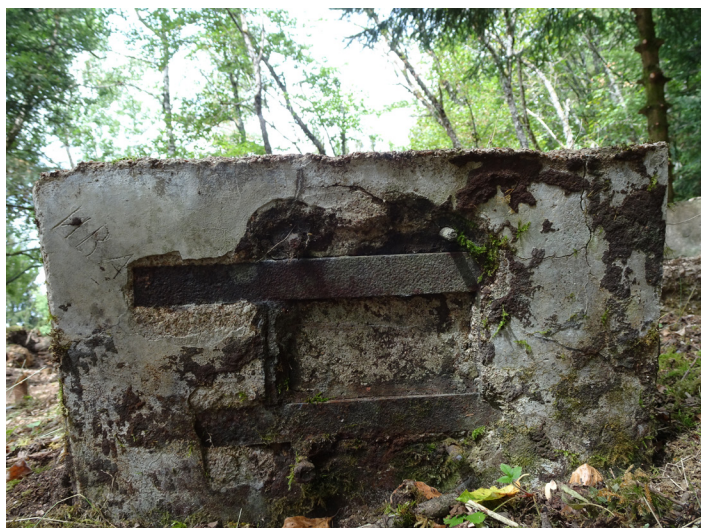
Figure 91 : Vue de la partie supérieure de l'ELA 14 (J. Brangé).
