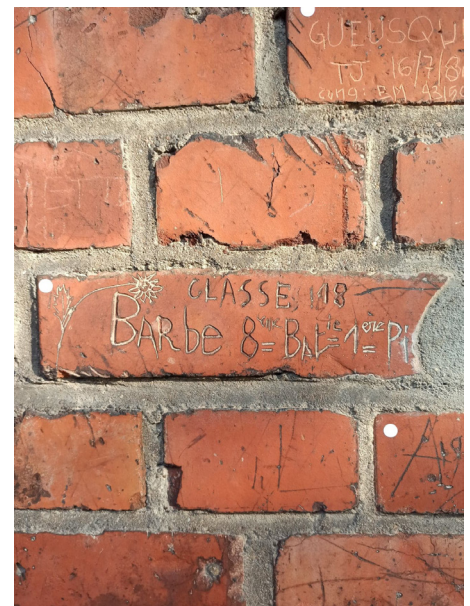
Figure 40 : Vue d'un graffiti de la caserne Lizé, Montigny-lès-Metz (J. Brangé).
