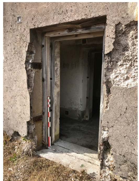
Figure 166 : Vue de la porte d'entrée de la poudrière, ENA 098 (J. Brangé).
