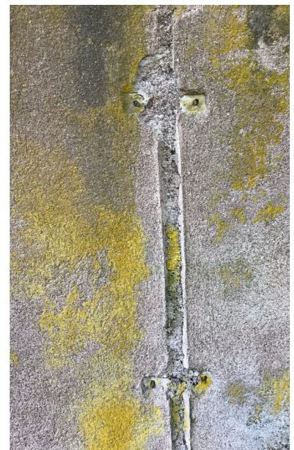
Figure 127 : Vue de détail de l'empreinte assimilée à une arrivée électrique (J. Brangé).
