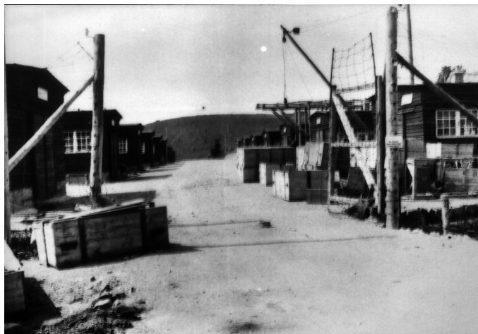
Figure 172 : Cliché de l'entrée sud de la carrière en 1943-1944 (NATZ19_PH_ARCH_095, CERD).
