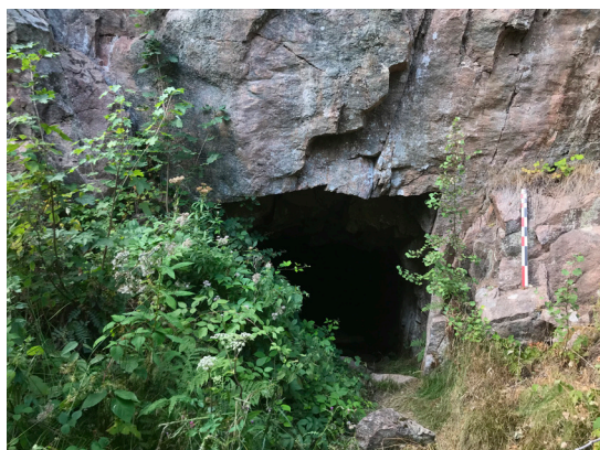
Figure 174 : Vue de l'entrée du tunnel 123 (M. Landolt).
