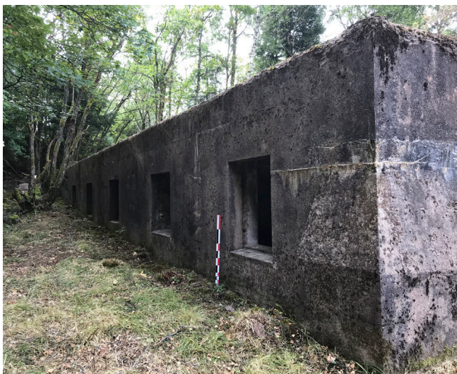
Figure 63 : Vue de la façade nord-est de la forge et du contrefort (J. Brangé).
