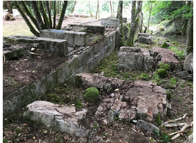
Figure 108 : Vue des hottes effondrées à l'arrière du bâtiment (J. Brangé).
