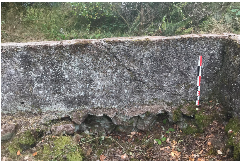
Figure 143 : Vue du mur périphérique et des blocs en granite composant la terrasse. Un arrêt de coulage est visible (trace en diagonale) (M. Landolt).
