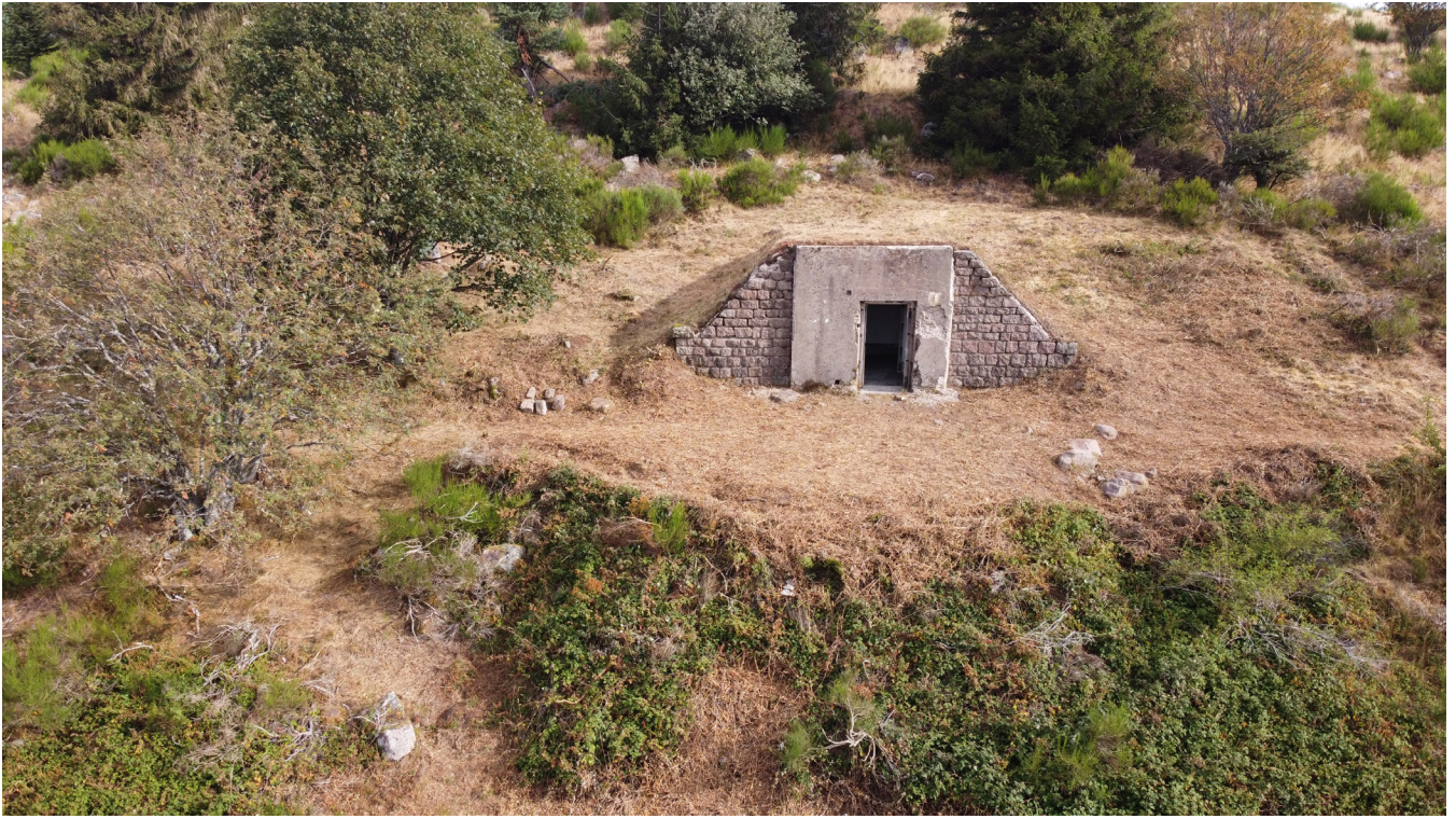
Figure 155 : Vue aérienne de la poudrière 098 (A. Vantillard).
