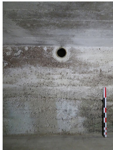
Figure 75 : Vue de la perforation circulaire dans le mur sud-est (M. Landolt).
