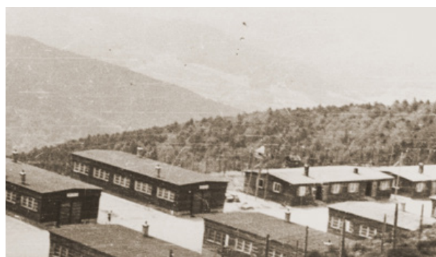
Figure 140 : Vue de la carrière, fin 1944-début 1945. La cantine est encadrée (NATZ19_PH_ARCH_096, CERD).
