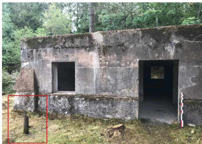
Figure 105 : Vue de l'emplacement de la pompe (J. Brangé).
