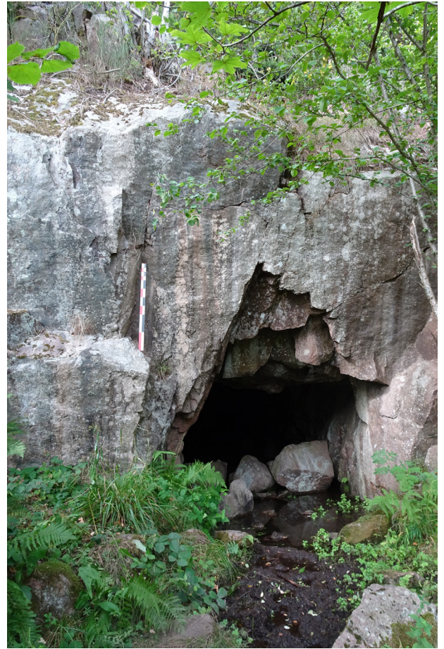
Figure 191 : Vue actuelle de l'entrée du tunnel 124 (M. Landolt).
