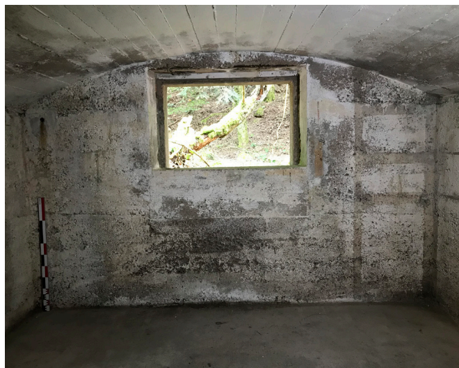
Figure 64 : Vue de la fenêtre de la pièce 5 (M. Landolt).
