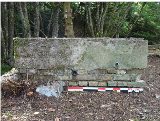
Figure 109 : Vue des vestiges du système de soufflet sur le côté de l'ELA 12 (J. Brangé).
