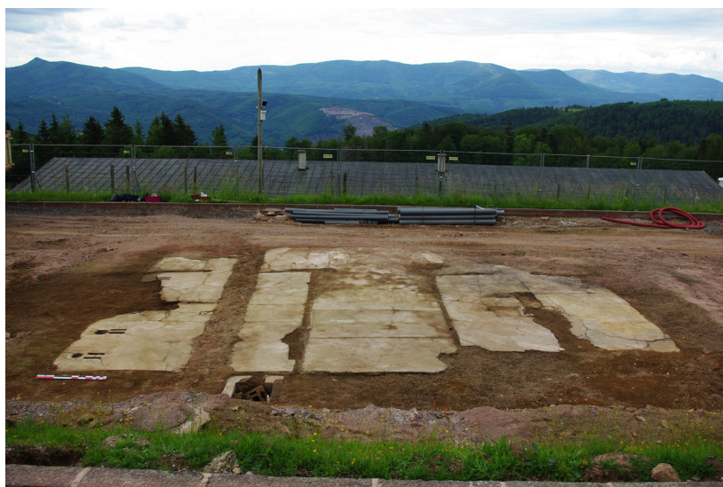
Figure 30 : Vue du sol bétonné de la baraque administrative (M. Landolt).
