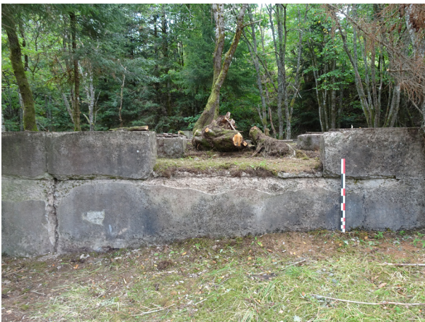
Figure 97 : Vue d'une ouverture dans le parapet en béton (J. Brangé).
