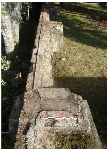
Figure 128 : Vue des empreintes des élévations en bois dans l'enduit des murs périphériques (J. Brangé).
