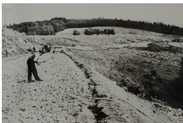
Figure 12 : Construction de la route pour les civils, menant à la carrière, vers 1941 (NATZ19_PH_ARCH_243, CERD).
