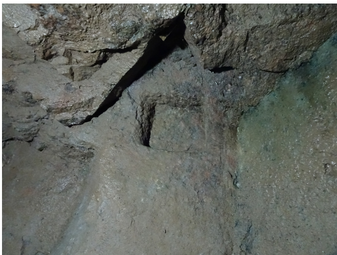
Figure 181 : Vue d'un évidement dans la paroi permettant l'installation d'une poutre en bois, tunnel 124 (M. Landolt).
