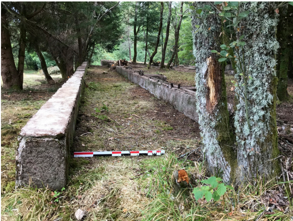
Figure 95 : Vue de la coursive extérieure (J. Brangé).
