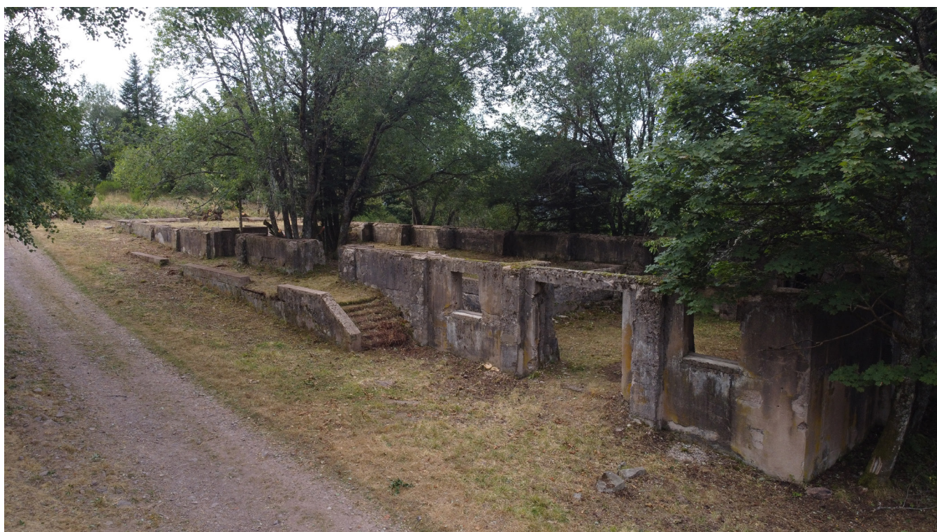
Figure 119 : Vue de la façade nord-est du bâtiment dépôt, ENA 106 (A. Vantillard).
