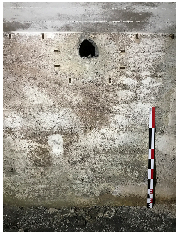
Figure 79 : Vue du tuyau traversant vers la pièce 5 et du réseau électrique le contournant (M. Landolt).
