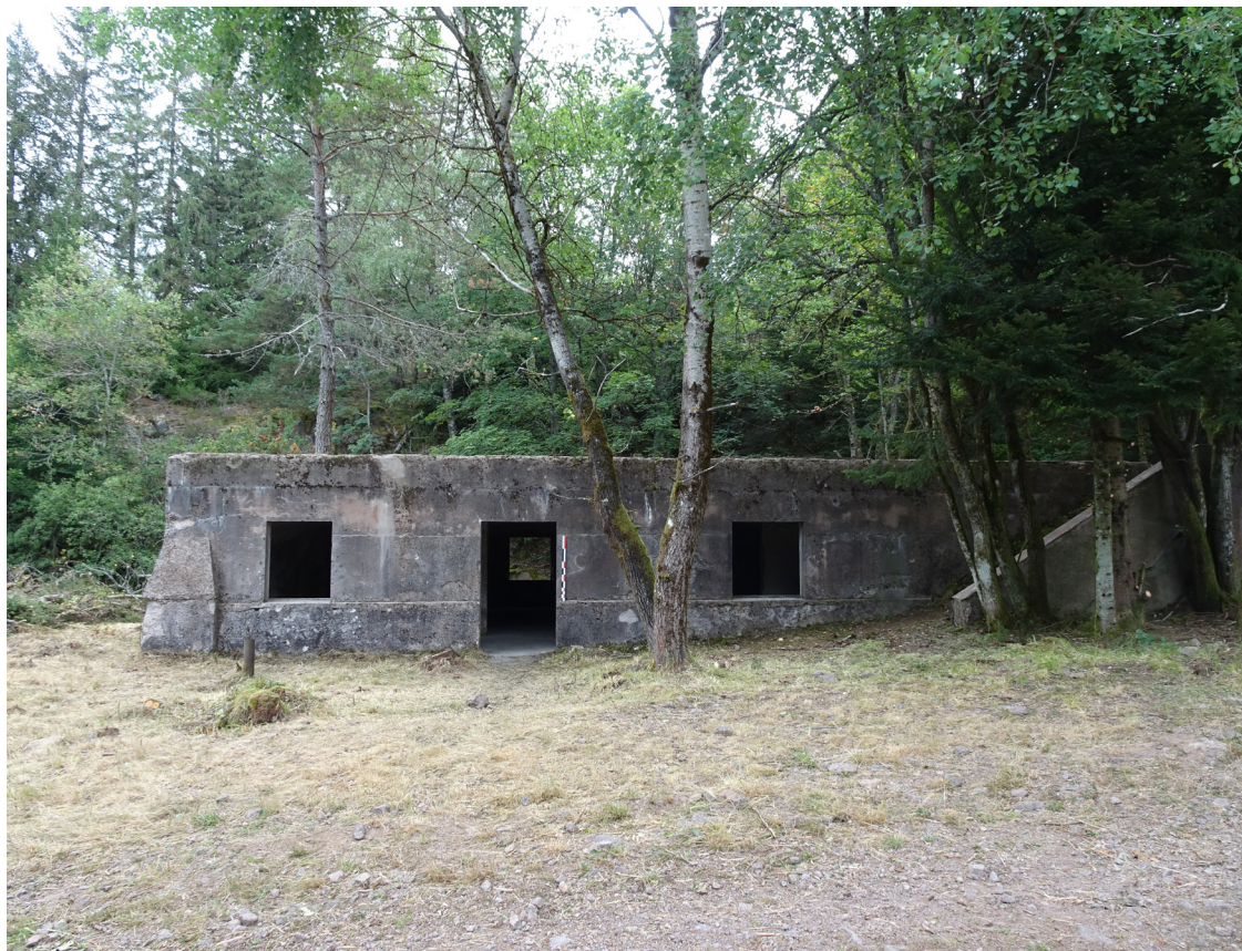
Figure 57 : Vue de la façade sud-ouest de la forge (J. Brangé).
