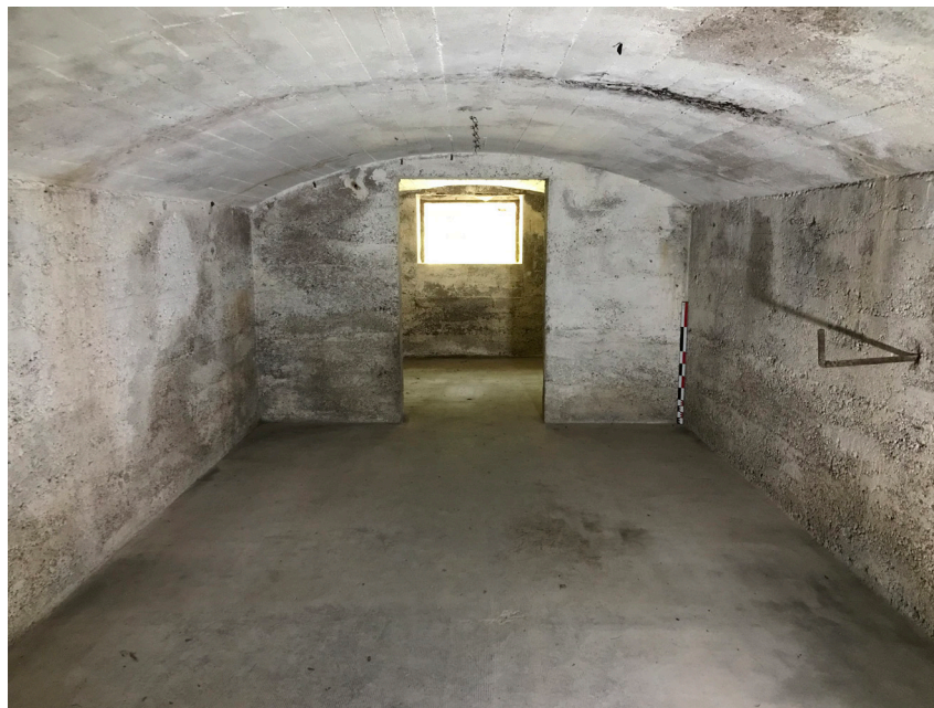
Figure 84 : Vue de la pièce 6 ; à droite on peut remarquer une grande tige métallique fixée dans le mur (M. Landolt).
