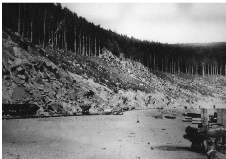
Figure 52 : Vue du front de taille sud de la carrière pendant la période concentrationnaire (NATZ19_PH_ARCH_013, CERD).
