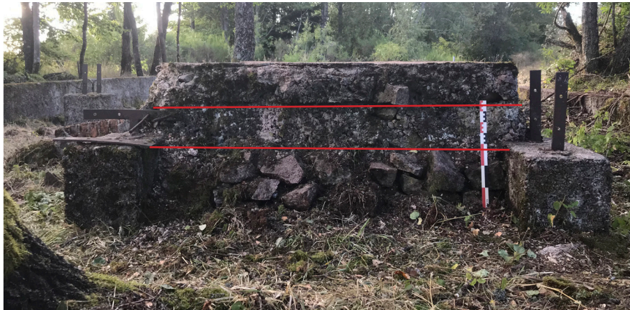
Figure 149 : Empreinte d'une poutre porteuse dans le massif en béton, matérialisé sur cette photographie par des traits rouges (J. Brangé).
