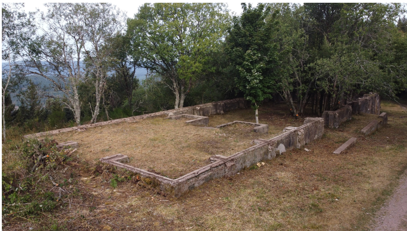
Figure 122 : Vue de l'intérieur du bâtiment dépôt (A Vantillard).
