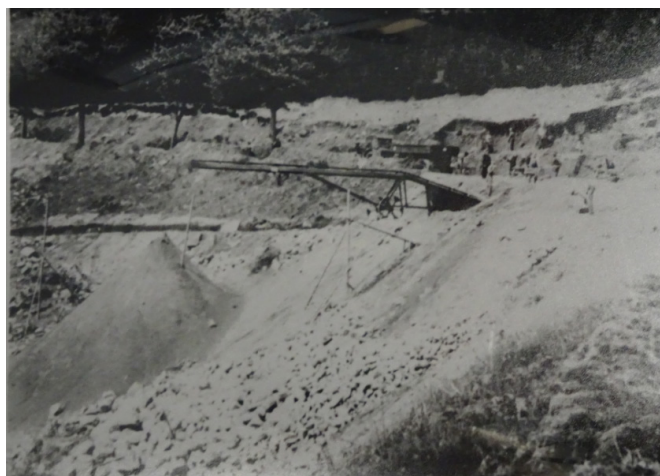
Figure 49 : Vue d'une rampe d'évacuation à la carrière vers 1940-41 (NATZ19_PH_ARCH_175, CERD).
