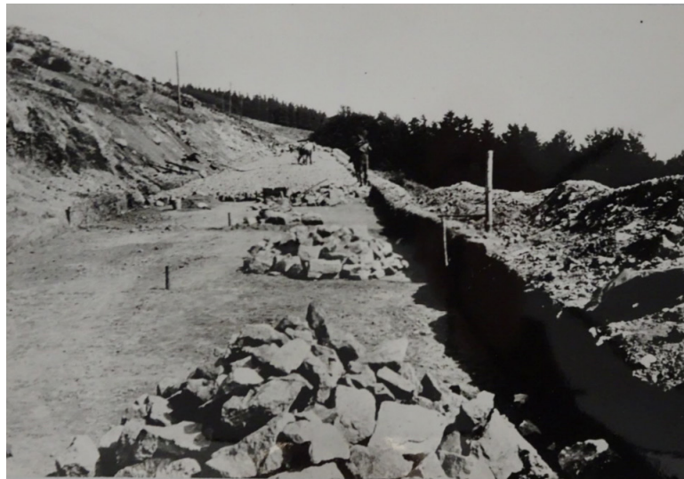
Figure 24 : Vue de la construction de la route, entre septembre 1940 et 1941 (NATZ19_PH_ARCH_245, CERD).
