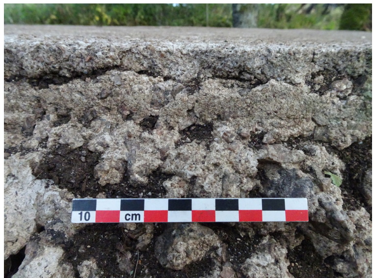
Figure 151 : Détail d'une empreinte de plancher dans le massif en béton (M. Landolt).
