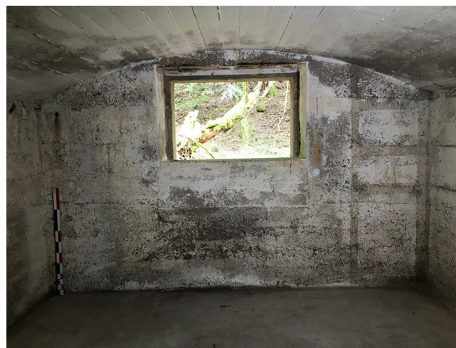
Figure 81 : Vue du mur nord-est (M. Landolt).
