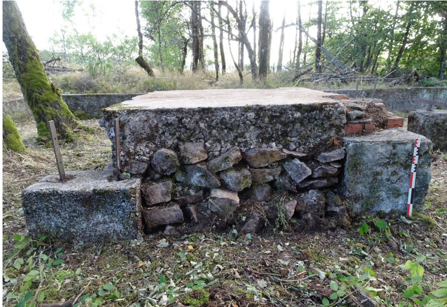
Figure 154 : Vue du massif en béton, ELA 22 (J. Brangé).
