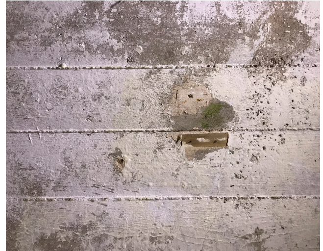
Figure 62 : Vue du plafond voûté de la pièce 1 (M. Landolt).
