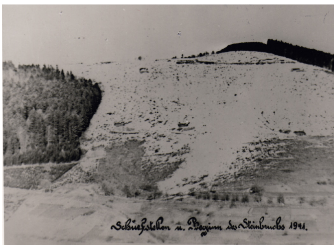
Figure 10 : Cliché en lien avec l'expédition de K. Blumberg « Schürfstellen u. Beginn des Steinbruchs 1941 » (= Le site de prospection et le début de l'exploitation de la carrière) (NATZI9_PH_ARCH_100, CERD).
