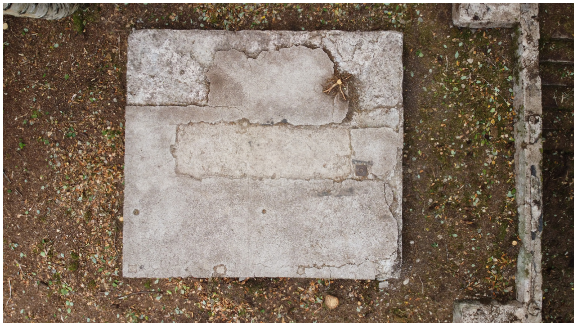
Figure 88 : Vue zénithale du massif en béton (A. Vantillard).
