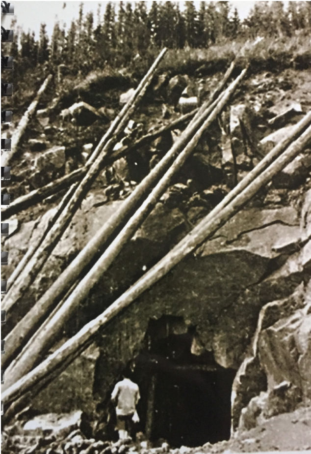
Figure 190 : Vue de l'entrée du tunnel 124 (CERD).
