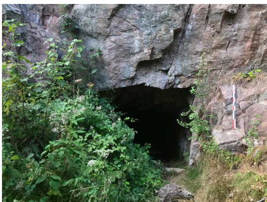
Figure 174 : Vue de l'entrée du tunnel 123 (M. Landolt).
