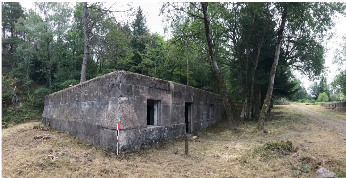
Figure 56 : Vue des façades nord-ouest et sud-ouest de la forge (J. Brangé).
