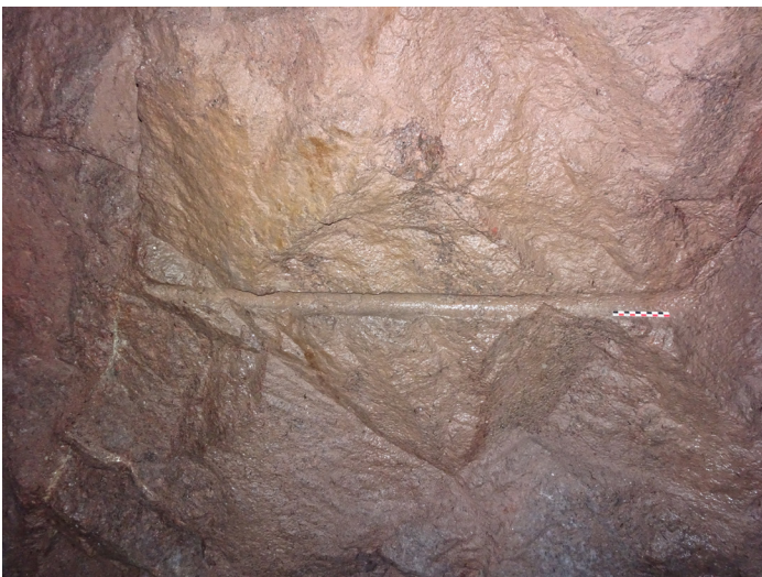
Figure 178 : Vue d'une trace de fleuret, tunnel 123 (M. Landolt).
