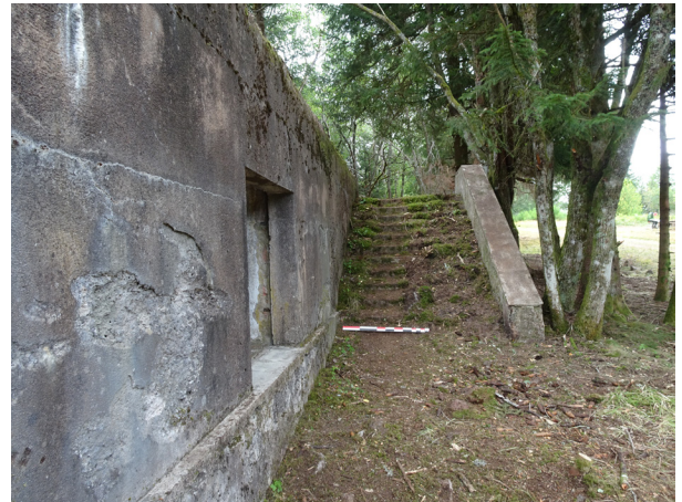
Figure 96 : Vue des escaliers de la coursive (J. Brangé).
