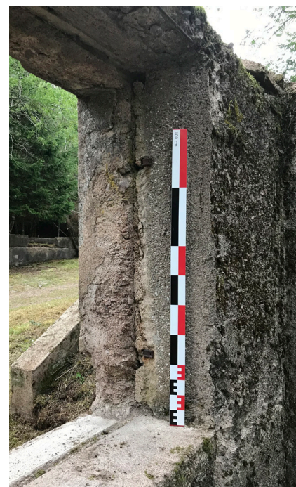
Figure 124 : Détail de la feuillure d'une fenêtre de la façade nord-est (J. Brangé).
