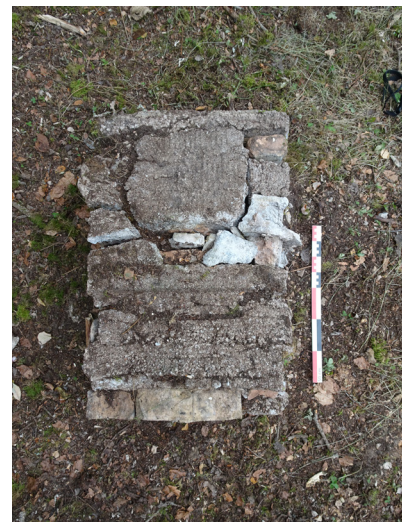
Figure 90 : Vue du socle en béton et briques (ELA 14) (J. Brangé).
