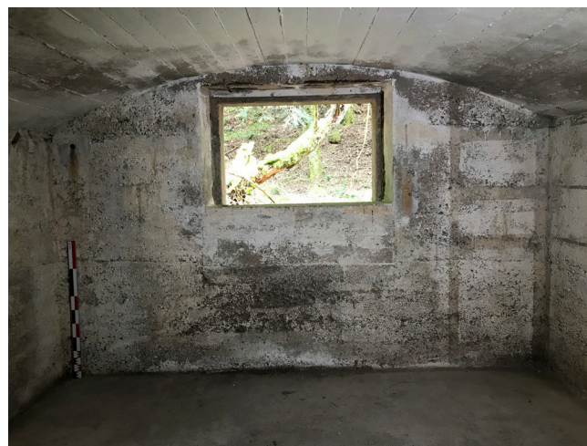
Figure 81 : Vue du mur nord-est (M. Landolt).
