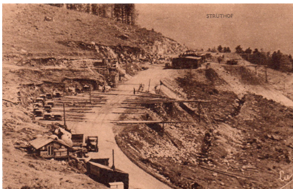
Figure 25 : Exploitation de la carrière au printemps 1942. On peut remarquer les rampes d'évacuation des déchets de taille ainsi que deux baraques (baraque cantine et baraque des gardiens) et des petites constructions temporaires probablement pour les ouvriers civils (NATZ19_PH_ARCH_001, carte postale édition Lucien Kohler, CERD).
