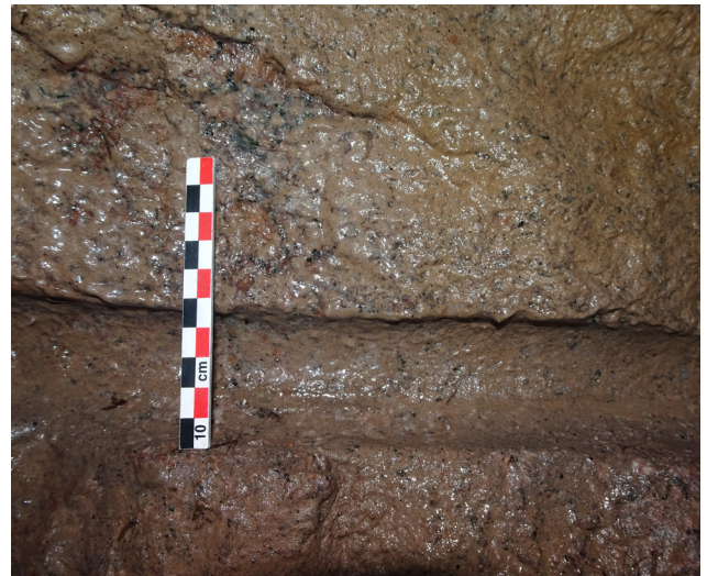
Figure 179 : Détail d'une trace de fleuret, tunnel 1 (M. Landolt).
