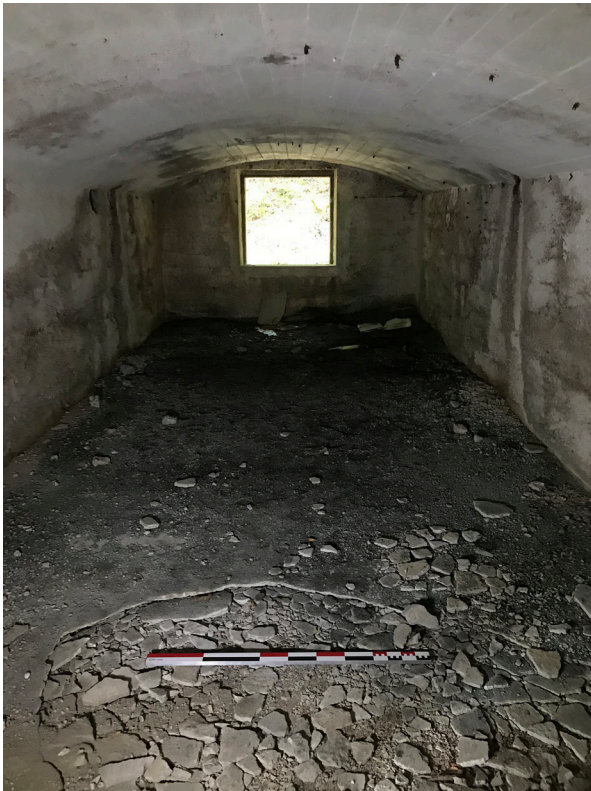
Figure 78 : Vue de la pièce 4 (M. Landolt).
