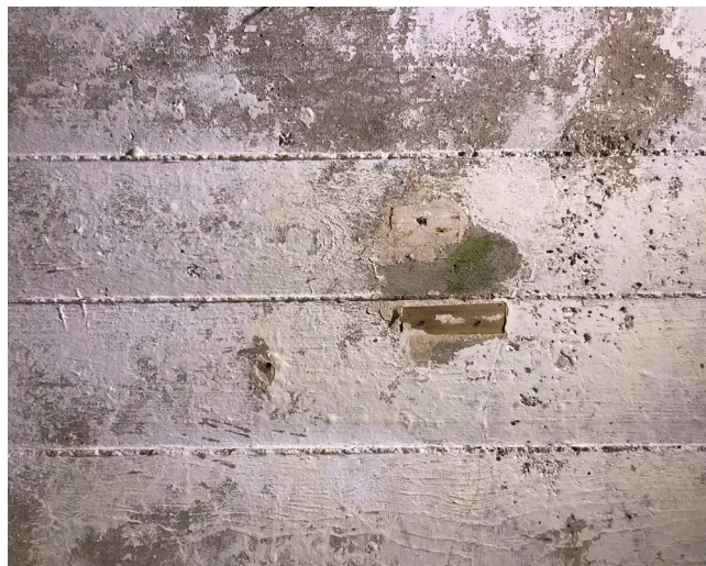
Figure 62 : Vue du plafond voûté de la pièce 1 (M. Landolt).
