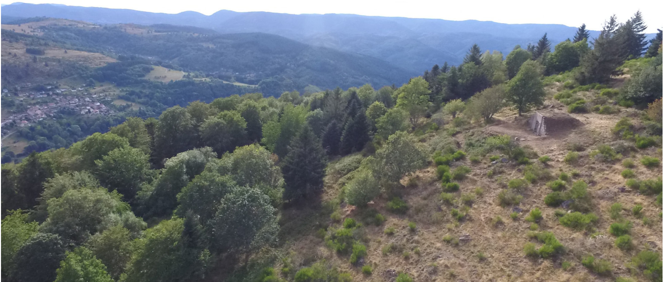
Figure 157 : Vue de la poudrière 098 dans la pente du Mont-Louise (S. Cuny).
