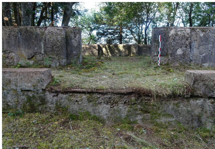
Figure 136 : Vue d'une des ouvertures dans le parapet de la coursive (M. Landolt).
