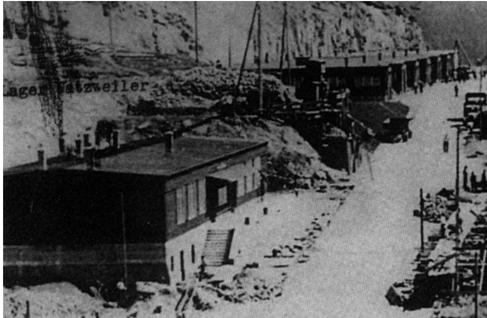
Figure 116 : Vue de la forge en août 1943. On peut décompter 6 cheminées sur son toit (NATZ19_PH_ARCH_093, CERD).
