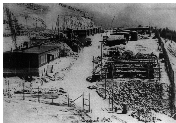
Figure 16 : Cliché de la construction de la baraque dépôt en août 1943 (NATZ19_PH_ARCH_093, CERD).
