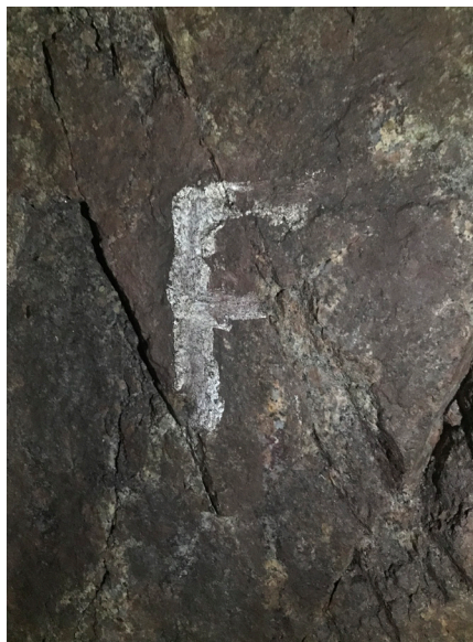
Figure 182 : Vue d'un marquage à la peinture dans le tunnel 123 (M. Landolt).
