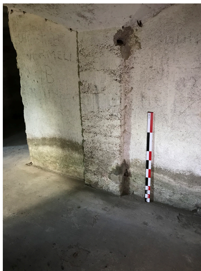
Figure 87 : Vue des emplacements des gonds d'une des portes du couloir (M. Landolt).
