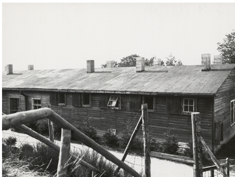
Figure 39 : Vue de la baraque bunker en 1951. On remarque les petites fenêtres avec barreaux correspondant aux cellules (NATZ19_PH_ARCH_282, Denkmalarchiv, DRAC Grand-Est).
