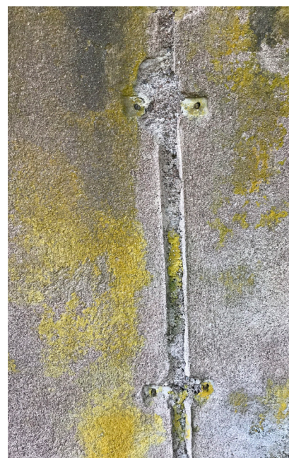
Figure 127 : Vue de détail de l'empreinte assimilée à une arrivée électrique (J. Brangé).
