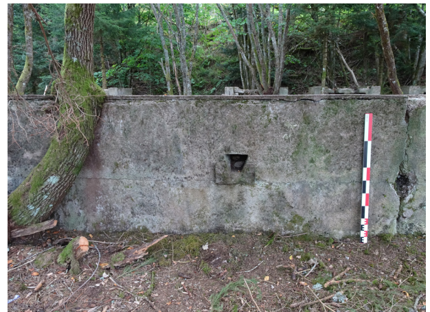
Figure 98 : Vue du système d'évacuation d'eau de pluie (J. Brangé).
