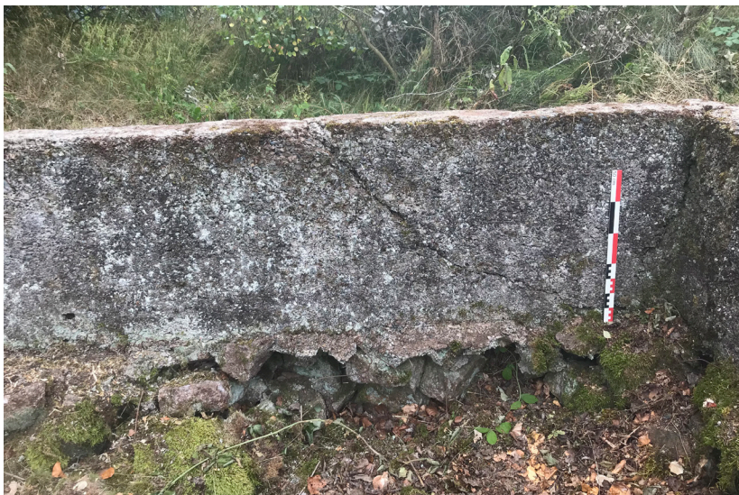
Figure 143 : Vue du mur périphérique et des blocs en granite composant la terrasse. Un arrêt de coulage est visible (trace en diagonale) (M. Landolt).
