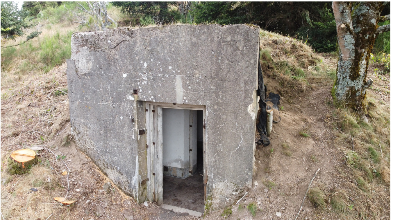
Figure 158 : Vue de la poudrière 099 (A. Vantillard).
