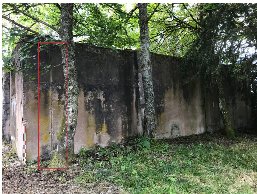
Figure 126 : Vue de la façade nord-ouest ; l'empreinte assimilée à une arrivée électrique est encadrée (J. Brangé).
