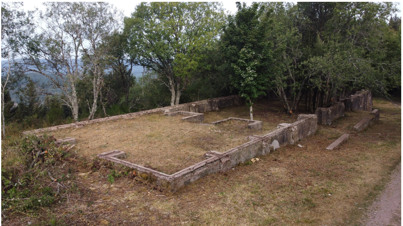
Figure 122 : Vue de l'intérieur du bâtiment dépôt (A Vantillard).
