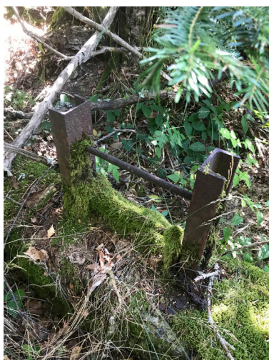
Figure 145 : Fixations métalliques de type 1, baraque des gardiens, ENA 108 (M. Landolt).
