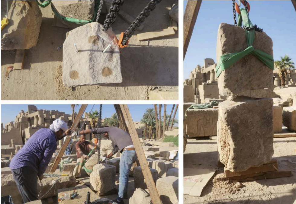
Fig. 17. Assemblage d'un bloc fragmenté par goujonnage (L. Antoine).
