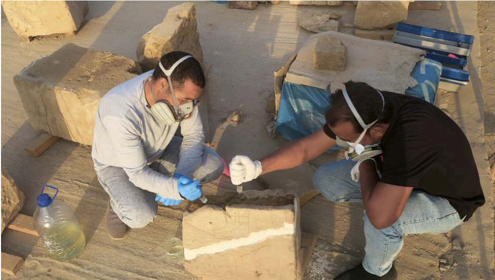
Fig. 15. Traitement d'une zone désagrégée par injection de silicate d'éthyle (L. Antoine).
