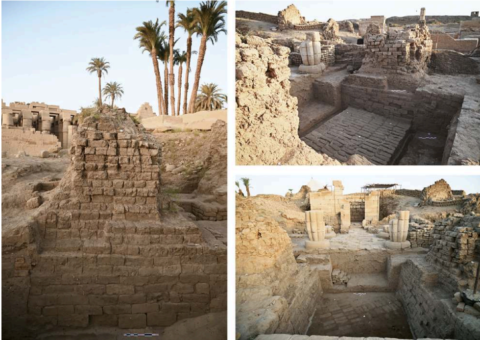
Fig. 7. Coupe transversale du môle sud (MR 601) du pylône, fondations de la chapelle d'Osiris Ounnefer et vue des niveaux antérieurs (C. Giorgi).
