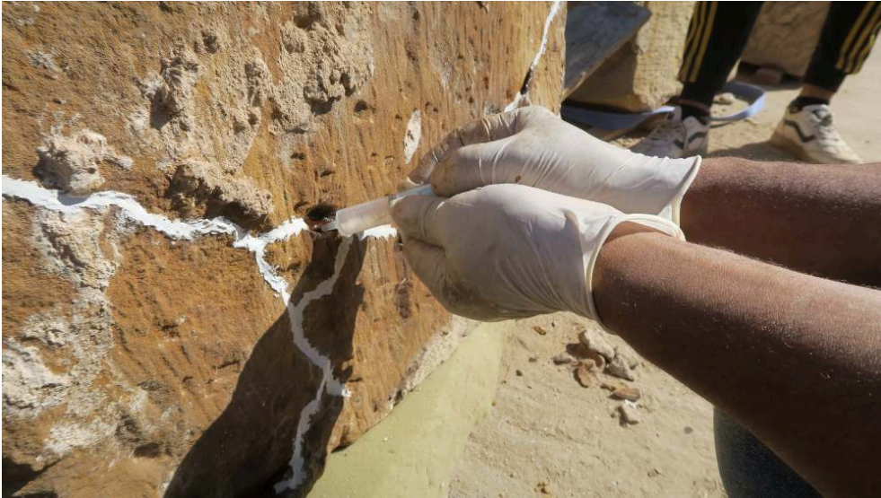
Fig. 19. Injection de résine dans un réseau de fissure (L. Antoine).
