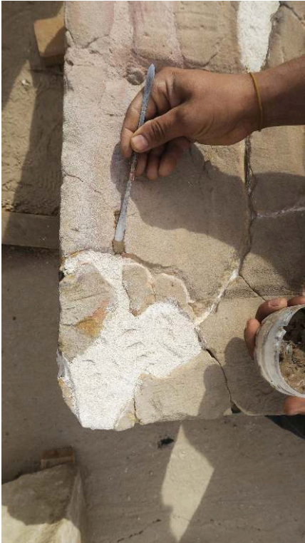
Fig. 21. Comblement des fissures à l'aide d'un mortier à base de chaux et de sable (L. Antoine).
