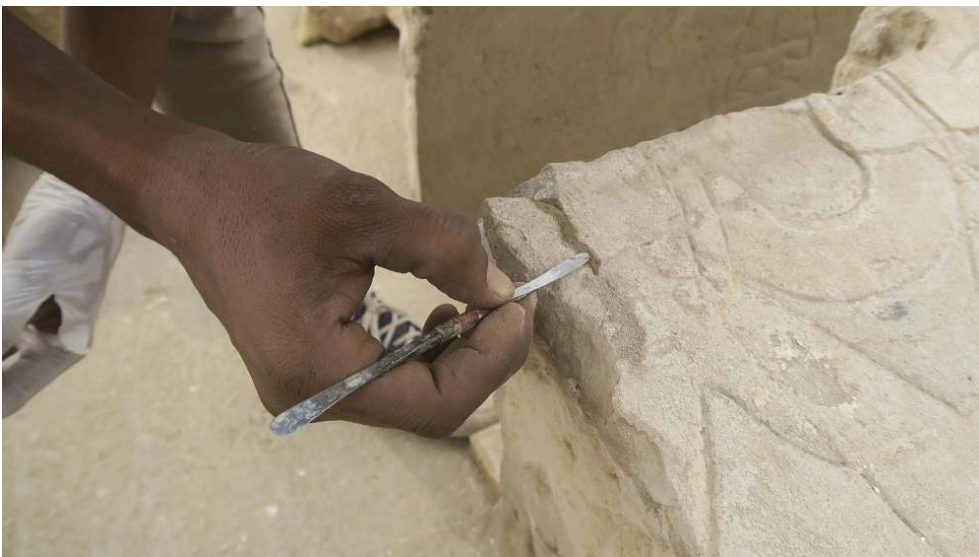
Fig. 20. Comblement des fissures à l'aide d'un mortier teinté (L. Antoine).
