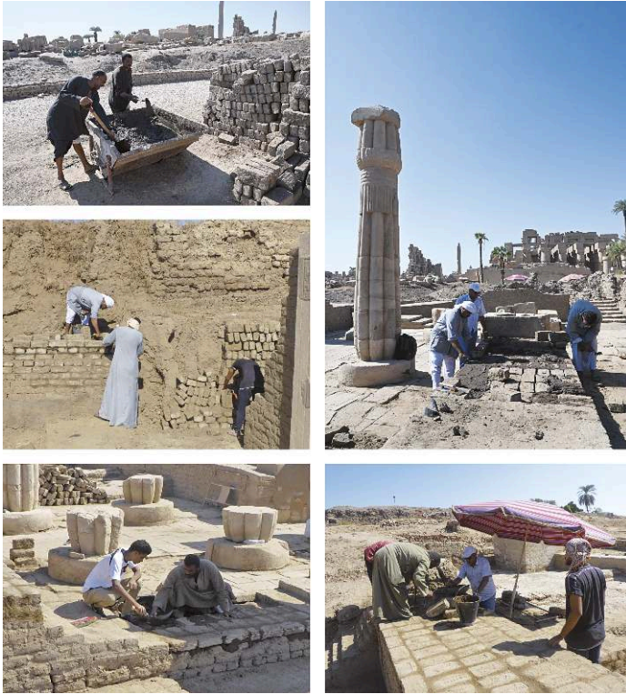
Fig. 3. Préparation de la mouna (mortier), consolidation et rehaussement des murs en briques crues de la chapelle d'Osiris Ounnefer Neb djefaou (C. Giorgi).
