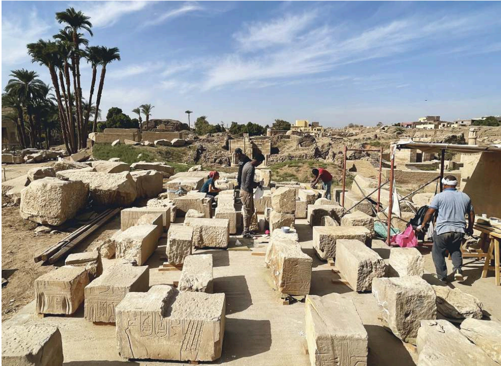
Fig. 14. Vue générale du chantier de restauration (L. Coulon).
