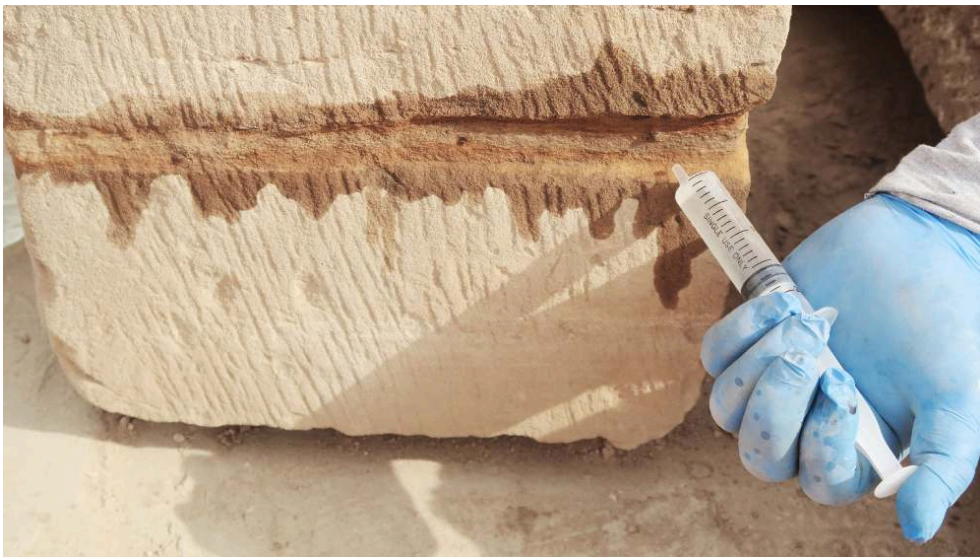
Fig. 16. Détail du traitement par injection de silicate d'éthyle (L. Antoine).
