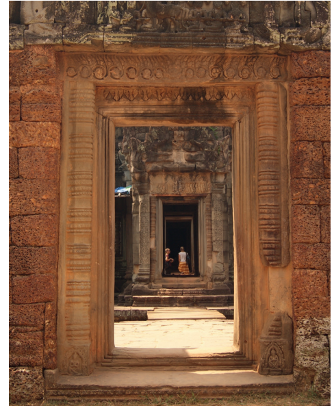
Figure 14c. — Encadrement de la porte II est, face est, Banteay Samrae, 3 e quart du XII e siècle, province de Siem Reap, Cambodge. Cliché de l'auteur, 2017.
