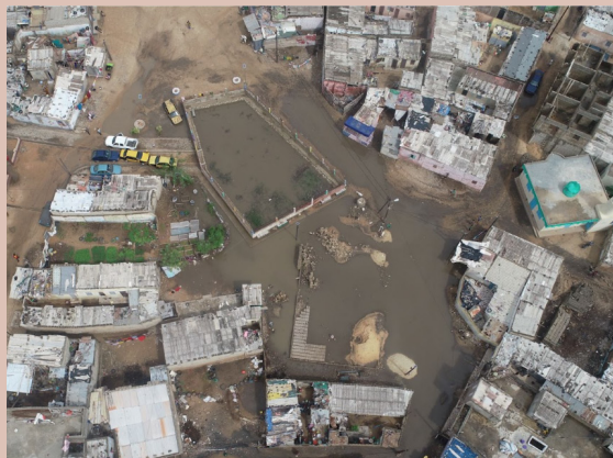
Vue aérienne de l'inondation à Dakar en 2007
