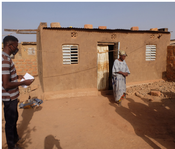
Reconstruction post-inondation financée avec le fonds habitat
