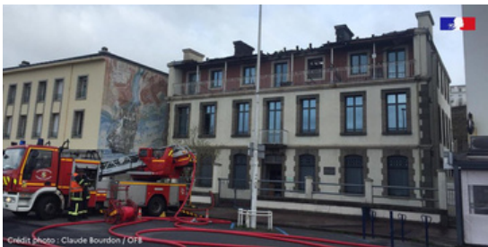
Pompiers intervenant suite à l'incendie des bureaux de l'Office Français de la Biodiversité à Brest (Bourdon / OFB, 2023)
