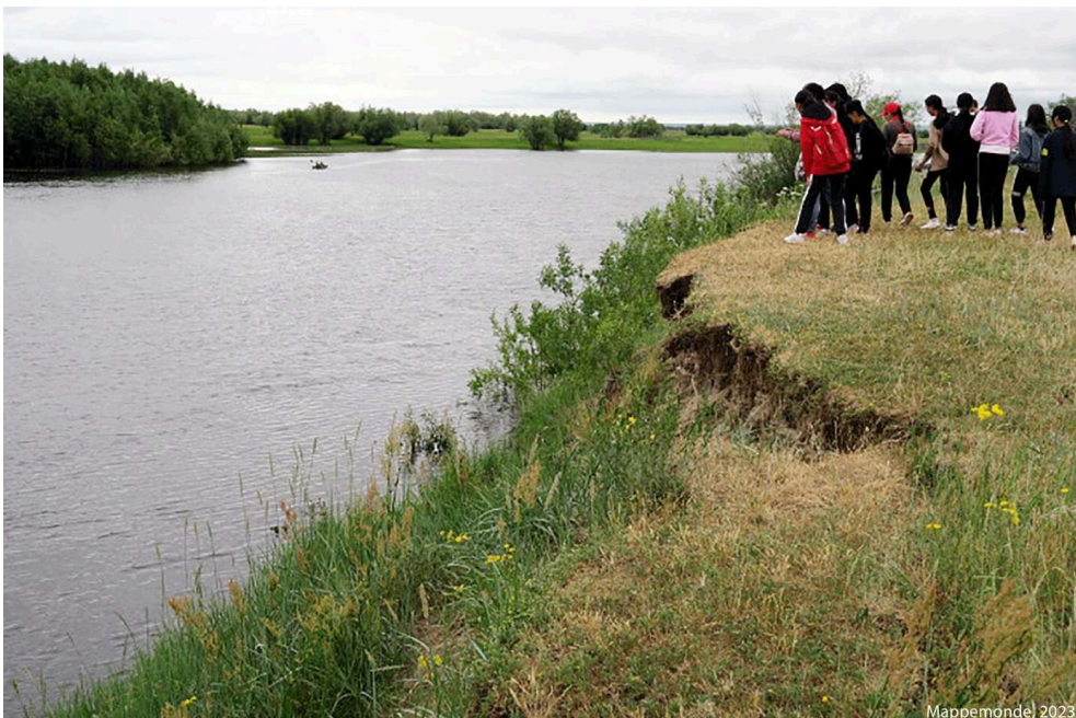
Photo 3. Érosion des berges
