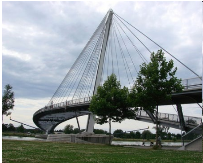
La passerelle des Deux Rives de l'agence M. Mimram. Source : A. Beyer, L'Institut Paris Region
