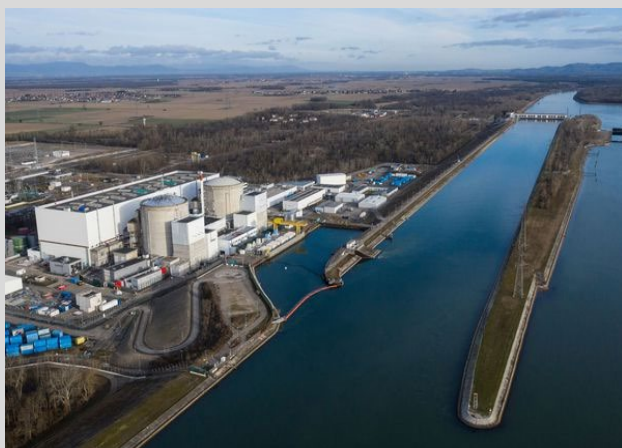
Centrale nucléaire fermée de Fessenheim. Source : Sébastien Bozon, 2020.
