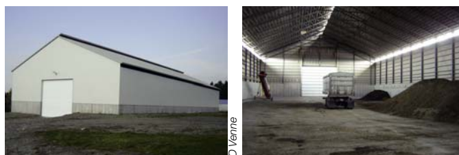
Fig.8.2 & 8.3: Entrepôt de fumier aviaire au Canada. Aspects extérieur et intérieur.
