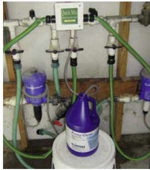
Fig.81.21: Nettoyage des conduites avec une solution de peroxyde d'hydrogène (ProxyClean).
