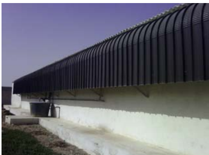
Fig.7.17 & 7.18: Échangeur d'humidité (cooling). Aspect vu de l'extérieur avec récupération partielle de l'eau et détail du côté intérieur.
