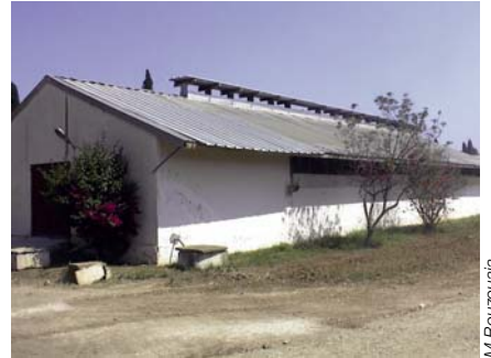
Fig.7.12: Bâtiment fermé à ventilation dynamique.
