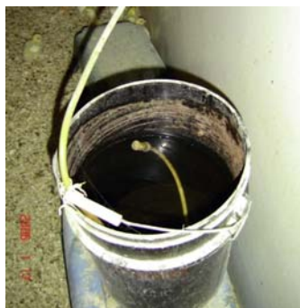
Fig.81.7: Le matériel sale est le meilleur moyen pour faire entrer les bactéries dans les conduites d'eau.
