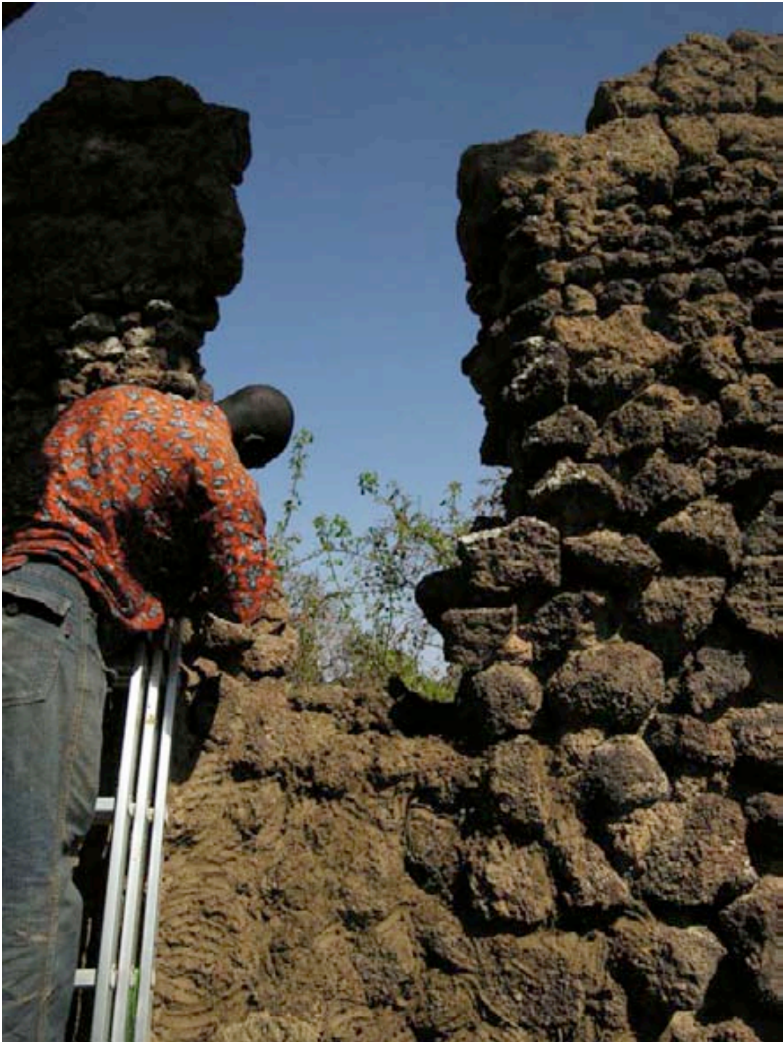
Traitement des fissures
