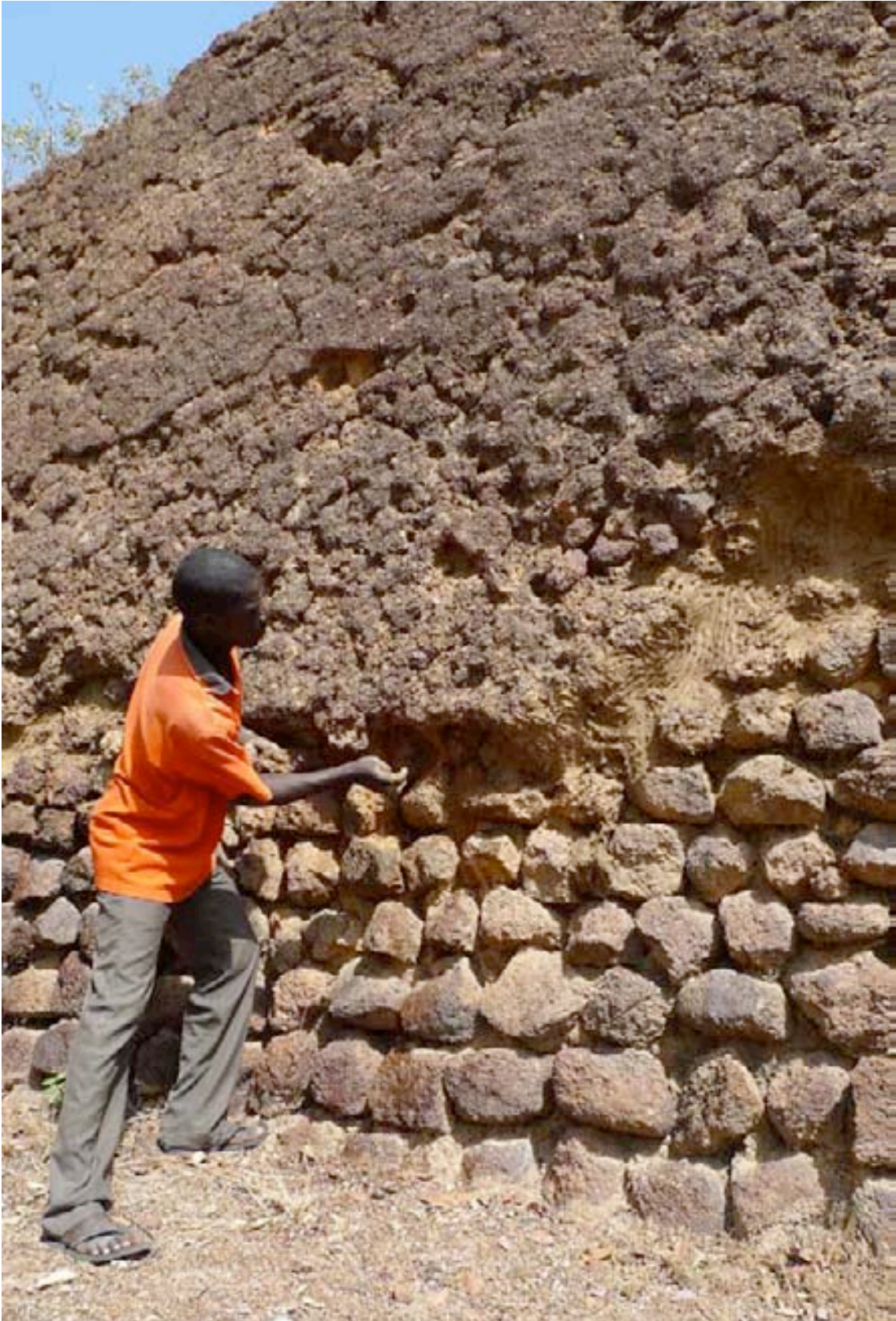
Stabilisation des enduits en terre
