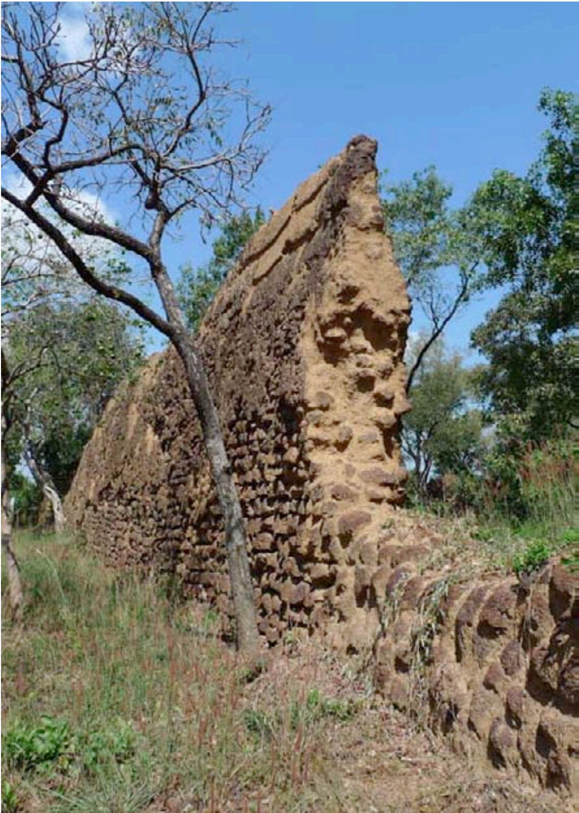
Traitement des arrachements de murs
