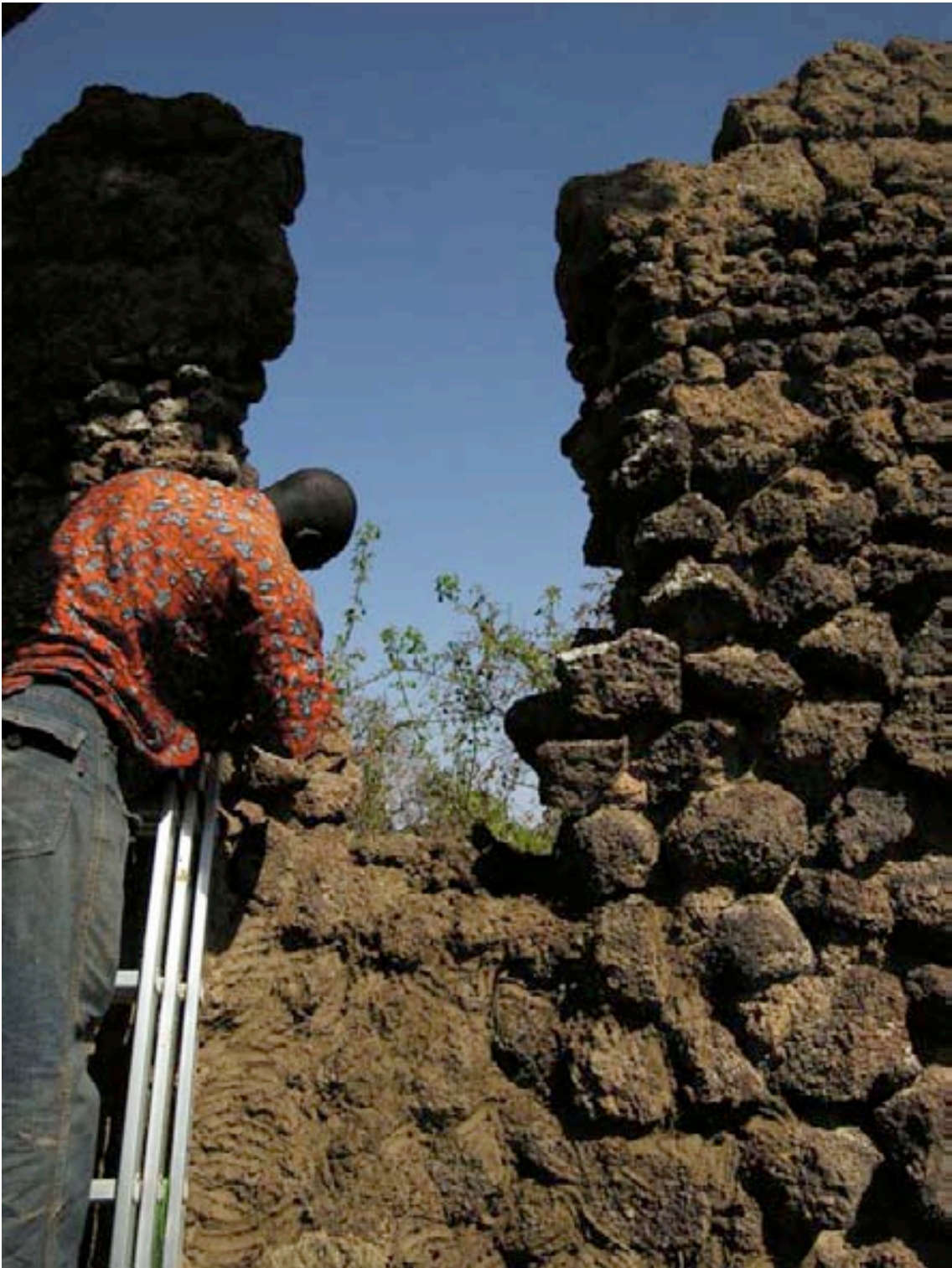
Traitement des fissures
