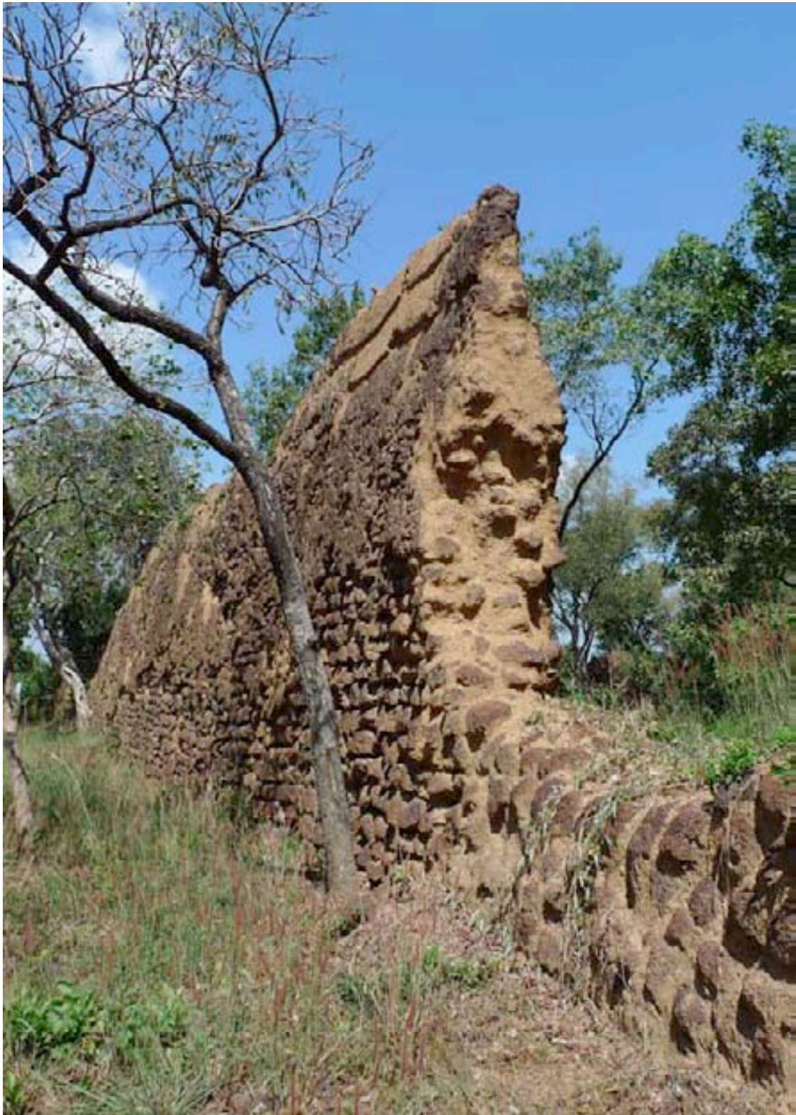
Traitement des arrachements de murs
