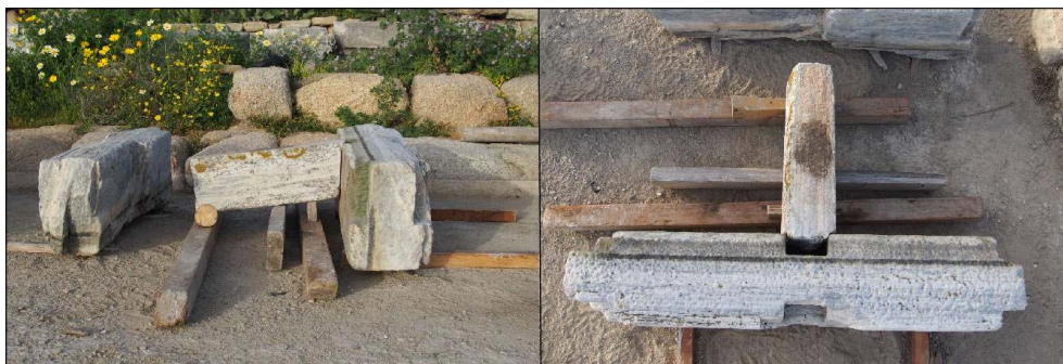
Fig. 12. Remontage au sol du chevron N1 dans le faitage B17.
