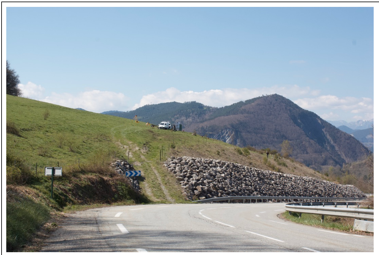
Photo 10 : Les travaux de confortement du site de Charlaix réalisés par le DIR
