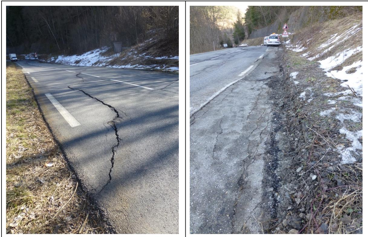
Photos 8 et 9 : Exemples de déformations de la RN 85 liées au glissement de Corps
