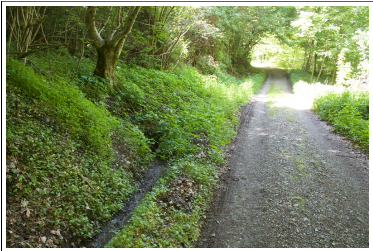
Photo 7 : Une rigole entretenue par un habitant dans une logique préventive (source : Géoportail)
