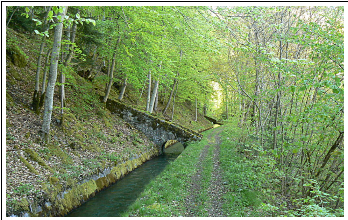
Photo 6 : Vue du canal du Beaumont (source : Maurice Séchier)
