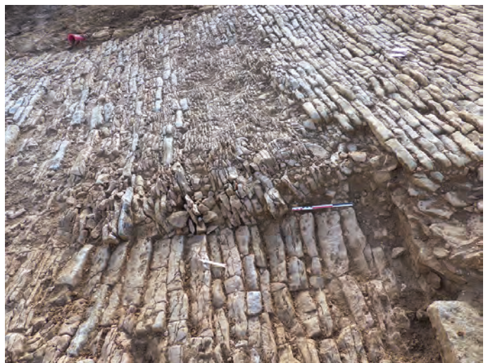
Fig.38 Vue de détail des pierres fragmentées de la rampe © CI,FD
