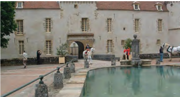
Fig.131 Pediluve du Château-Bazoches (58)
