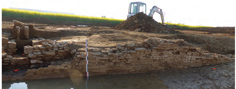
Fig.41 Vue générale vers le sud, du mur US.107. Au second plan, le système de vidange du bassin est bien visible, ainsi que la rampe d'accès, à l'arrière-plan © Cl.FD
