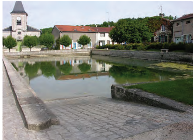
Fig.128 Koeur la Petite Meuse (57). Le plan incliné de cette structure ne possède pas de système anti-glissade.
