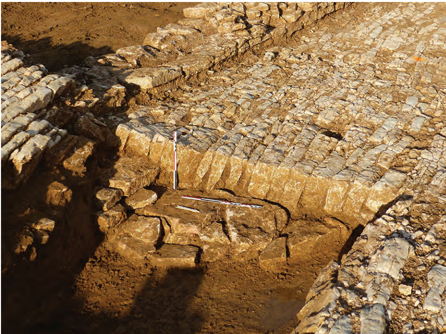
Fig.50 Le démontage manuel d'une partie de la rampe a permis de mettre au jour la technique de mise en place du « pavage » du fond du bassin. Il est possible de constater la grande qualité de l'ouvrage... © Cl.FD
