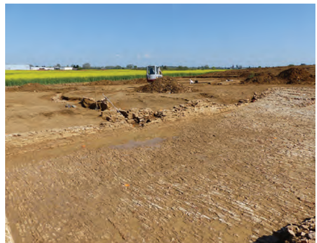
Fig.45 Vue générale du fond du bassin, vue vers le sud-est
