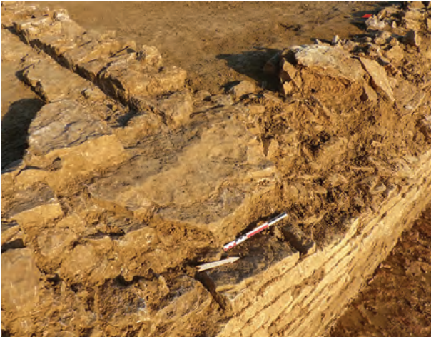
Fig.68 Vue de détail de la connexion entre la conduite Us.121 et le mur Us.101 © ci. sv
