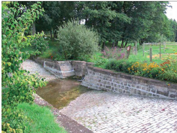
Exemple de « guéoir » à Gadancourt (95) – XVII e siècle (cliché - Inrap)
