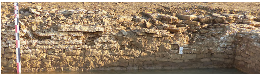
Fig.55 Tronçon du mur Us.119 et l'angle avec le mur Us.107 © CI.FD
