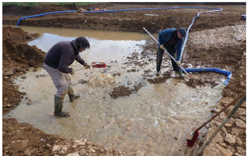
Fig.6 Nettoyage du bassin à l'aide d'une pompe en circuit fermé © Cl. F.Devevey.
