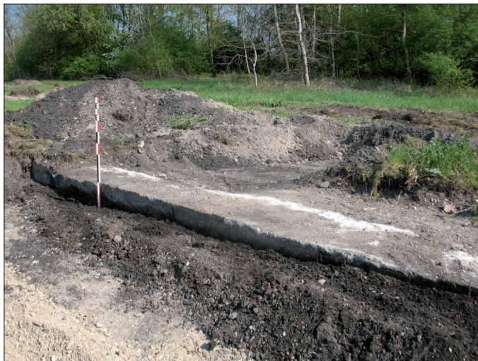
Fig. 43 Vue rapprochée sur le muret de bordure de quai sud (UF. 111-6). © F. Devevey
