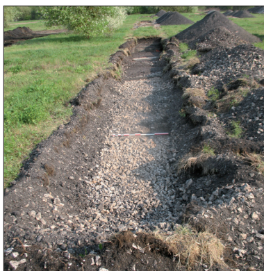
Fig. 53 Apparition du niveau de ballaste dans le sondage 56. © F. Devevey
