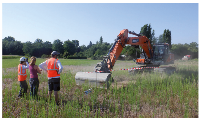
Fig.8 Décapage en cours du secteur 3 (Photo : J. Brenot)
