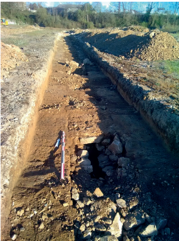
Fig. 37 Vue générale du dalot dans la tranchée 5. © F. Devevey, Inrap
