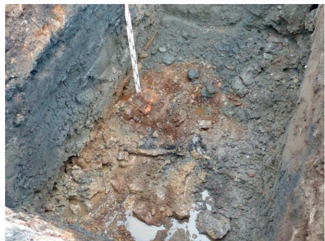
Fig.29 Pieux en bois (perturbés par la pelle mécanique dans l'empierrement de galets jointifs à -3,60m de profondeur). © F. Devevey, Inrap
