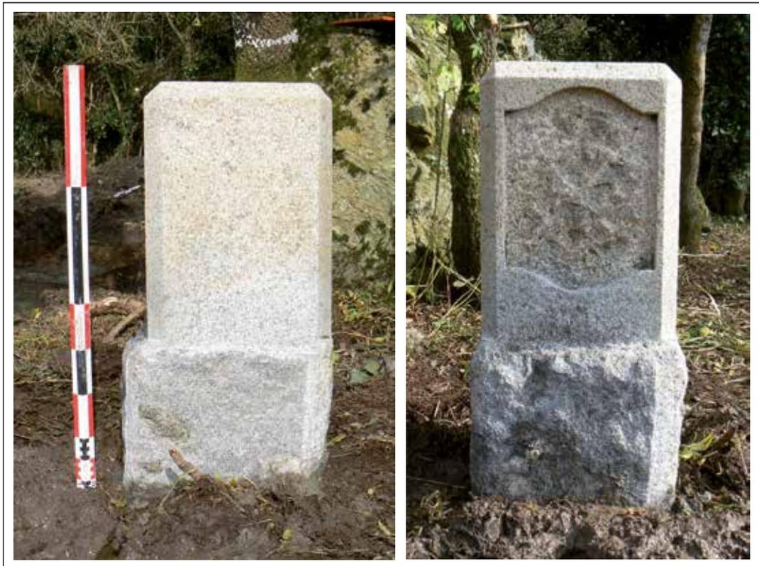
*Fig. 5 : Borne kilométrique et altimétrique en granite, fichée dans la digue de Port-Launay à Couëron (Loire-Atlantique). Milieu du XIX<sup>e</sup> s. (H. totale : 1 m ; partie visible : H. 0,58 m ; L. 0,40 m) [cl. E. Miejac].*
