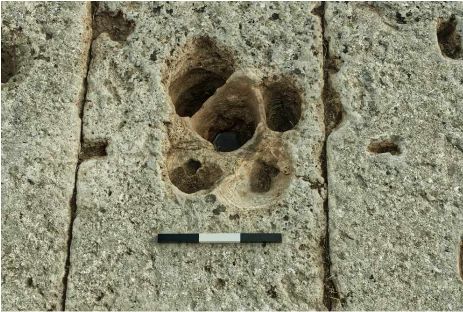
10 Fünf Vertiefungen in einem Fundamentblock des Tempels O. (Foto: H. Bücherl, Brandenburgische Technische Universität Cottbus-Senftenberg)
