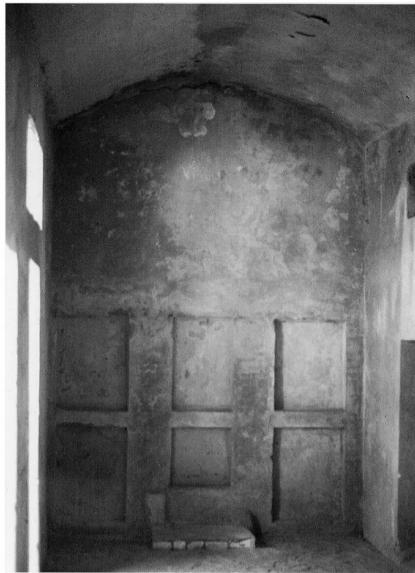
311 - La couverture taillée en forme de voûte surbaissée.
