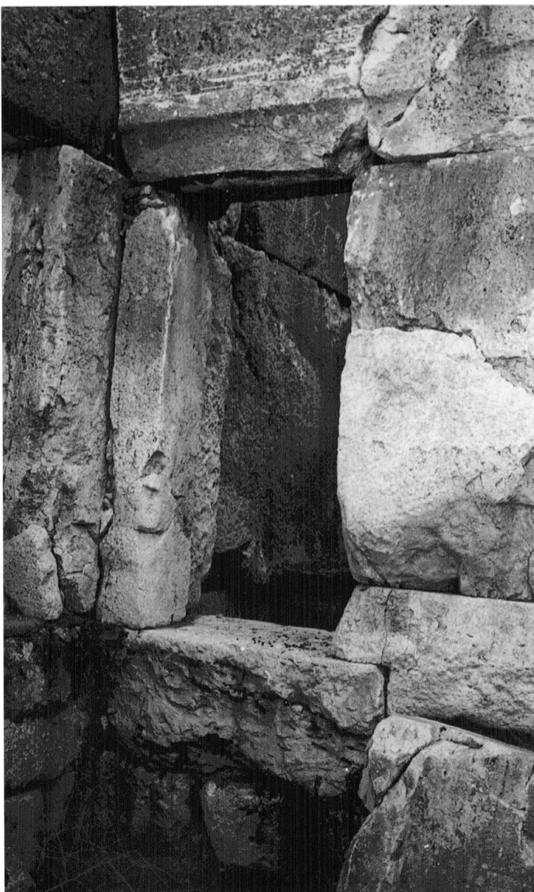
37 - La porte de l'escalier sud avec le net encastrement du piédroit 612 sur le seuil 611.
