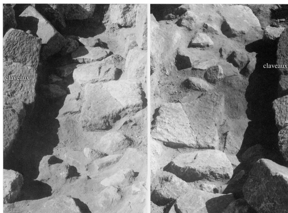
76 - Pièce 4, angle nord-ouest : les claveaux effondrés sur le dallage grossier qui recouvre le niveau d'incendie.
