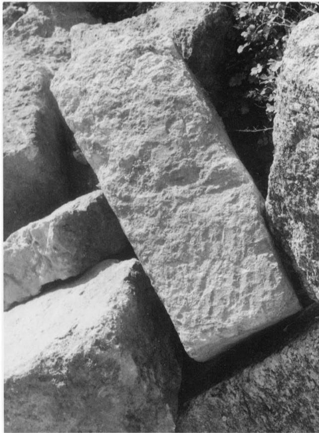
294 - Traces de taillant sur les claveaux en calcaire tendre.
