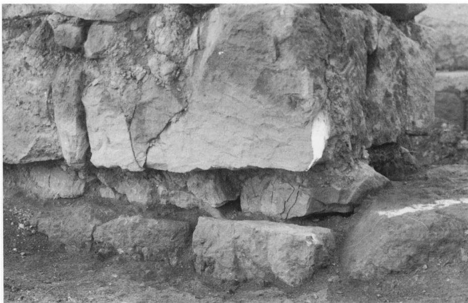
159 - Détail de la rainure dans le passage d'une baie.
