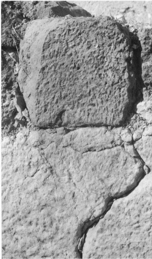
293 - Pièce nord, mur 2, face est : piquetage du calcaire au pic ou à la broche.
