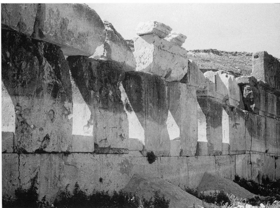
135 - Le mur 1 partiellement reconstruit.
