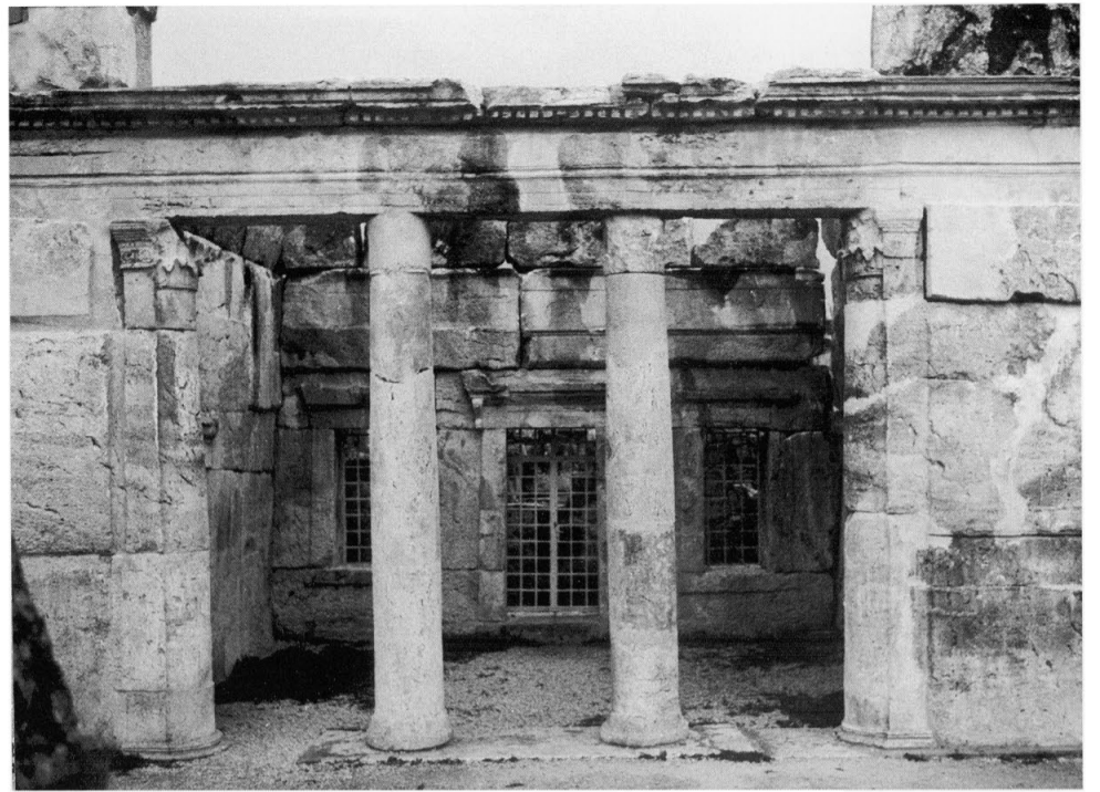
101 - Les deux colonnes in antis du vestibule nord.
