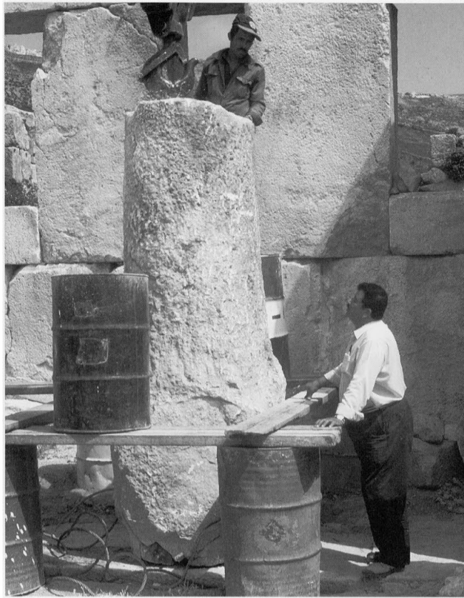
300 - Mise en place de la colonne 415 du vestibule sud.
