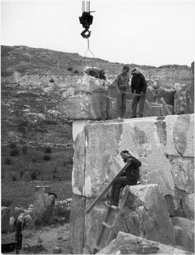
173 - La façade sud : mise en place du bloc d'angle 2311.
