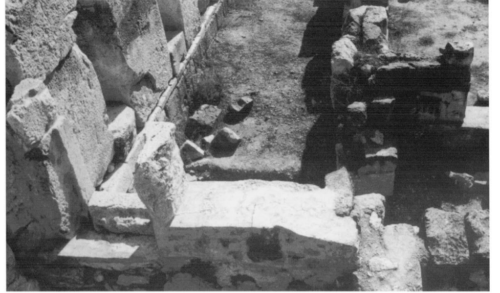
35 - La porte du mur 5' entre le réservoir est et le couloir est.
