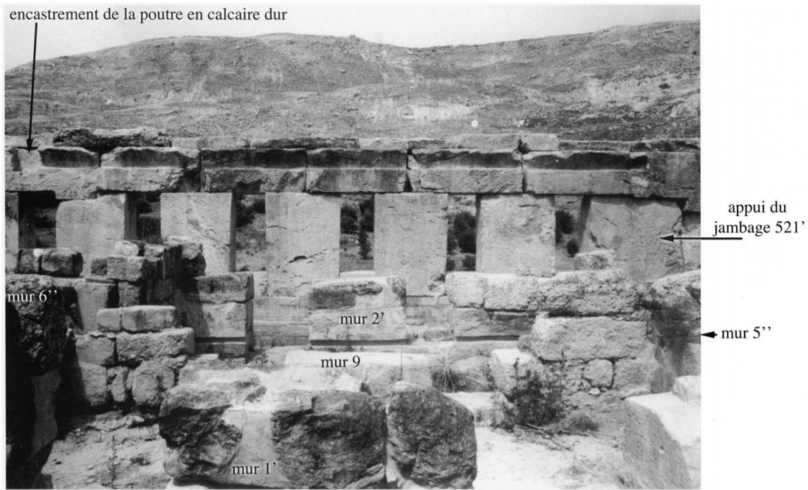
149 - Le parement interne du mur 2 montrant la longueur complète de l'encastrement des sommiers.
