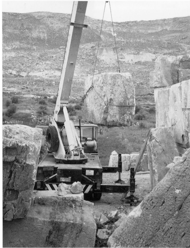
174 - Le levage du bloc 431.
