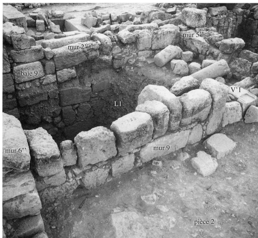
60 - Le mur 9 séparant la pièce 2 de la pièce 3 ; au fond, la baie 9 bouchée dans la face est du mur 2'.
