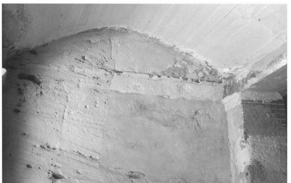
316 - L'architrave ionique est prolongée sous le tympan de la voûte surbaissée.
