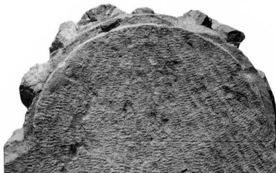
209 - Détail d'un trait de construction sur le lit de pose d'un chapiteau.
