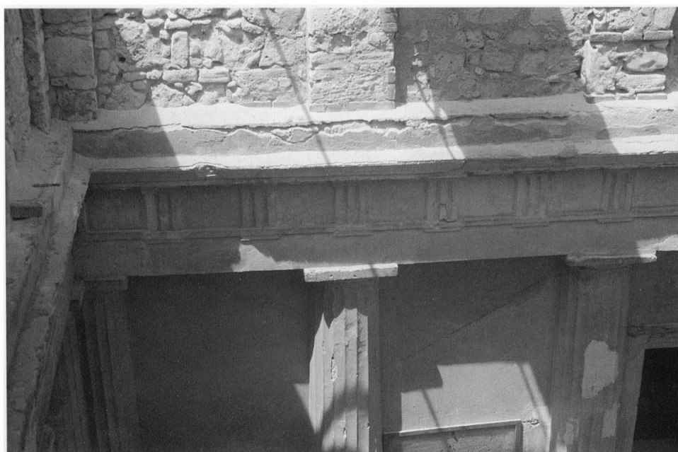
334 - Pilastres appliqués à l'aplomb des demi-colonnes appliquées.
