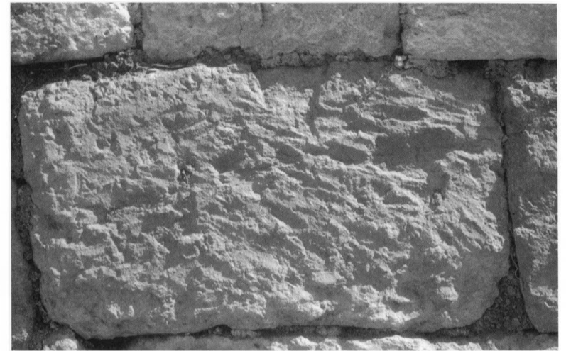
295 - Couloir est, doublage du mur 1 : traces de taillant sur calcaire tendre.
