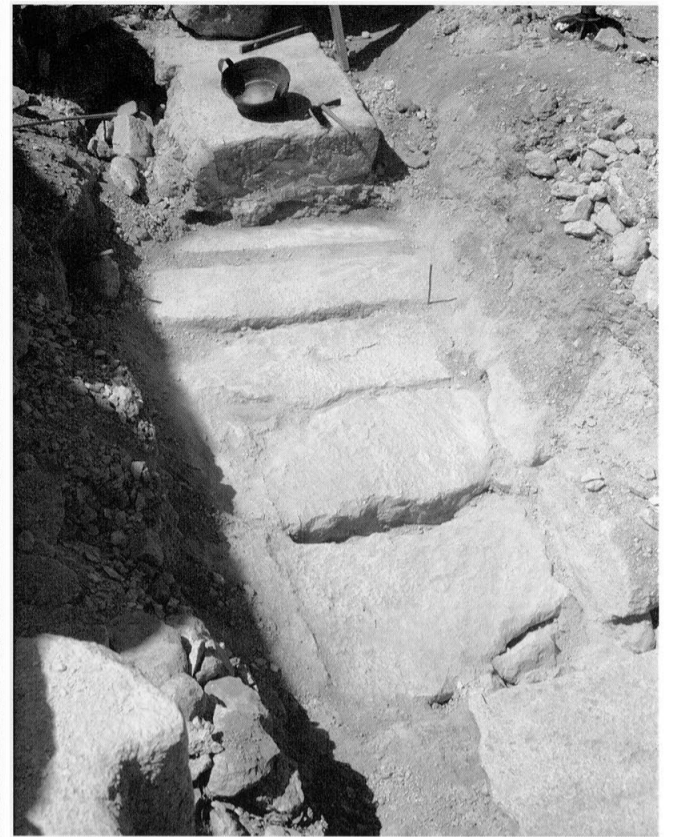
301 - Restauration de la fondation de la colonnade du vestibule nord.
