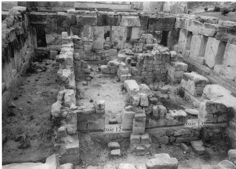
157 - Vue générale des pièces centrales montrant la rainure horizontale séparant la fondation de l'élévation des murs 5'' et 2'.
