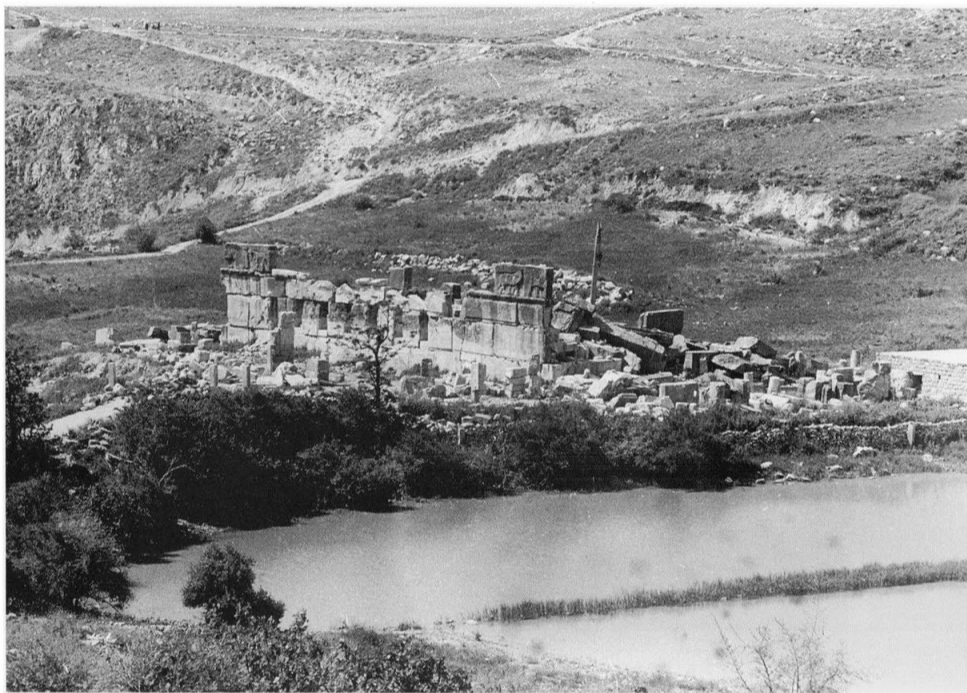
133 - La retenue des eaux de pluie devant la façade nord encore écroulée.
