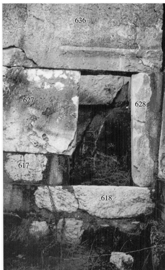
45 - La porte de la pièce sud-ouest : la mouluration en bosse du couronnement de chambranle.
