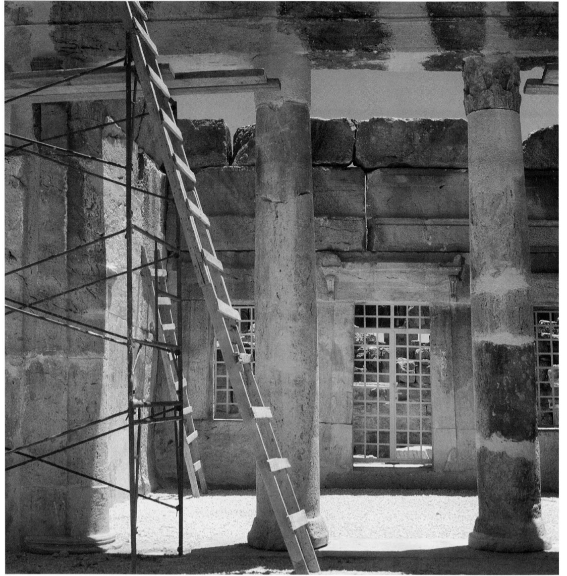
110 - Le vestibule nord : au fond, la porte d'accès à la pièce nord.
