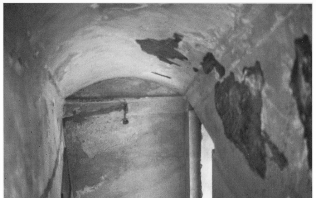
314 - L'architrave ionique sur laquelle repose la voûte surbaissée couvrant la volée unique de l'escalier.
