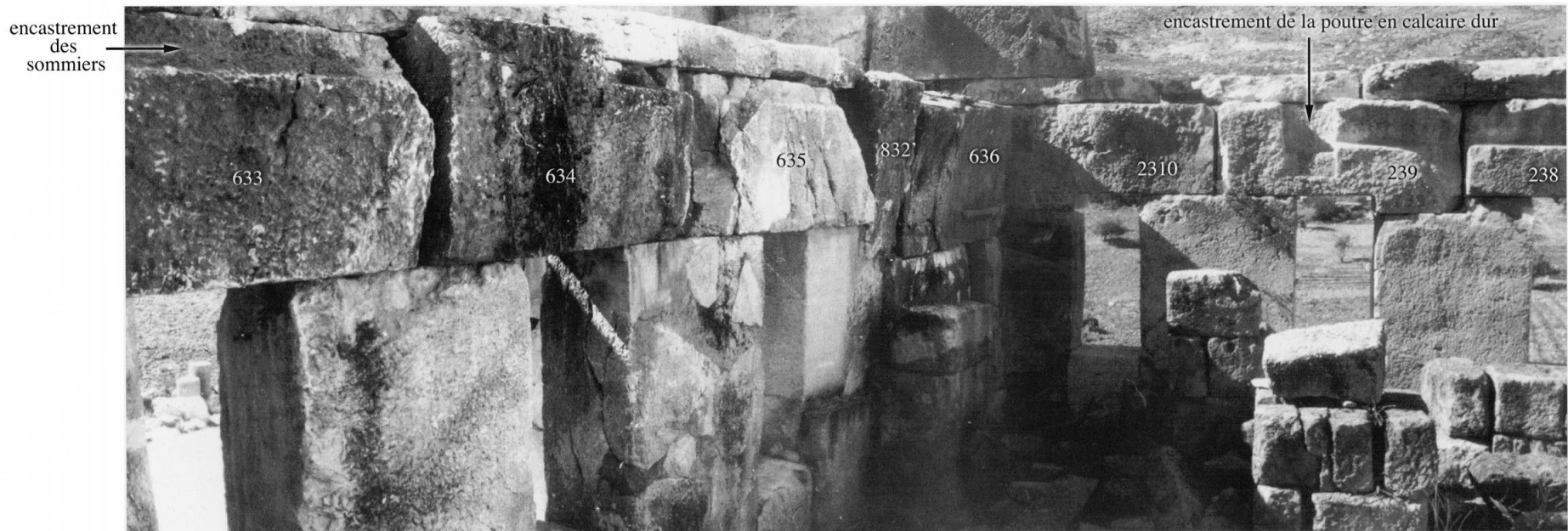
143 - L'appui des sommiers des voûtes, couvrant le couloir sud, dans l'assise 3 du mur 6.
