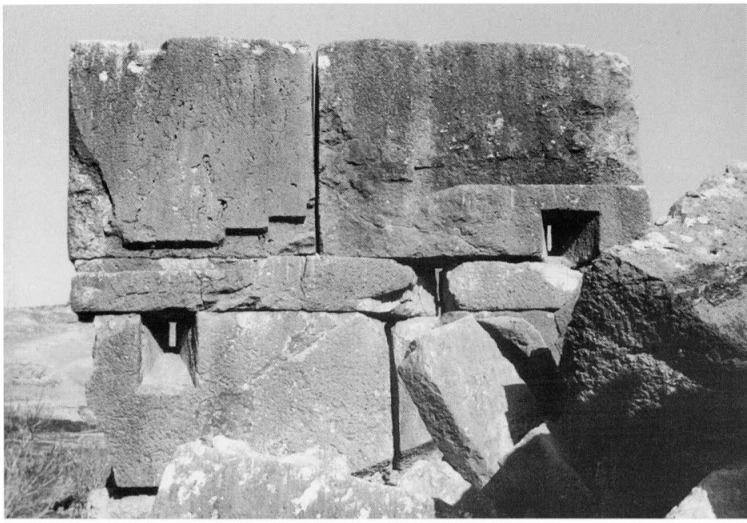
113 - L'escalier nord effondré.
