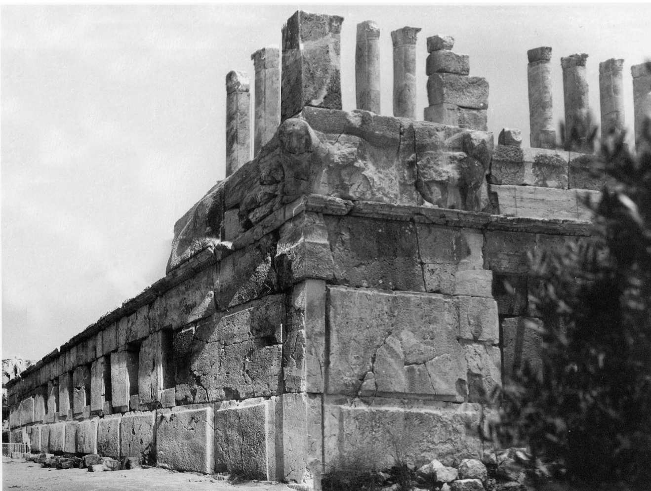
141 - L'angle de la façade sud et du mur 2, avec le chapiteau de pilastre en bosse.
