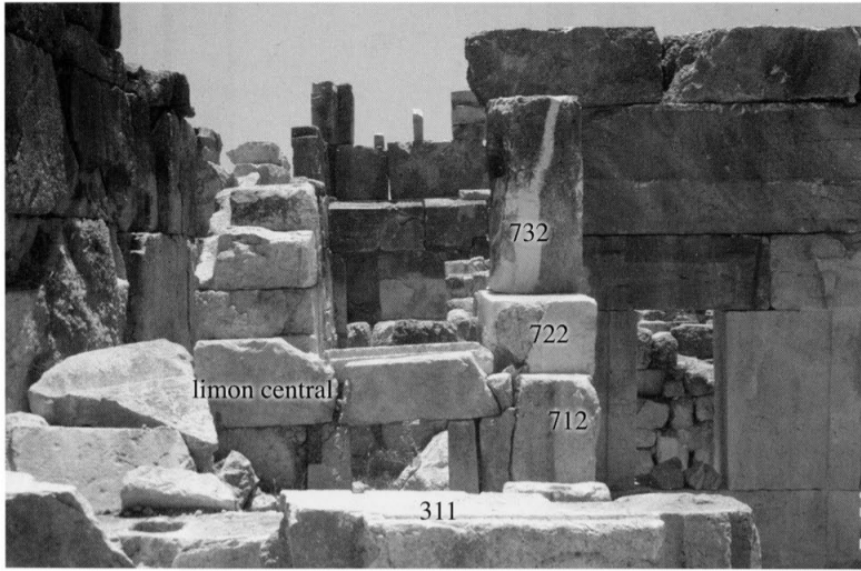
95 - L'escalier nord en cours de reconstruction.
