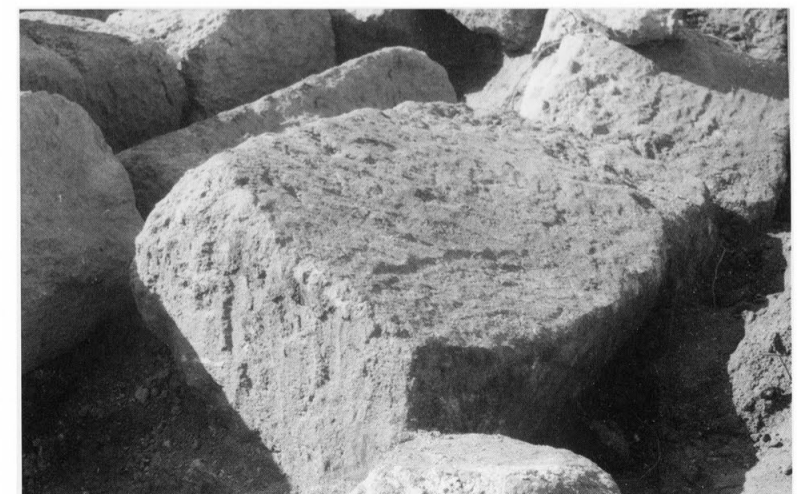
298 - Pièce 4 : traces de taillant sur les claveaux en calcaire tendre.
