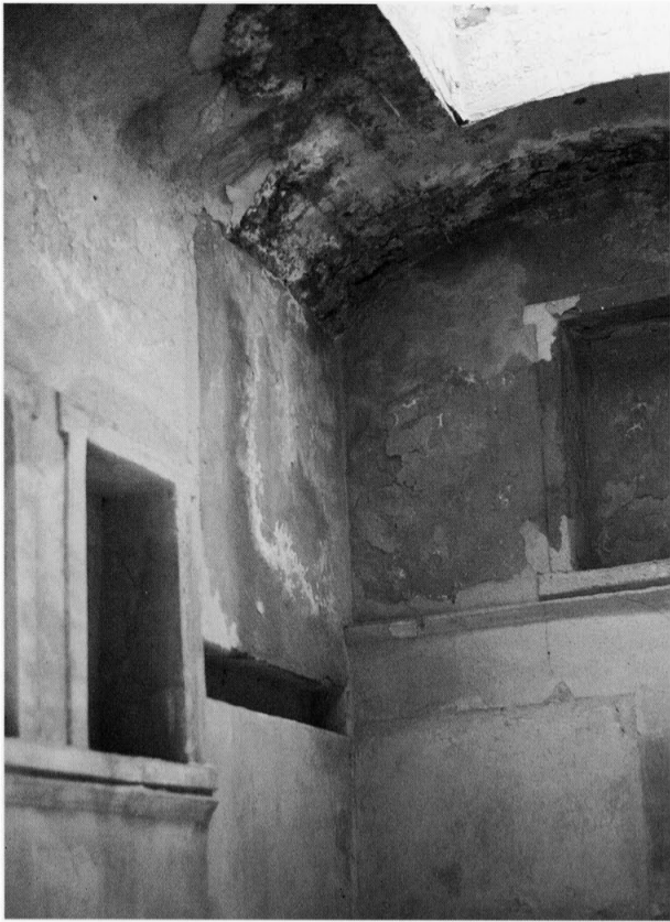
310 - La voûte surbaissée et les deux niches à chambranle dorique.
