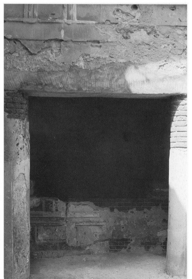
342 - Demi-colonnes d'ante adossées à un pilastre sans colonne intermédiaire.
