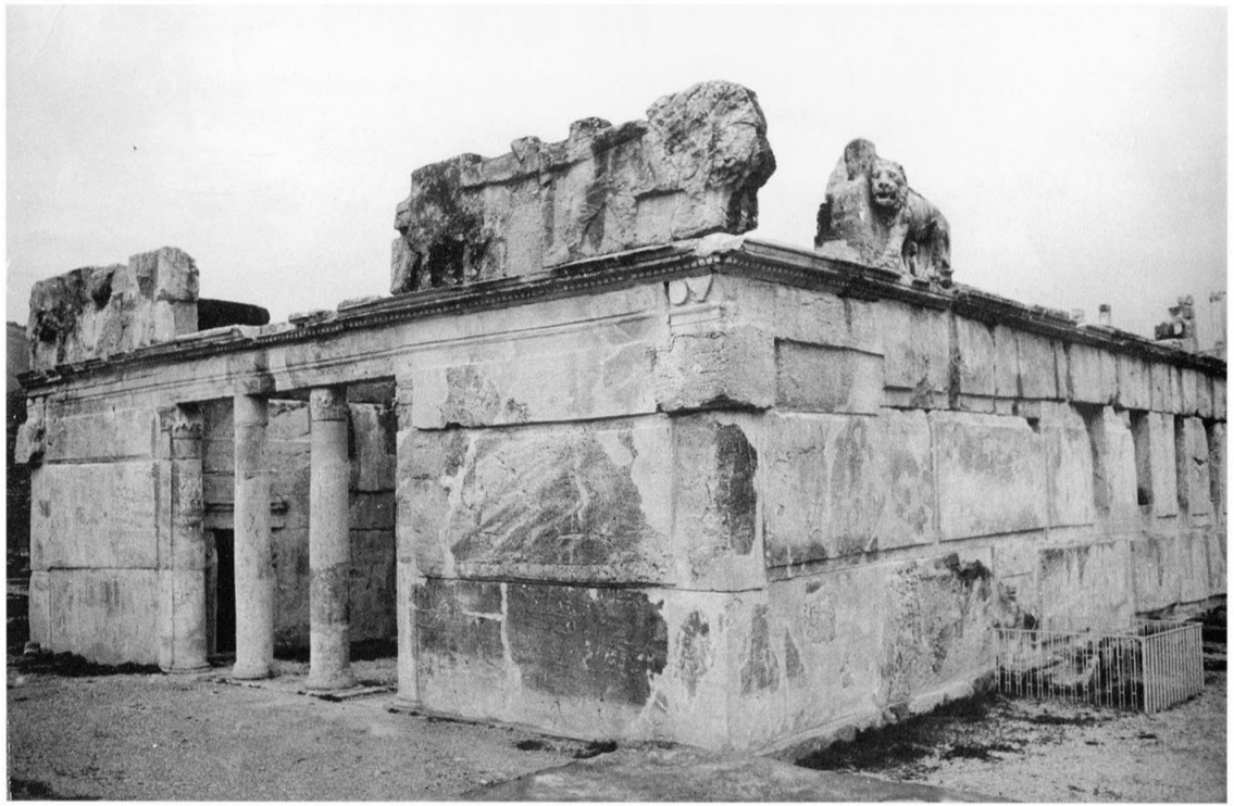
98 - La façade nord reconstruite.
