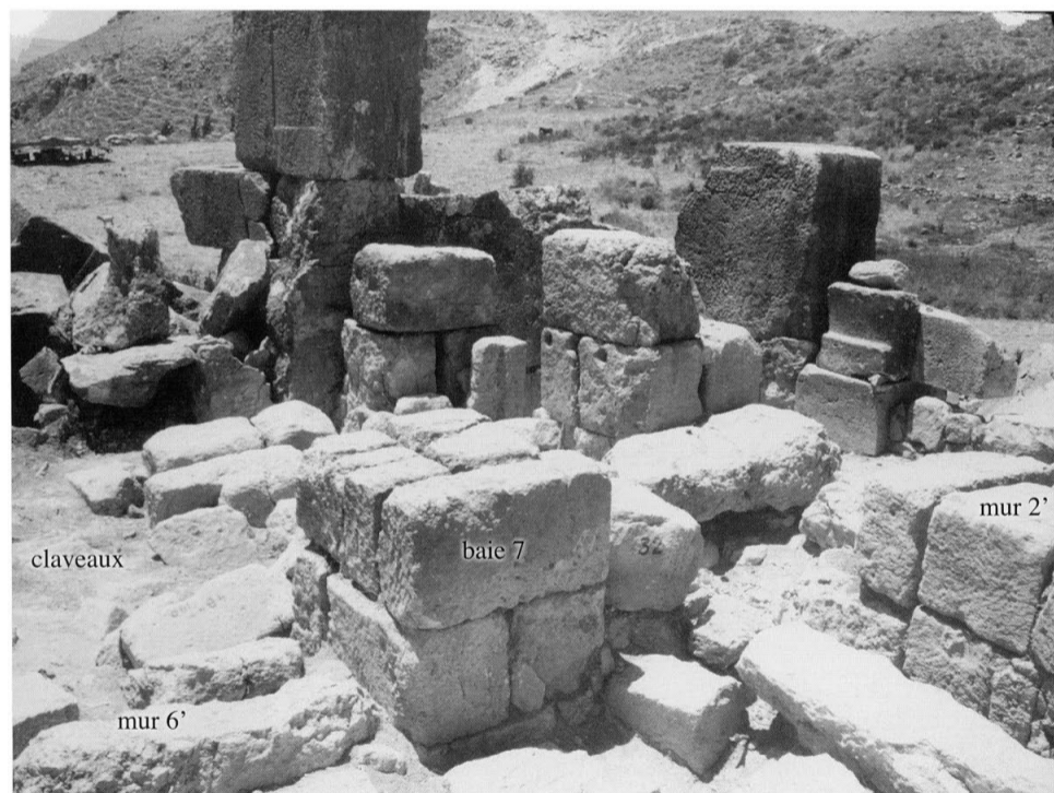
67 - En bas, la pièce 4 ; au fond, les claveaux effondrés dans le couloir sud avec les piles de renforcement.
