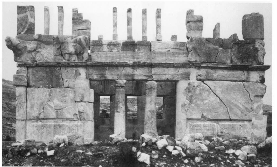
140 - La façade sud.
