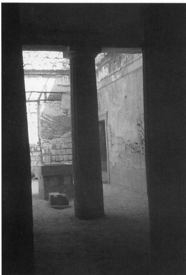
340 - Vue du vestibule sur la cour avec, à droite, la porte de l'escalier.
