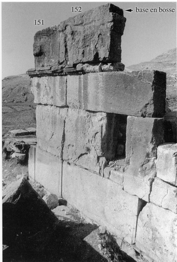
131 - L'extrémité sud du mur 1 avant sa reconstruction.
