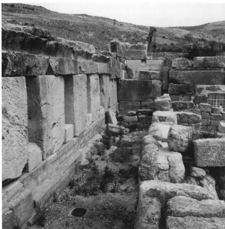
153 - Le couloir ouest vu du sud ; l'angle des murs 2 et 5 ; l'engravure d'encastrement des sommiers dans l'assise 3 du mur 2.
