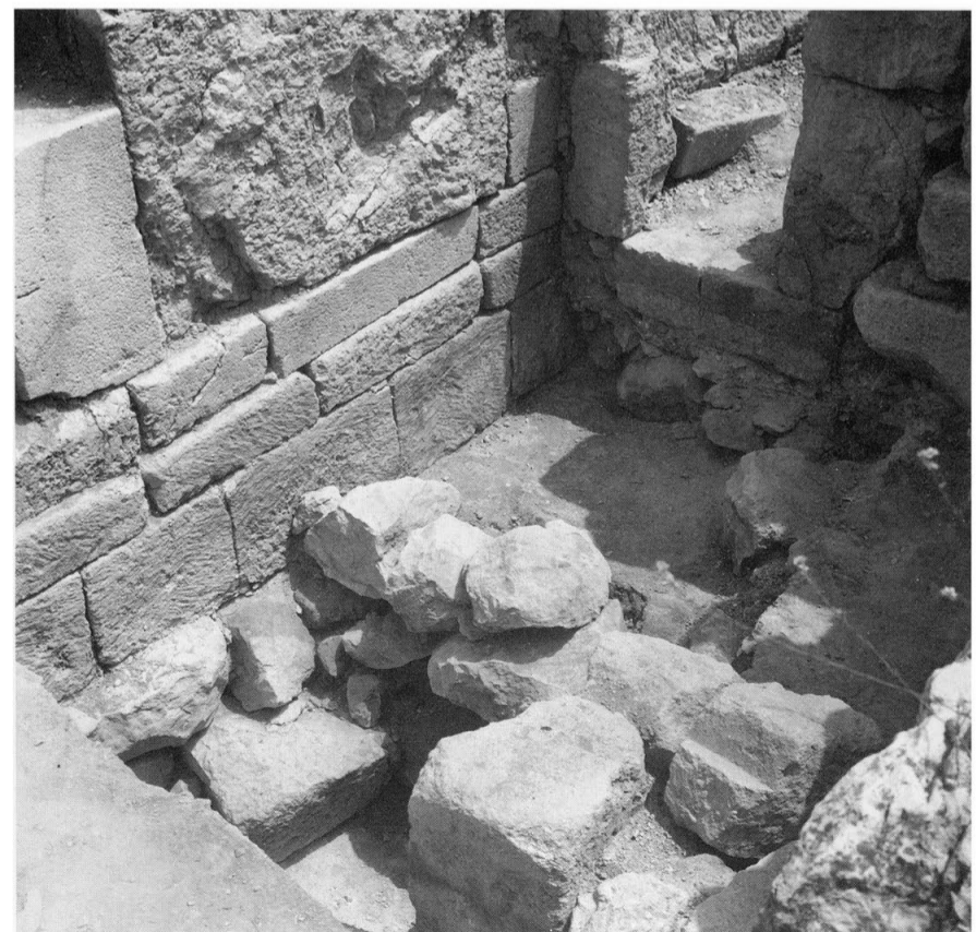
28 - Sondage 2 : les trois assises doublant l'assise 1 du mur 1 ; la grossière fondation transversale ; en haut, la porte du mur tardif 10.
