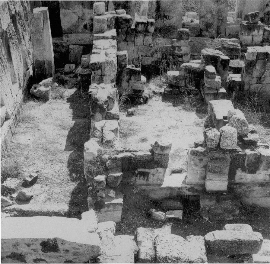
34 - Vue du nord vers le sud du couloir est et des pièces 1 et 2.
