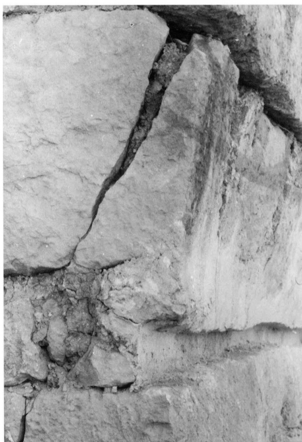
84 - Le couloir ouest : le tableau de la baie 9 dans le mur 2' du bloc interne ; les blocs éclatés au-dessus de la rainure vidée de son chaînage en bois.
