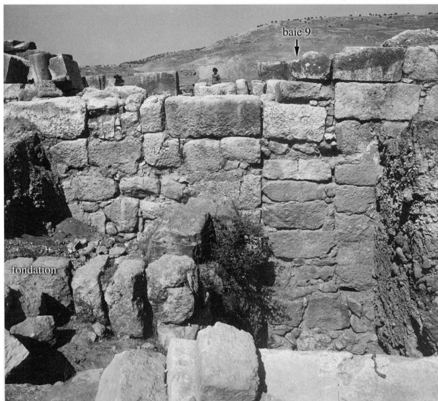
40 - Sondage L2 : la baie 9 bouchée dans la face ouest du mur 2' ; à gauche, la fondation en place des trois assises de doublage de l'assise 1 du mur 2.
