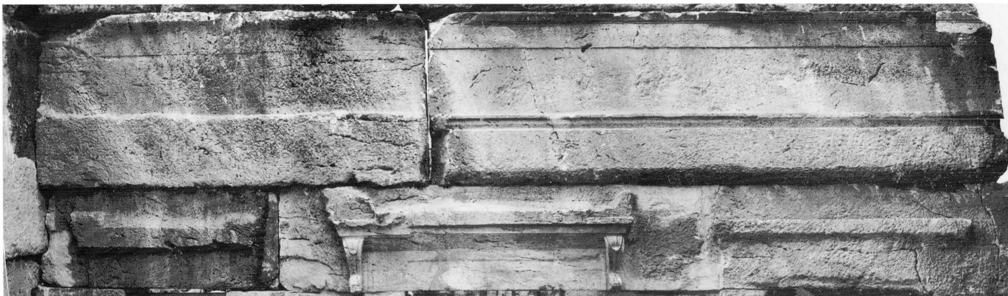
107 - Les linteaux 533 à 535 des baies du mur 5 ; les moulures de couronnement sculptées sur les blocs 542 et 543.
