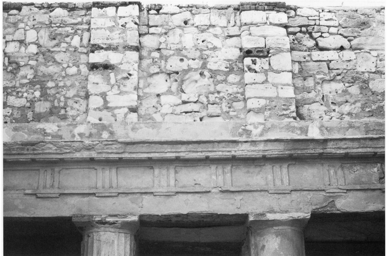
320 - Pilastres appliqués à l'aplomb des demi-colonnes d'un ordre dorique appliqué.
