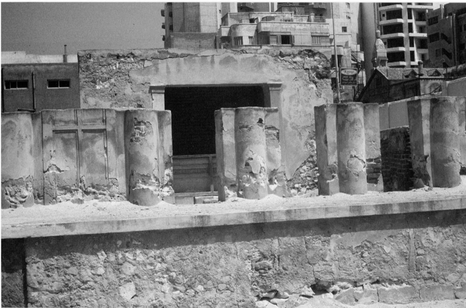
352 - Fausses fenêtres et passages entre les demi-colonnes appliquées.
