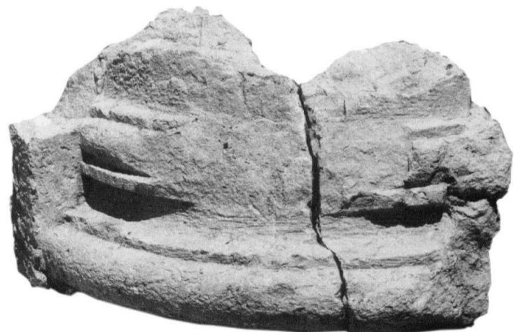
270 - Angle des murs 2' et 6'' : quart-de-base S7 d'angle rentrant en calcaire dur.
