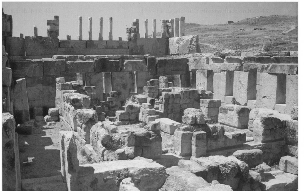
152 - Les pièces centrales vues du nord-est après la reconstruction ; l'engravure d'encastrement des sommiers dans l'assise 3 des murs 1, 6 et 2.
