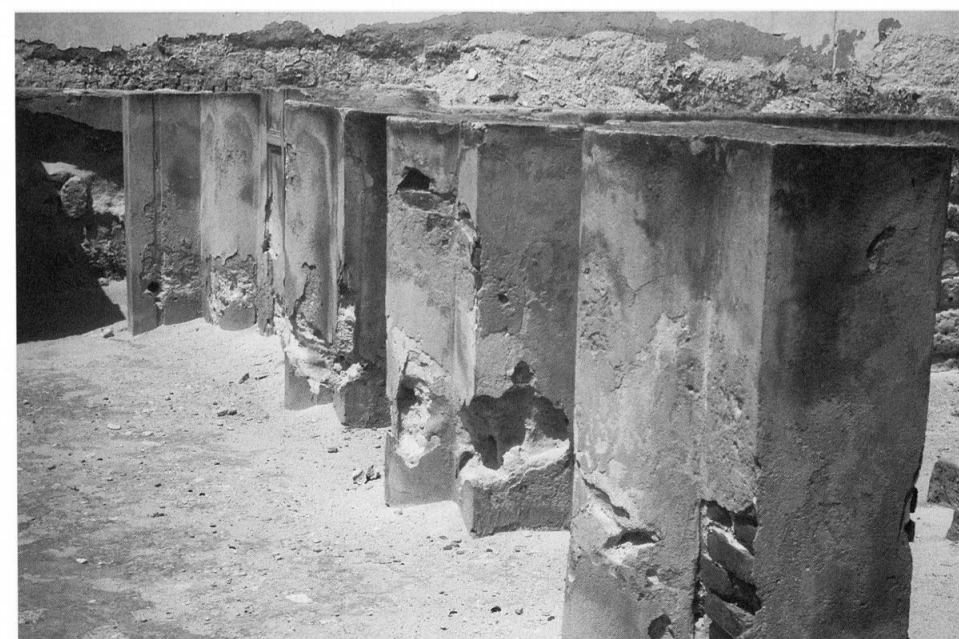
349 - Fausses fenêtres et passages entre des demi-colonnes appliquées.
