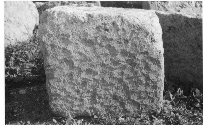
296 - Traces de taillant sur un bloc d'assise en calcaire tendre.
