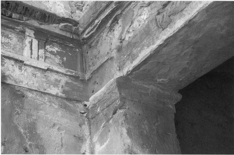
336 - Entablement dorique stucé, aux gouttes non détaillées, couronnant le pilastre d'ante.
