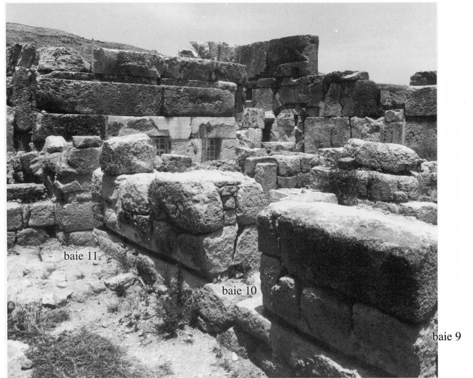
156 - Le mur 2' séparant la pièce 3 du couloir ouest : la baie 10 et la rainure horizontale séparant la fondation de l'élévation du mur 2'.
