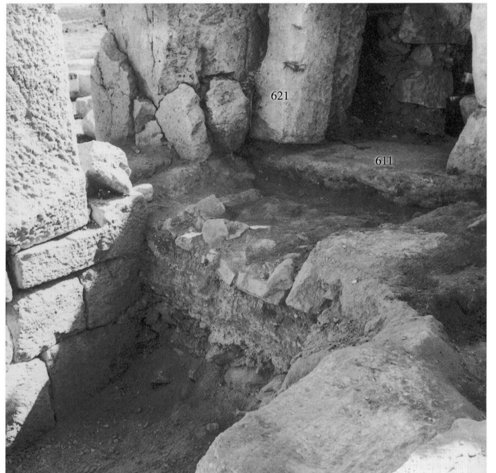
36 - Sondage S2 : les trois assises doublant l'assise 1 du mur 1 près de la porte de l'escalier sud.
