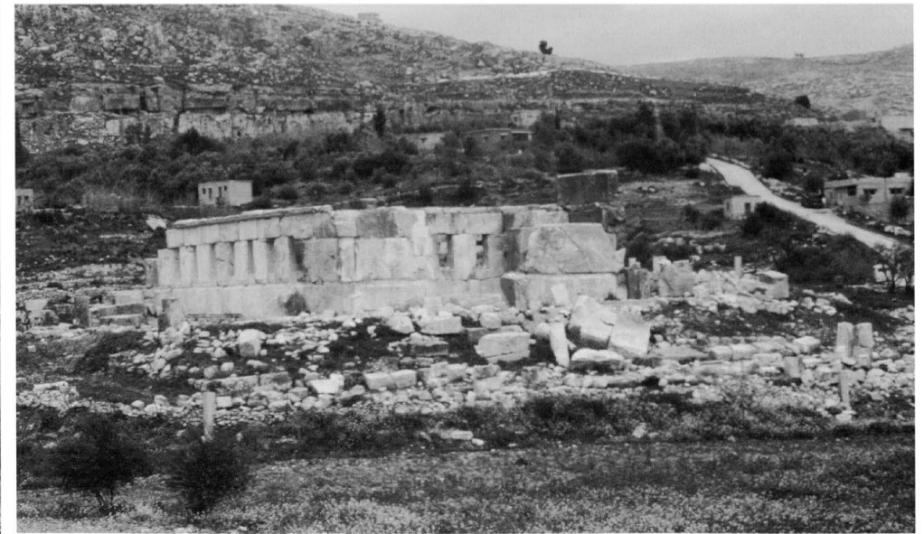
124 - Le Qasr en cours de reconstruction, vu du sud-ouest.
