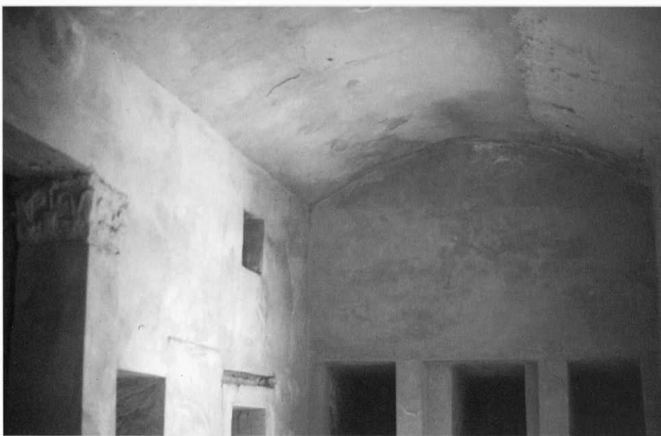
313 - La voûte surbaissée et, à gauche, le chapiteau de pilastre.
