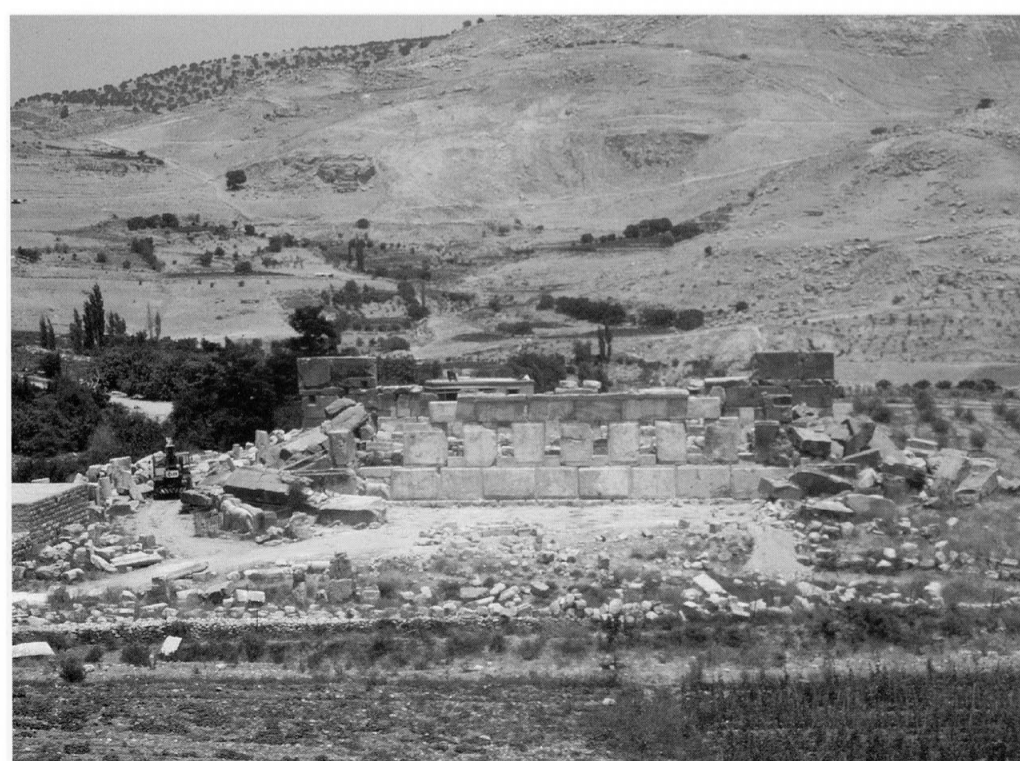
129 - Les façades nord et sud effondrées, vues de l'ouest.
