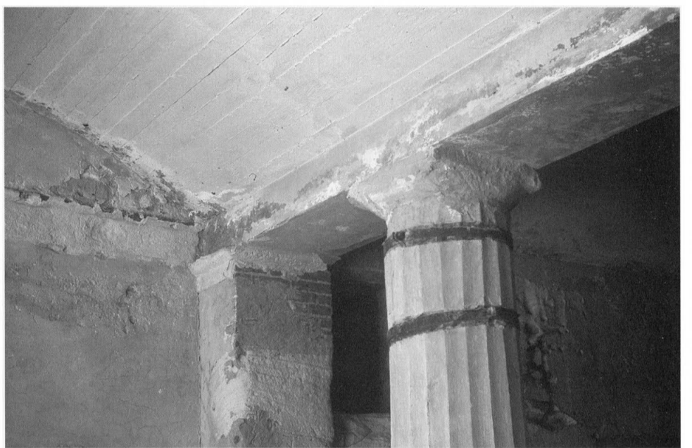
339 - Colonnade entre antes séparant le vestibule voûté d'une salle également voûtée.
