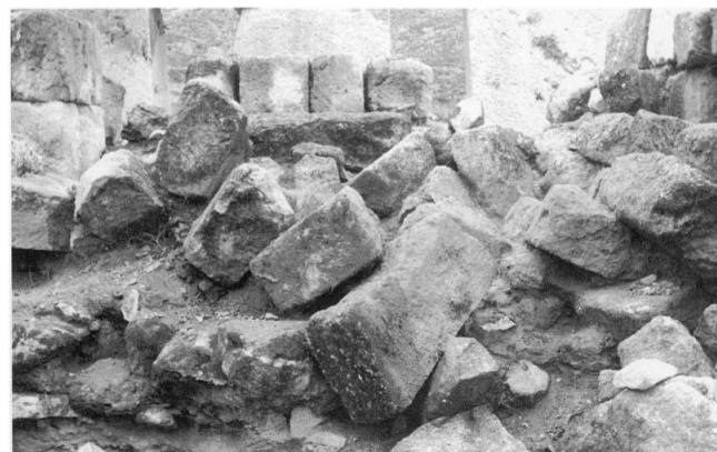
69 - Les claveaux effondrés en ordre dans la pièce 4.
