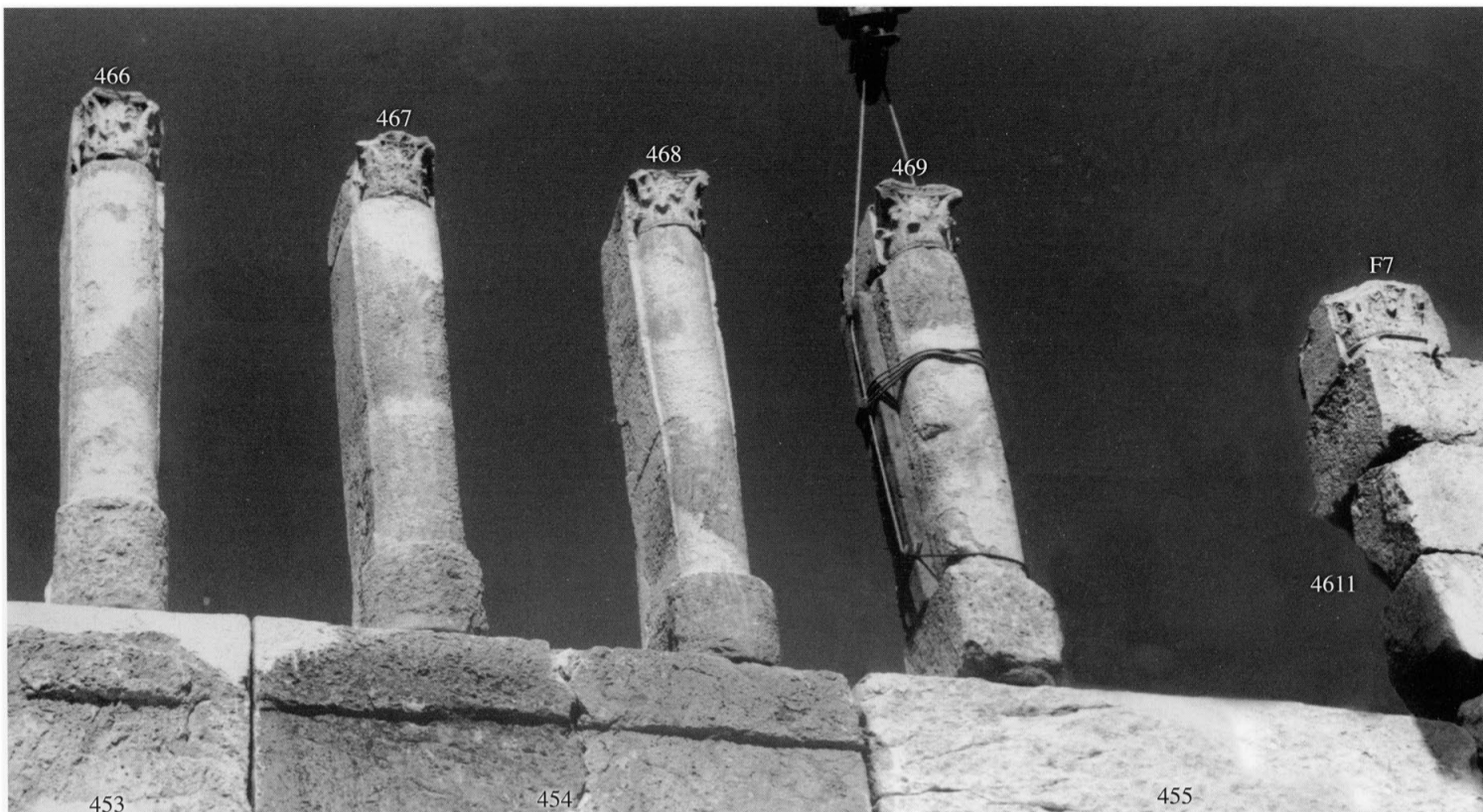
191 - La pose des meneaux 466 à 469 sur les socles 453 à 455 de la façade sud.
