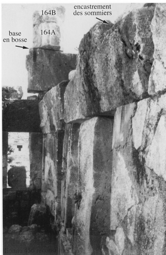
147 - Les blocs de l'assise 3 du mur 6 montrant la pente nécessaire au départ de la voûte du couloir sud.
