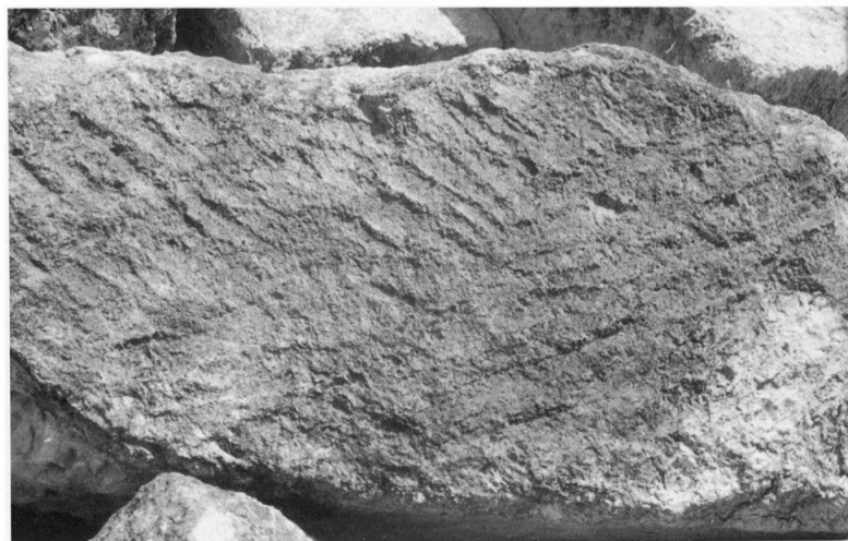
297 - Traces de taillant sur un claveau en calcaire tendre.
