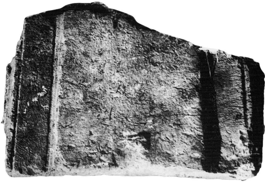
253 - Mur 3 : corniche double E1 couonnant l'entablement O de la loggia nord.
