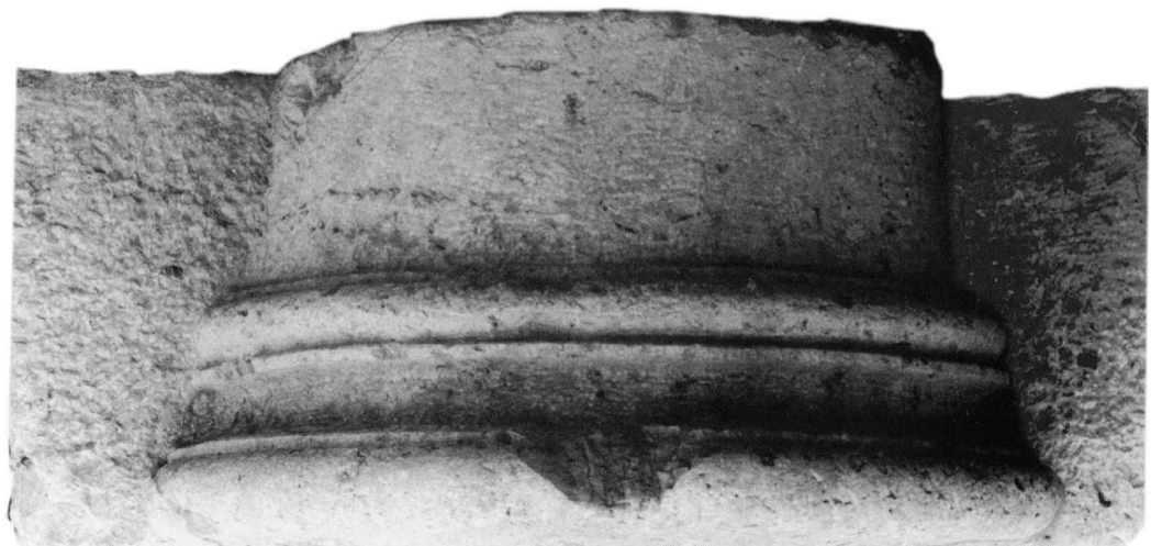
272 - Mur 2' : demi-base S3 en calcaire dur.
