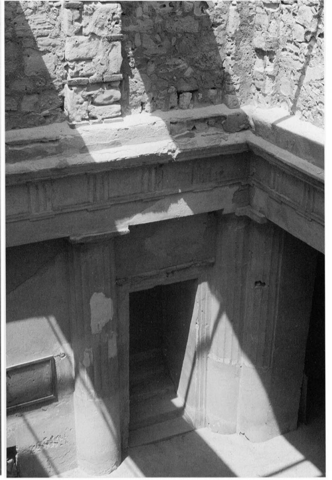
331 - Chambranle ionique de la porte d'accès à l'escalier.
