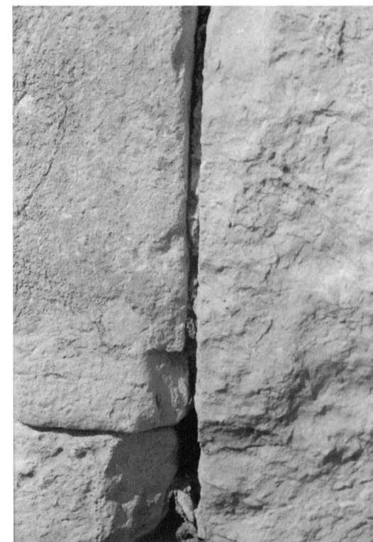
86 - Le mortier blanc entre les blocs du limon central de l'escalier nord (voir cl. 114).
