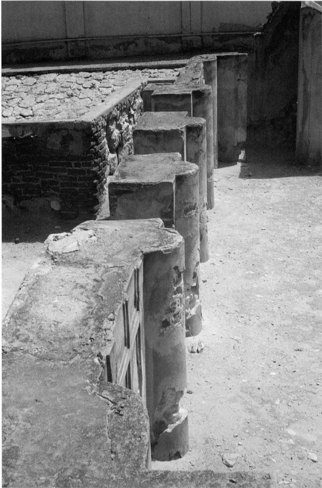
350 - Fausses fenêtres et passages entre les demi-colonnes appliquées.
