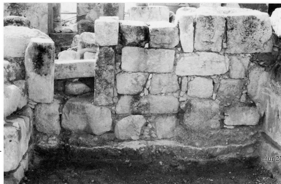
59 - Le sondage L1 dans la pièce 3 : la face nord du mur 6'' ; les deux couches parallèles de déchets de taille.
