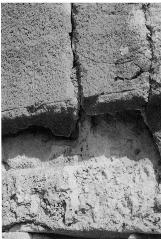
85 - Le mortier blanc destiné à remplir la fracture du bloc 1310.
