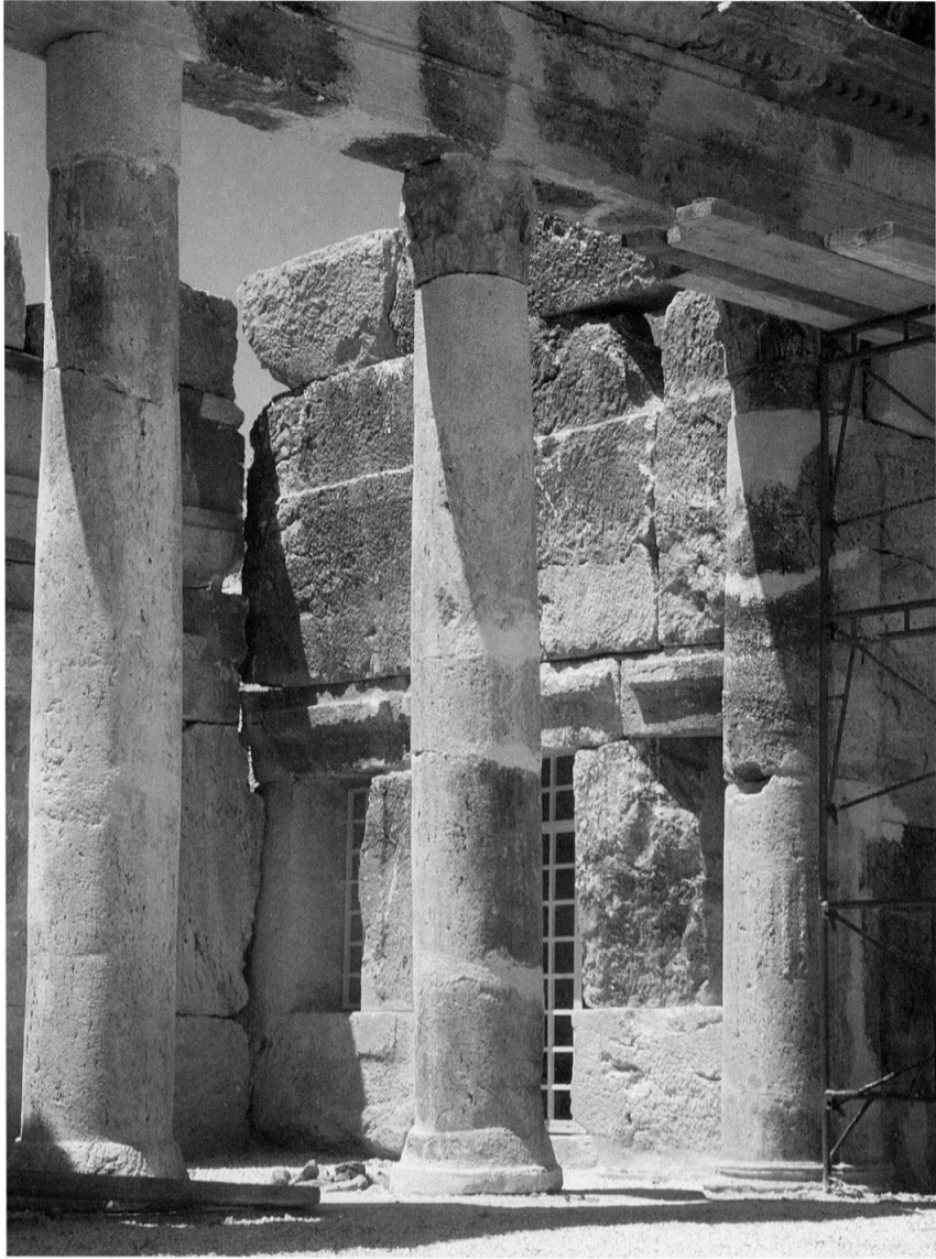
109 - Le mur 7' à l'ouest du vestibule nord.
