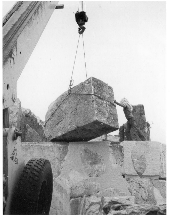
175 - La façade sud : mise en place du bloc 431.
