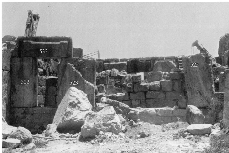
91 - Le vestibule nord : le mur 5 avant sa reconstruction.
