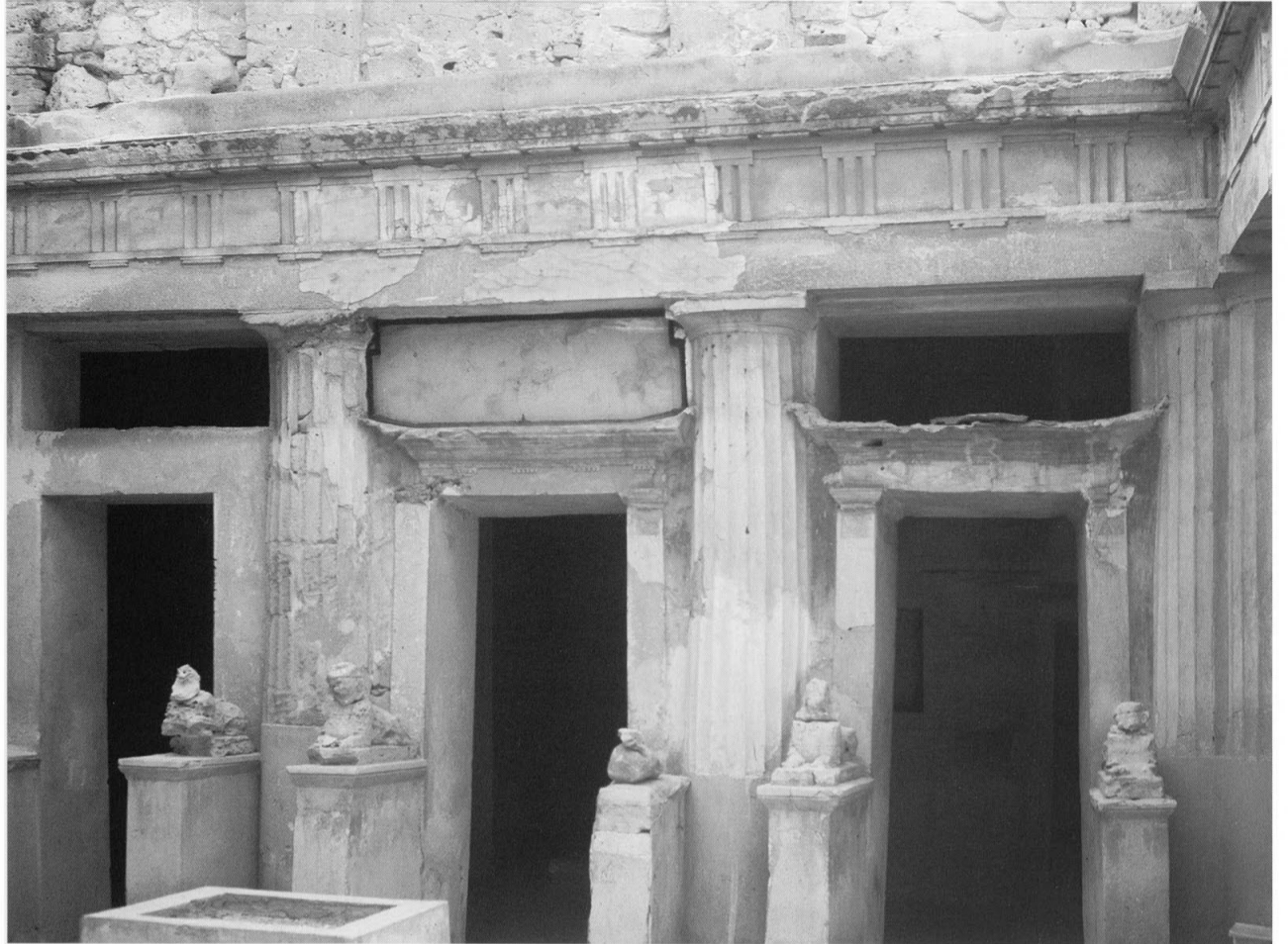
324 - Les trois baies libres surmontées de fenêtres entre les demi-colonnes appliquées ; le linteau dorique sans frise couronnant les deux pilastres.
