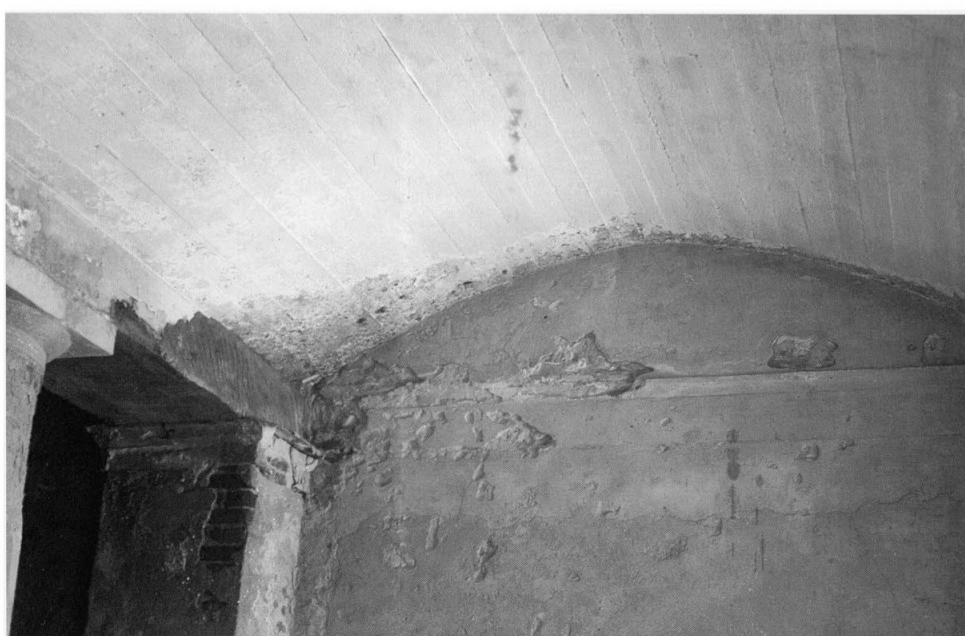
315 - Le chapiteau de pilastre et l'architrave à une fasce sur laquelle repose la voûte surbaissée.
