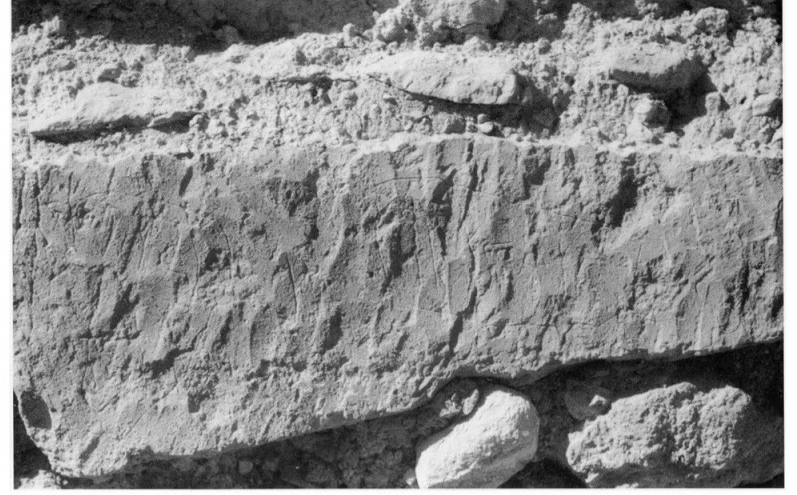
292 - Couloir est : traces de taillant sur calcaire tendre.
