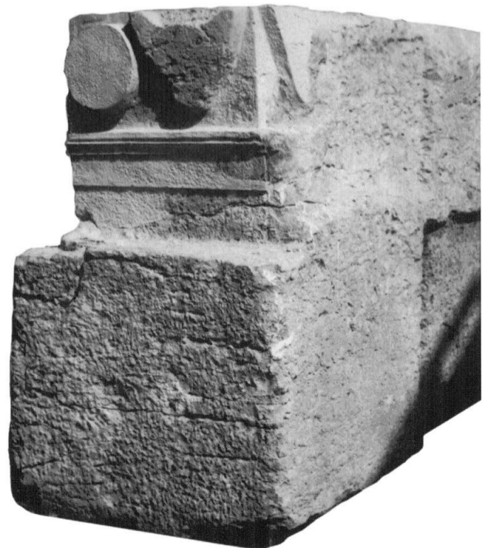
266 - Bloc 231 de l'entablement à l'angle des murs 3 et 2 avec sa frise ébauchée et le chapiteau de pilastre d'angle en bosse grossière.
