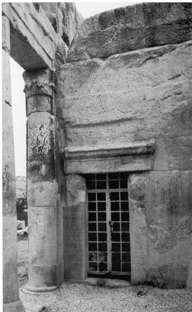
111 - Le vestibule nord : la porte de l'escalier nord dans le mur 7.
