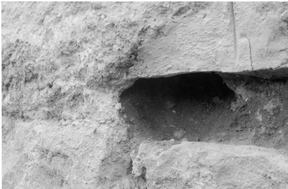
82 - Le mortier recouvrant la rainure vidée de son chaînage en bois.
