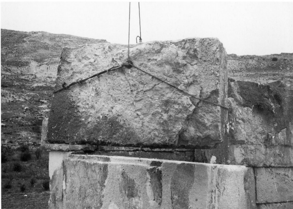
176 - La façade sud : mise en place du bloc 431.
