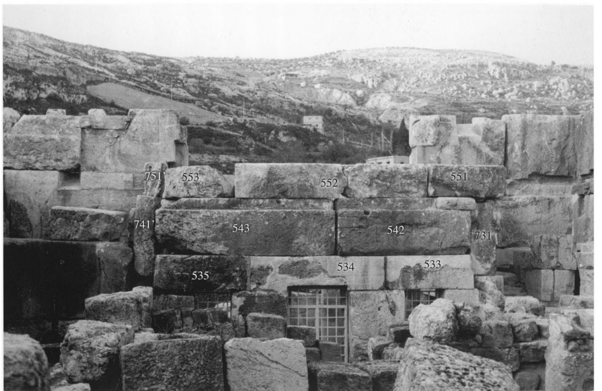
154 - L'engravure d'encastrement des sommiers, creusée dans l'assise 4 du mur 5.
