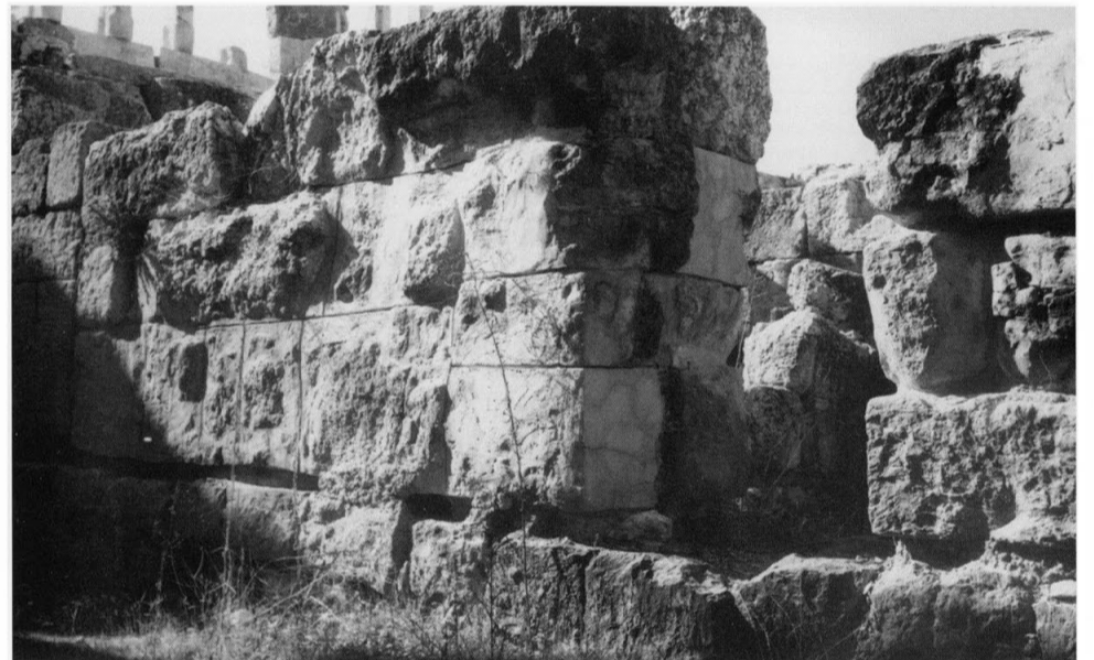
158 - La baie 3 du mur 1' qui permet le passage du couloir est à la pièce 2 ; la rainure horizontale bouchée et recouverte d'enduit.
