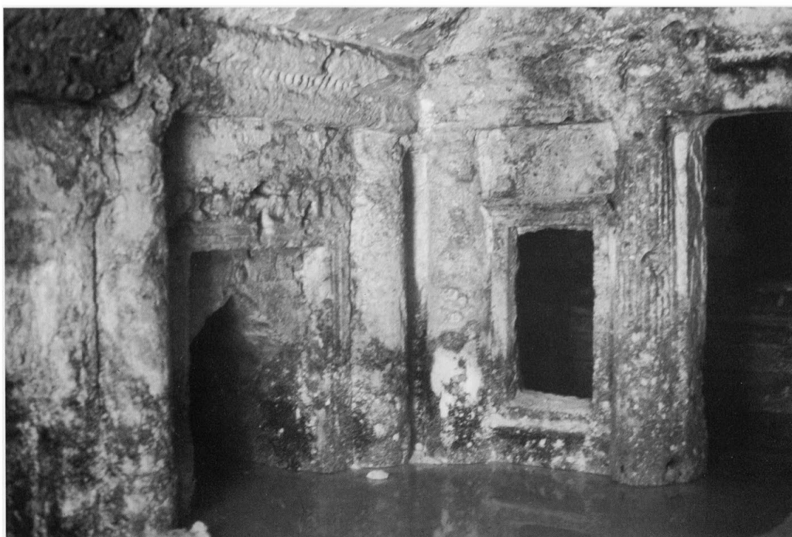
308 - Alexandrie, catacombes St-Marc à Chatby : les fausses fenêtres ioniques disposées entre les demi-colonnes d'un ordre corinthien appliqué.
