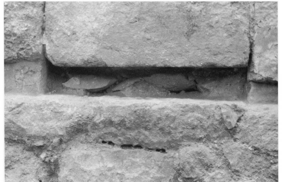
160 - Détail de la rainure séparant la fondation de l'élévation des murs des pièces centrales.
