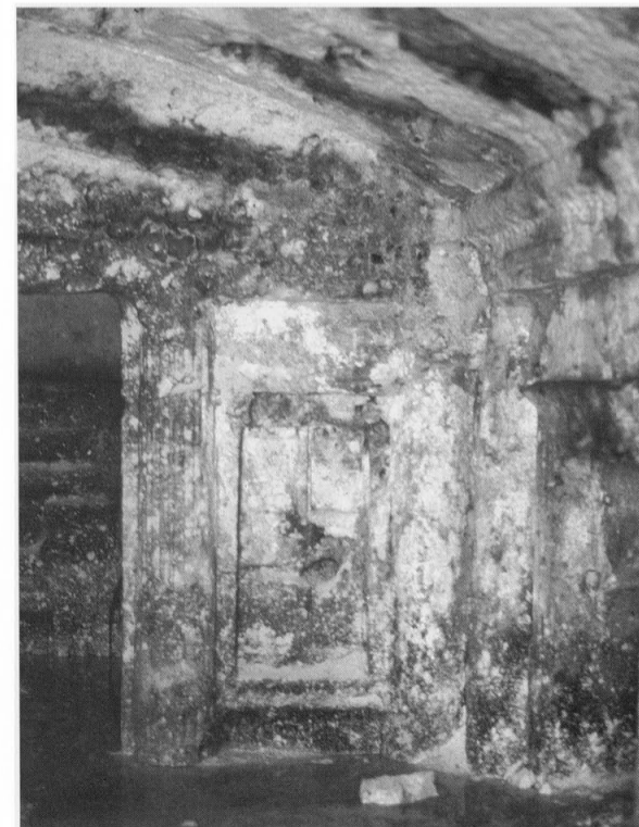
309 - Alexandrie, catacombes St-Marc à Chatby : la couverture de la tombe est taillée en forme de voûte surbaissée.
