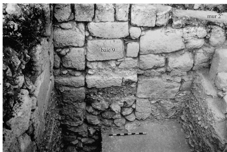
61 - Le sondage L1 dans la pièce 3 : la baie 9 bouchée dans la face est du mur 2'.
