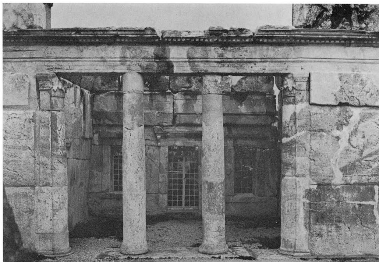
2 - L'entrée nord du Qasr.
