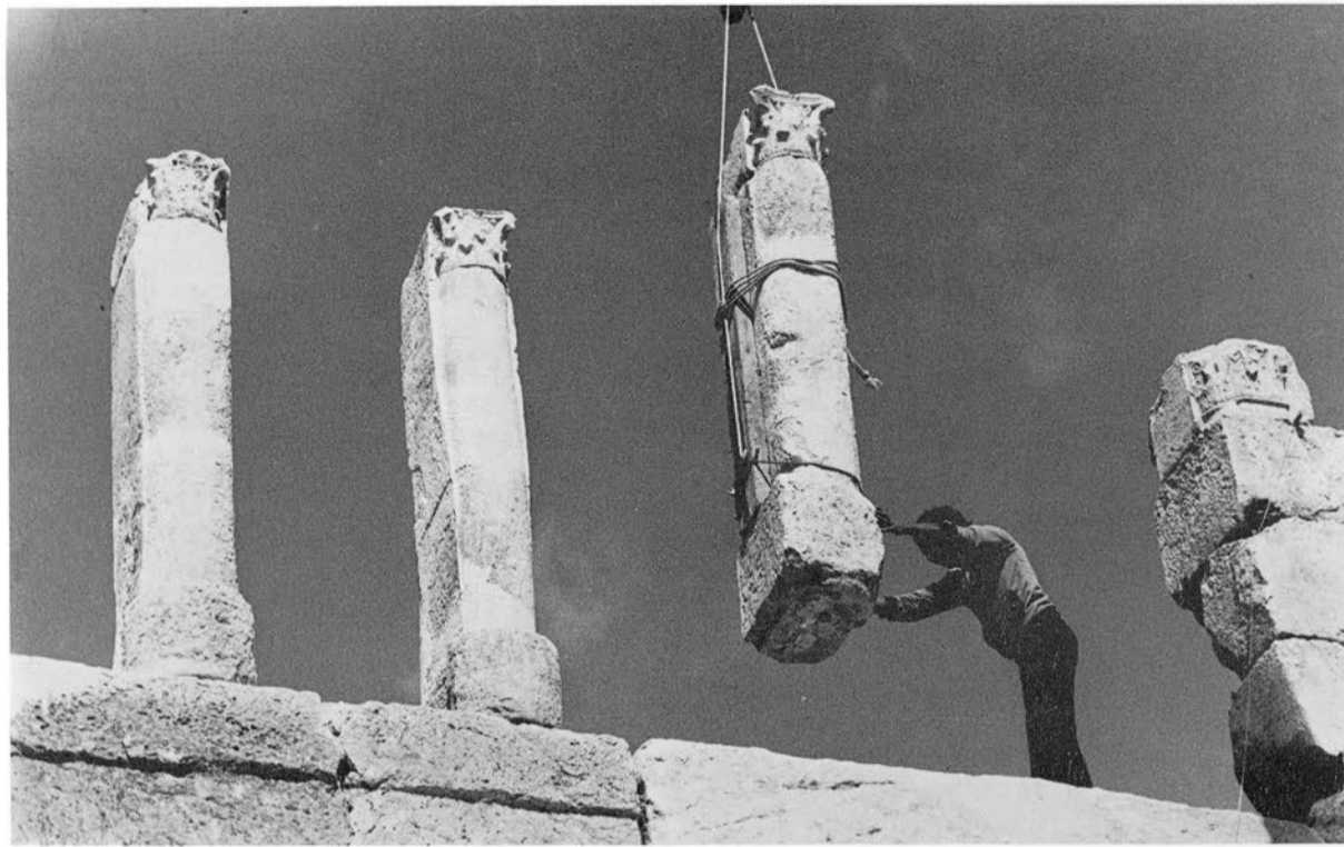
1 - Pose des trumeaux 467, 468, 469 de la loggia sud sur les socles 454, 455.
