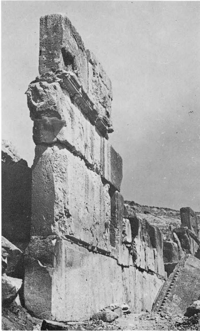
1 - L'angle sud-est du Qasr après dégagement.
