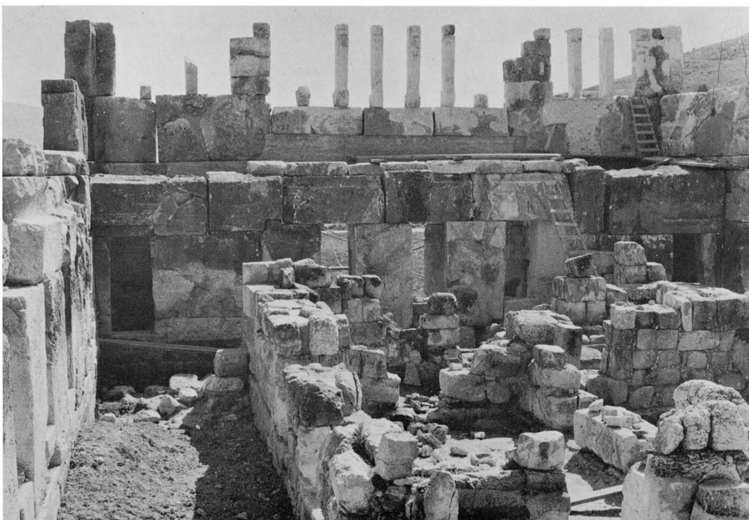
2 - La partie sud-ouest du bloc interne.
