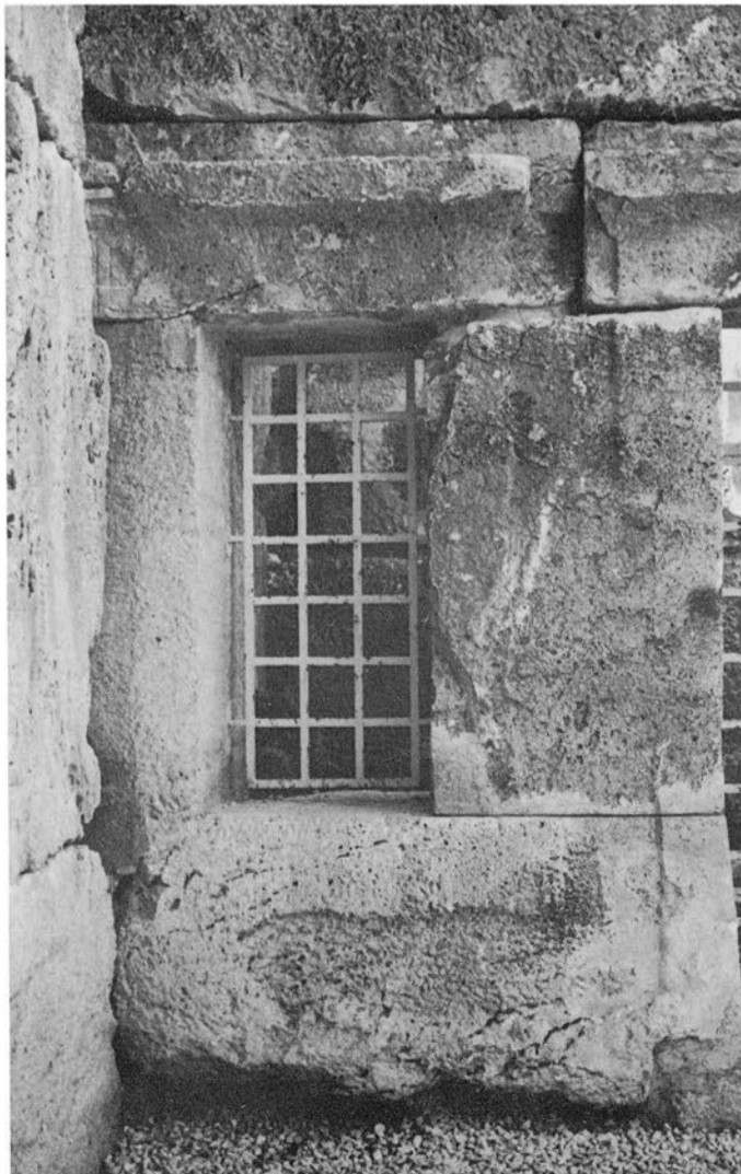
3 - La fenêtre sud du mur 7'.
