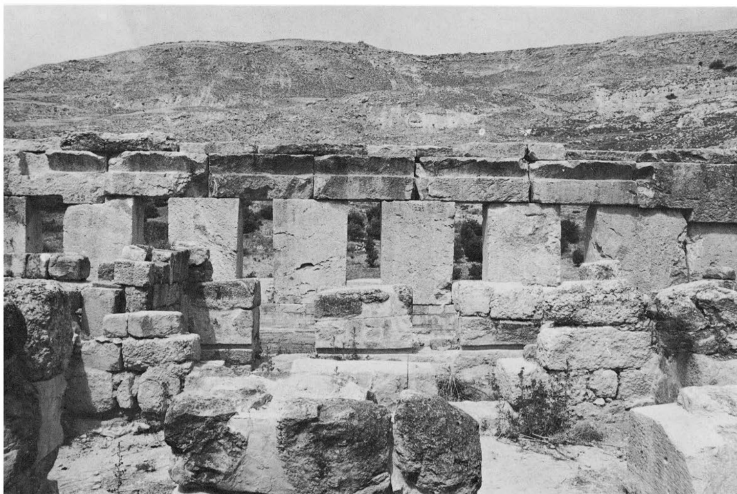
1 - Les pièces nos 2 et 3, vers l'ouest (avec le mur 2).
