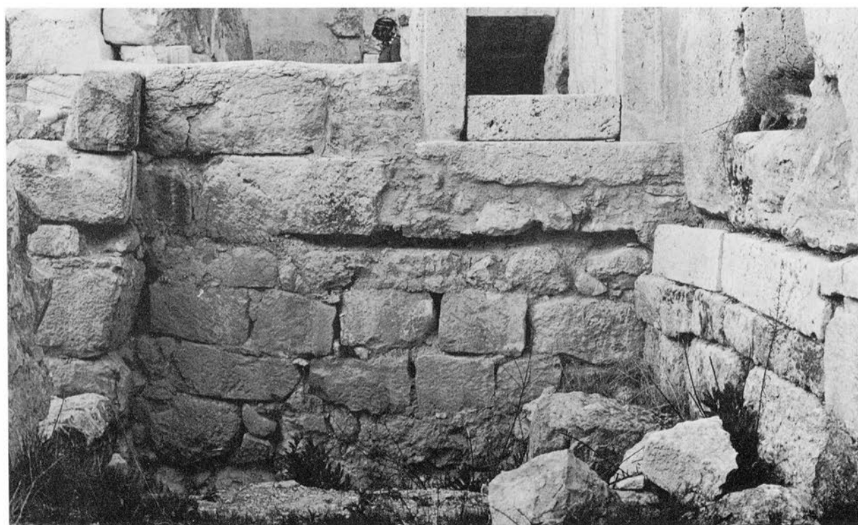
5 - Le mur 5', face sud, état actuel.
