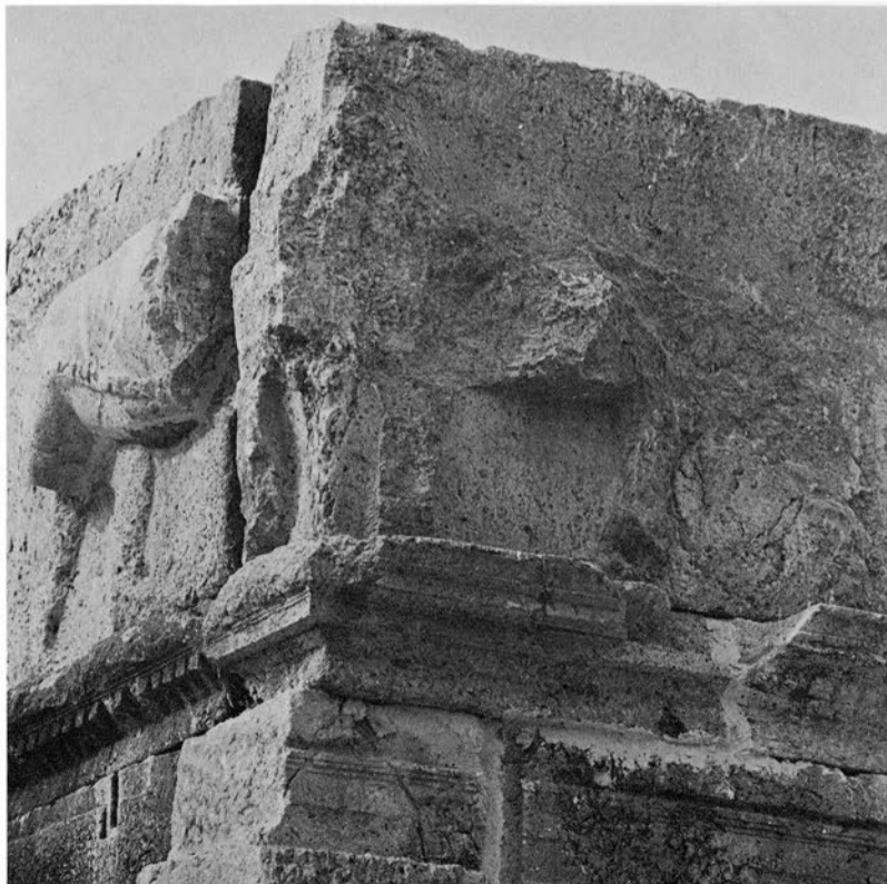
3. 4 : Vue sur l'angle, après restauration.
