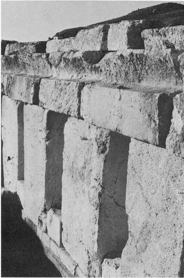
1 - L'engravure pour voûte dans l'assise n° 3 du mur 2.
