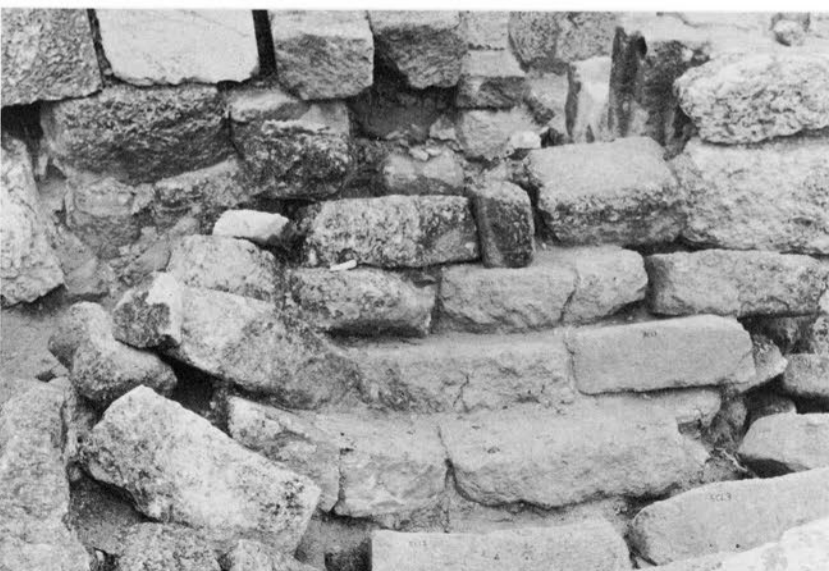
4 - Voûte écroulée de la pièce n° 4.
