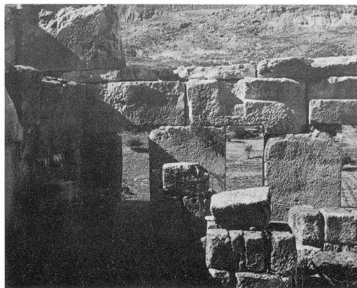
5 - Le mur n° 2 avec la cavité d'encastrement pour poutre.
