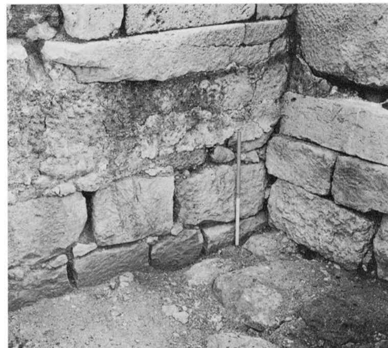
4 - Le mur 5' avec le seuil de la porte de la citerne nord-est.
