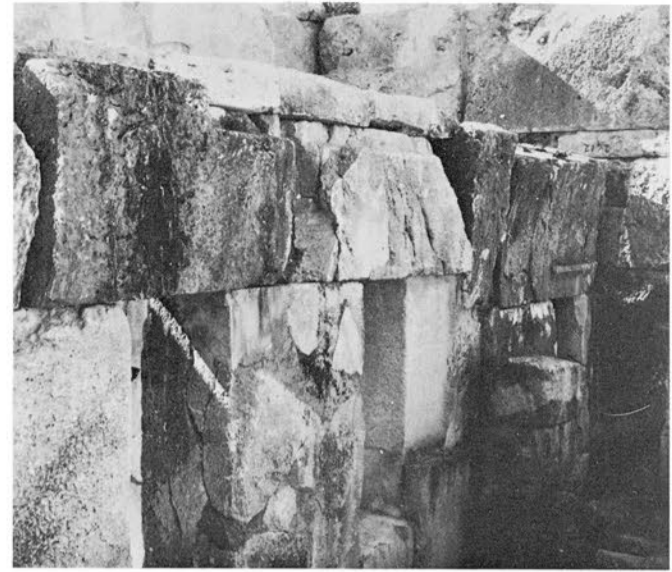
2 - Extrémité ouest du mur 6, face nord.
