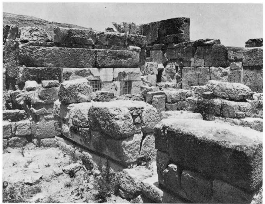
2 - Le chaînage du mur 2'.
