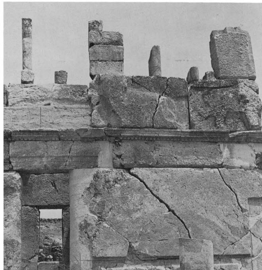
2. 12-13 sud : Après restauration.
