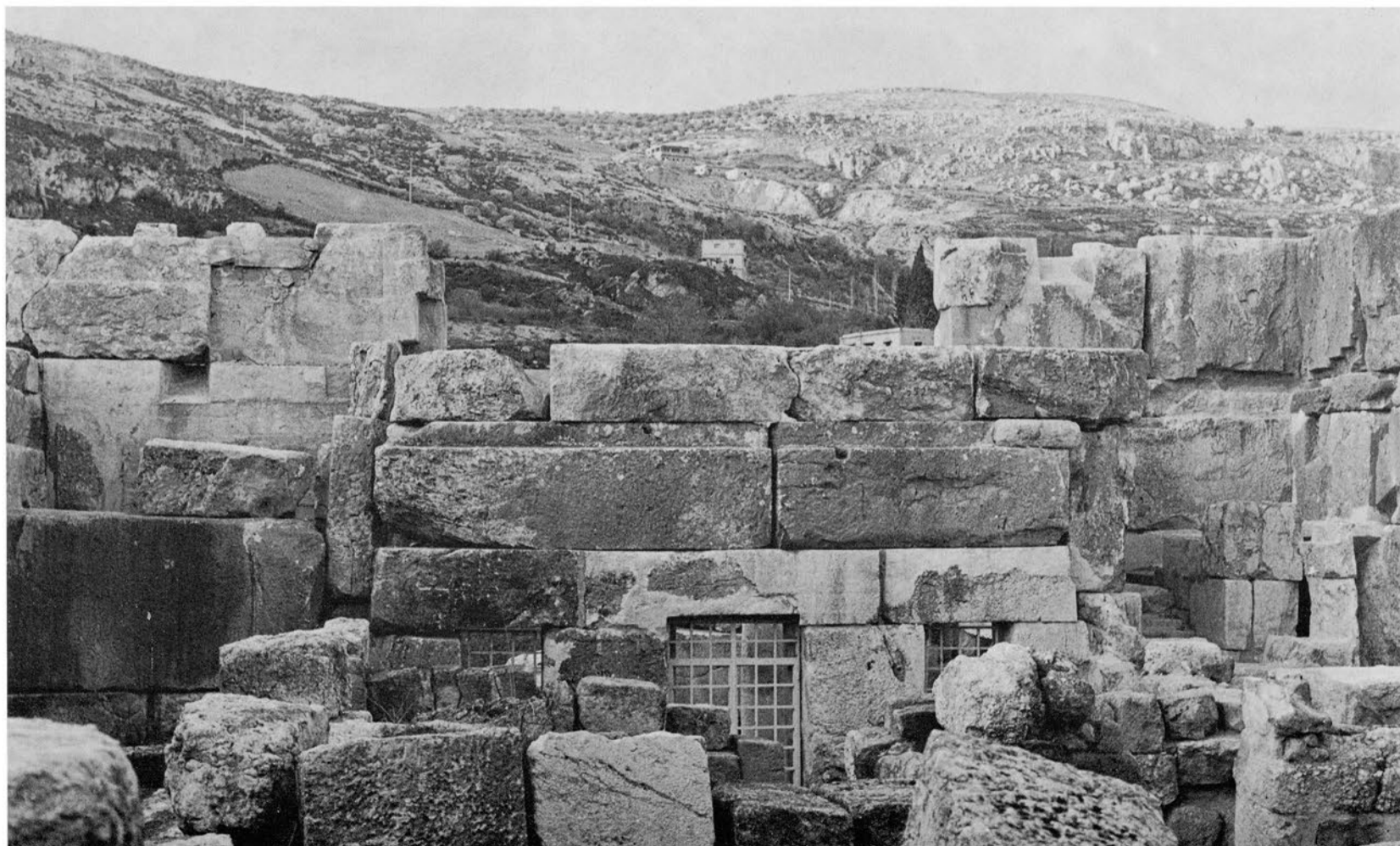
4 - Le massif nord reconstruit : la face sud du vestibule interne.
