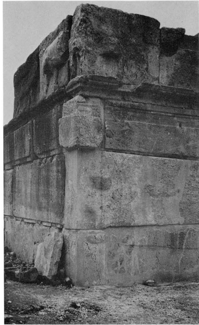
2 - L'angle nord-est du Qasr reconstruit.
