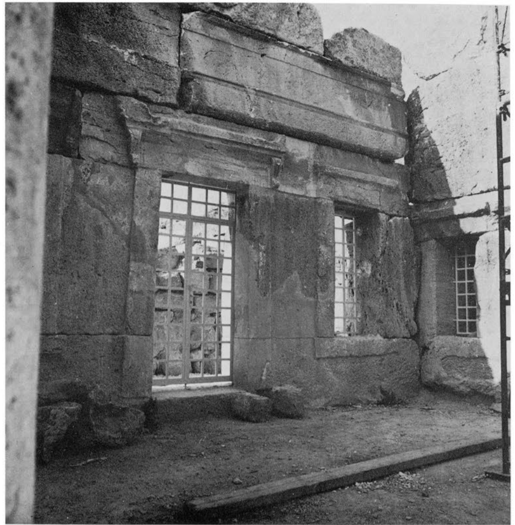
2 - Le vestibule nord, vers l'angle sud-ouest.
