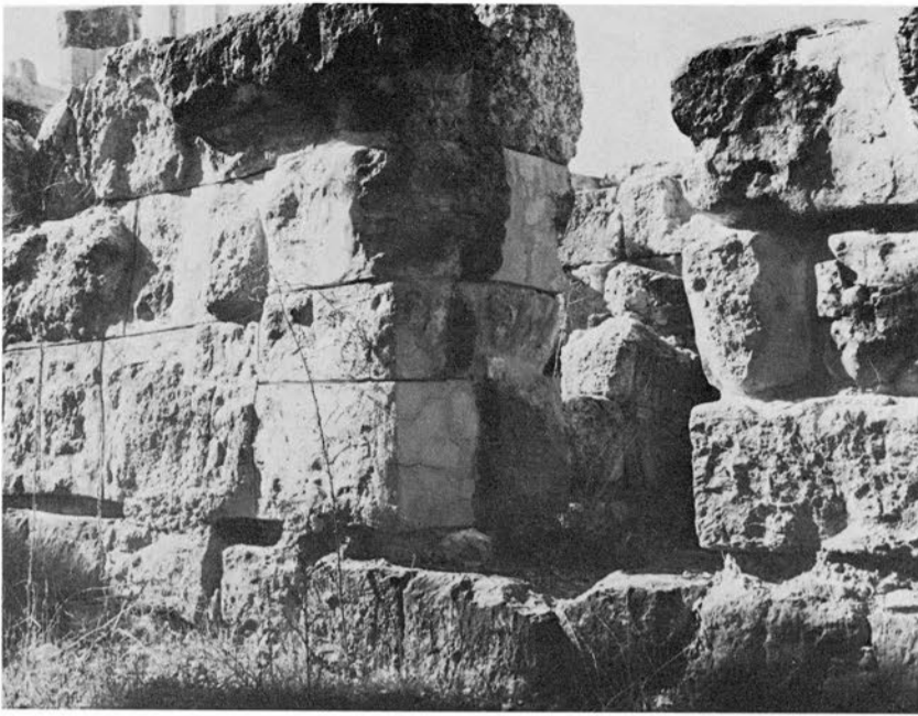
1 - Le chaînage du mur 1'.
