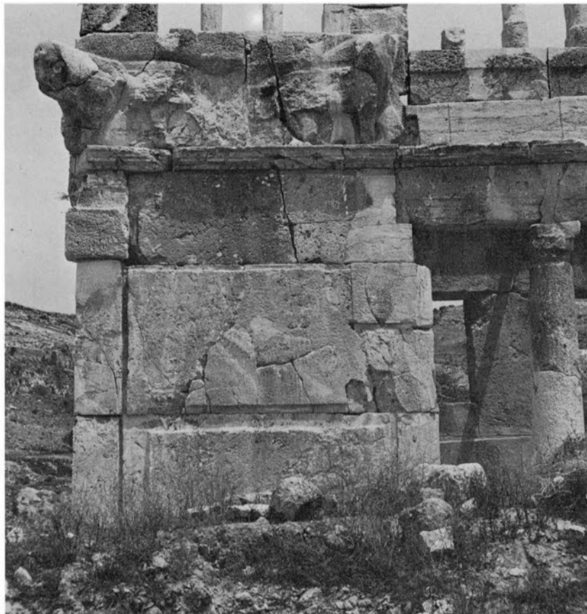
1. 10 sud-11 : Après restauration.
