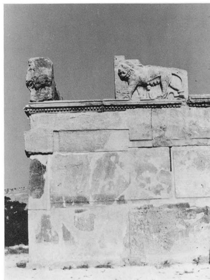
4 - L'extrémité nord du long côté ouest reconstruit.
