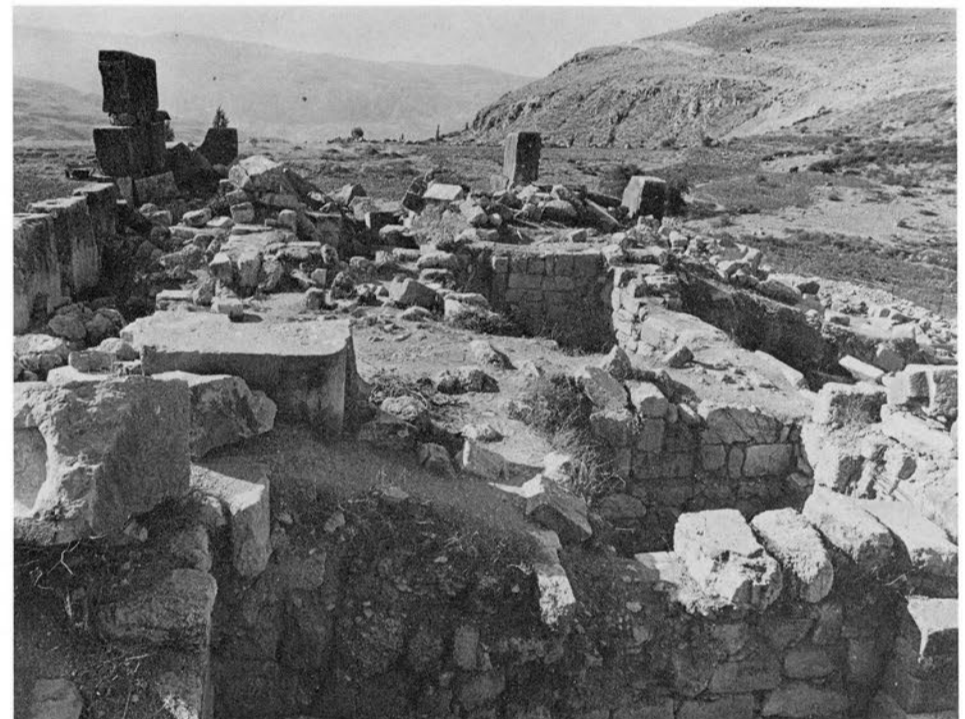
4 - L'intérieur du Qasr au début des travaux
