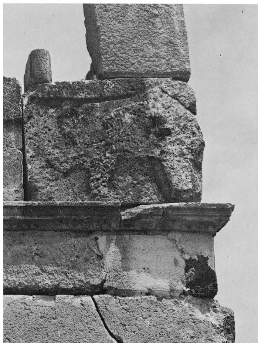
3. 13 sud : Après restauration.
