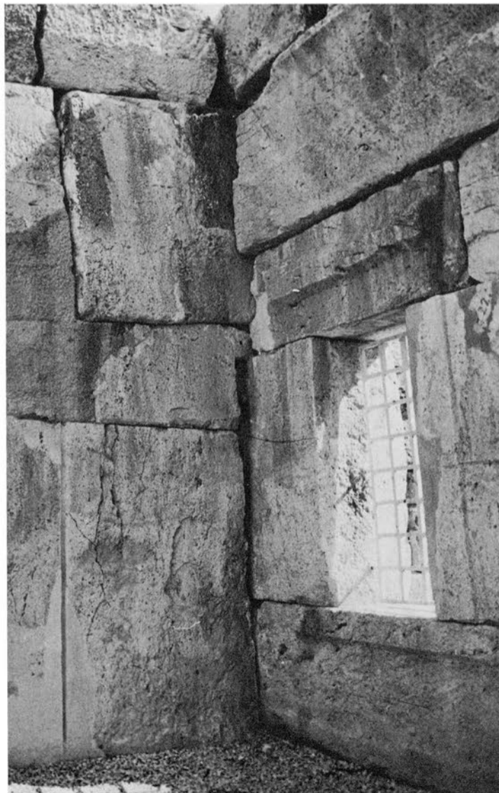
3 - Le vestibule nord, angle sud-est.
