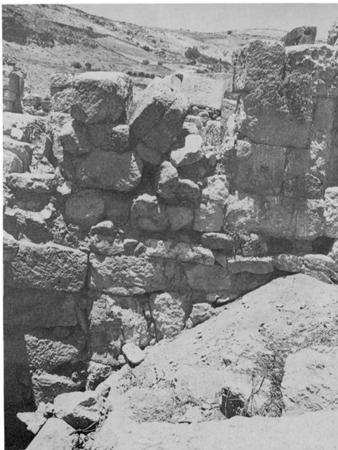
5 - Le couloir sud avec la baie 6 dans le mur 6'.
