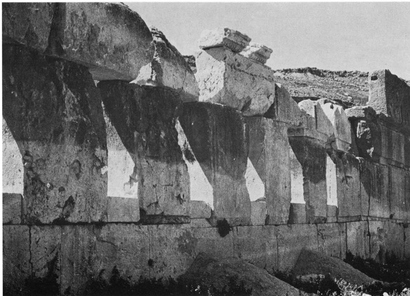
3 - Partie médiane du mur est après restauration.
