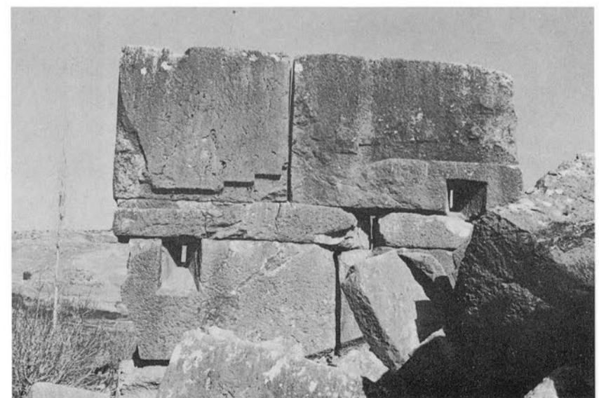
5 - L'extrémité nord du mur est, face ouest, avant la reconstruction.
