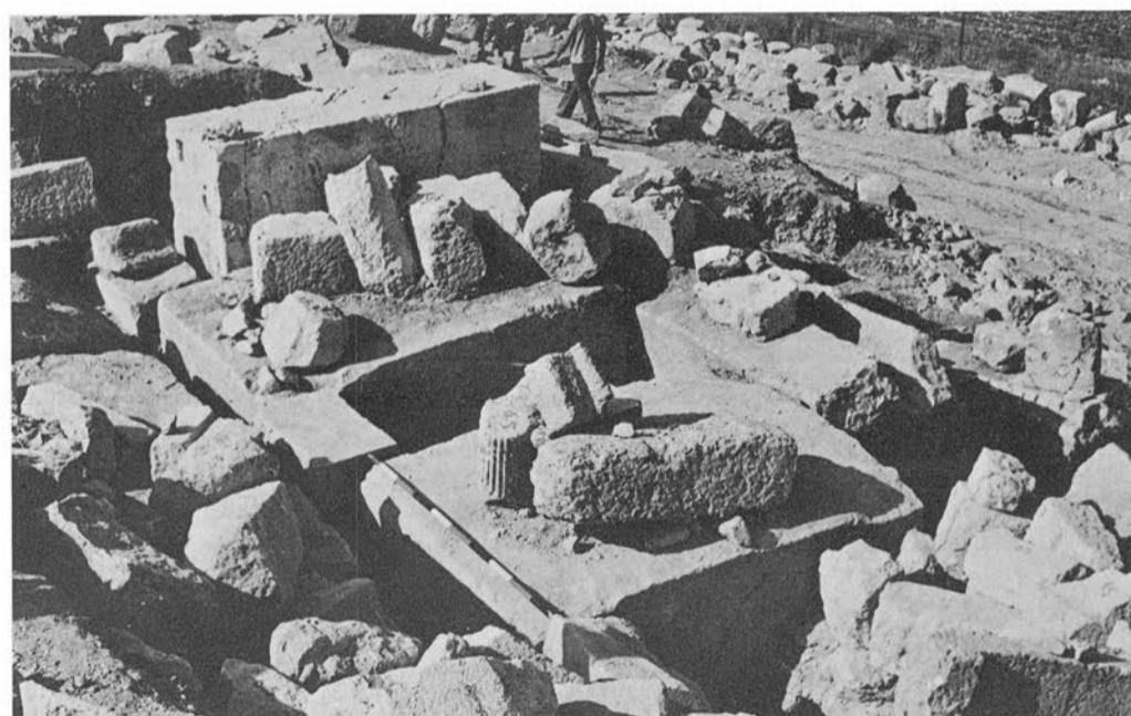
2 - Le mur ouest écroulé.
