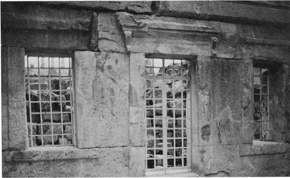
1 - Le vestibule nord : le côté sud (mur 5).
