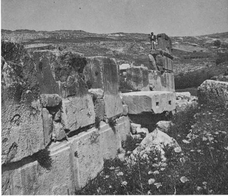
1 - Le long côté est avant les travaux avec la dalle écroulée de l'entrée tardive.
