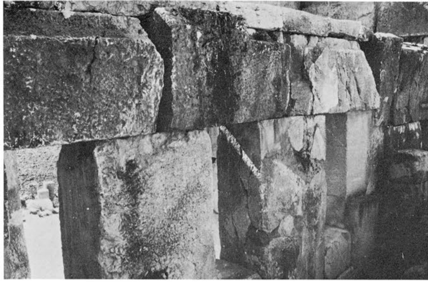
1 - La partie médiane du mur 6, face nord.
