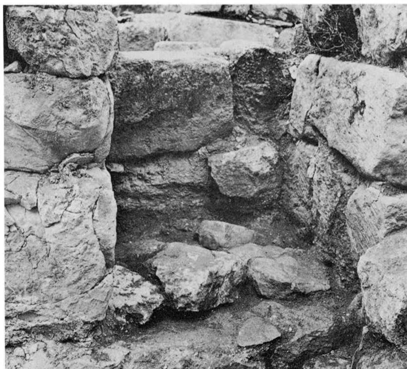
5 - La baie n° 3 avec restes du blocage du chaînage .
