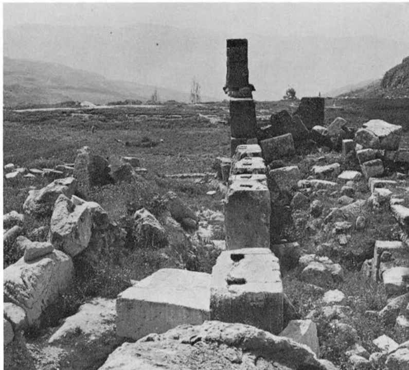
3 - Le mur est au début des travaux, vers le sud.
