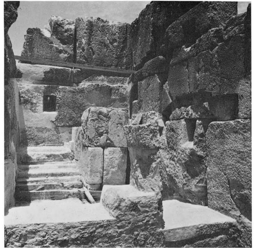
3 - Le départ de la deuxième révolution de l'escalier.
