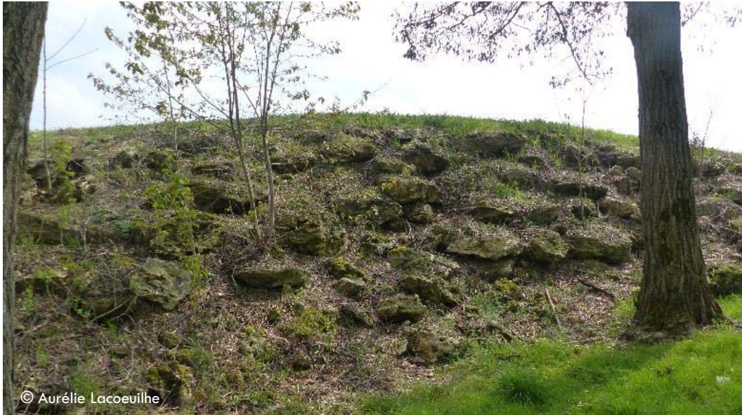
Figure 106 – Enrochements sur le parcours de l'Oiselet (avril 2019).
