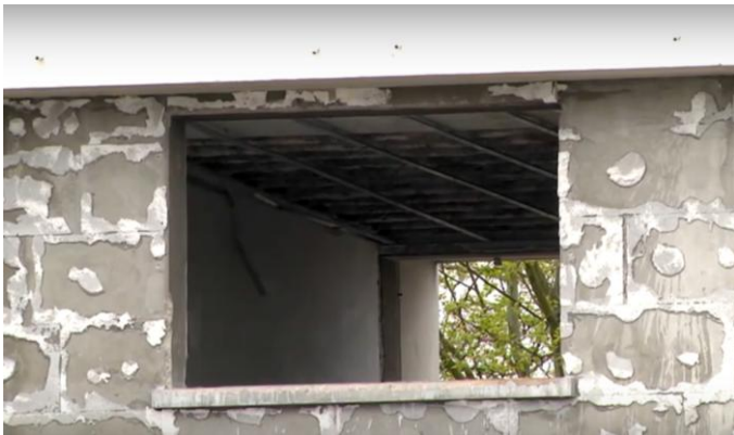
Démolition sur fond d'arbre en 2014 (@Sophie Fueyo)
