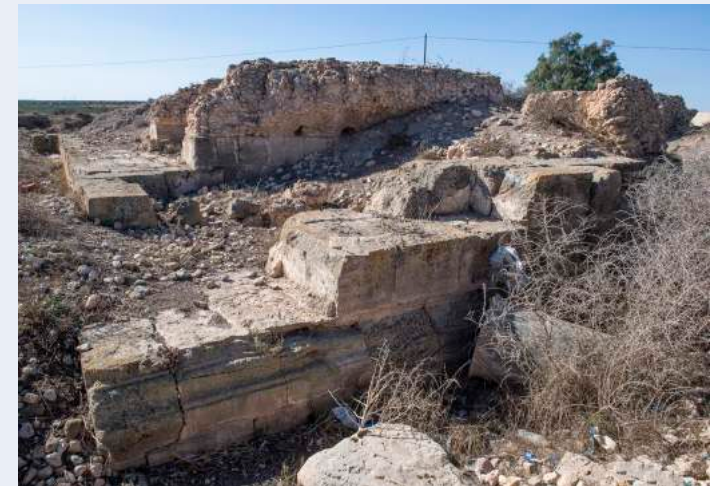
(3) Temple A. Vue actuelle des fondations.
