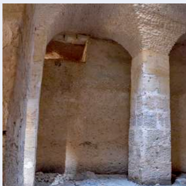
(8) Petite citerne. Évacuation du trop-plein vers la grande citerne.
