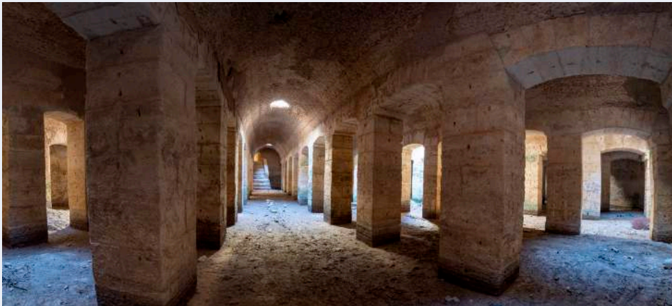
(6) Grande citerne. Vue intérieure générale.
