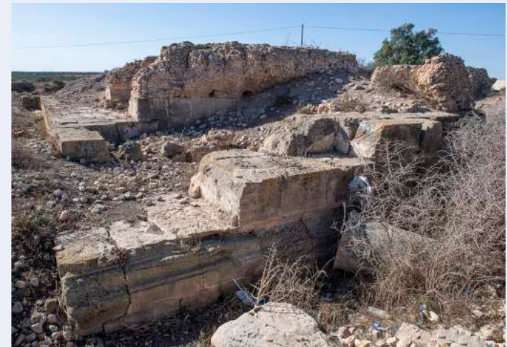
(3) Temple A. Vue actuelle des fondations.
