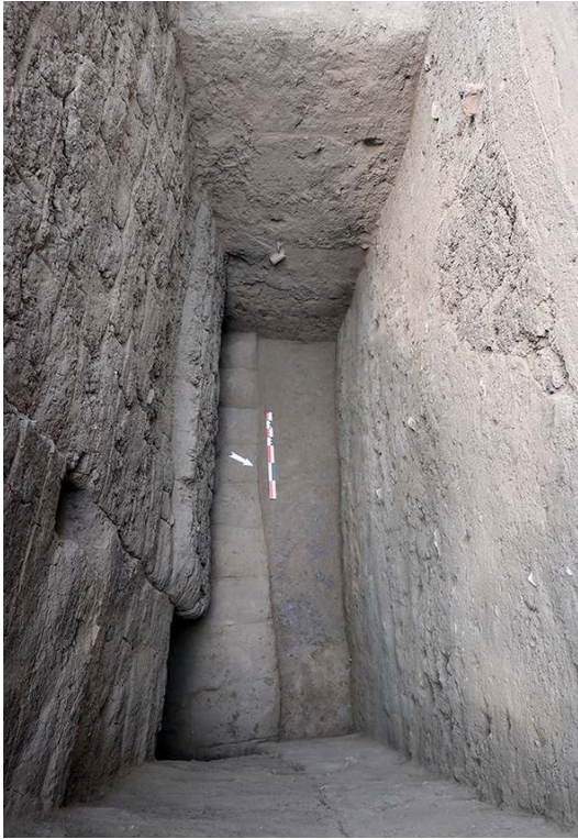
Fig. 8. Sondage le long de la face nord des fondations de la maçonnerie du passage, au contact de l'angle nord-est de la porte dans l'enceinte, vu de l'est (cliché Fr. Leclère).
