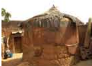
Les cases avant et après la réfection annuelle des enduits
