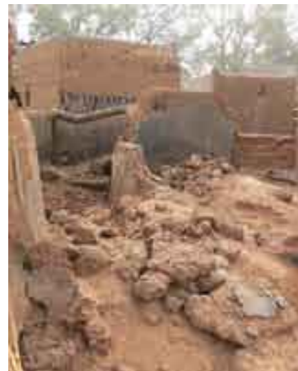
Écroulement de maison suite aux inondation de 2007
