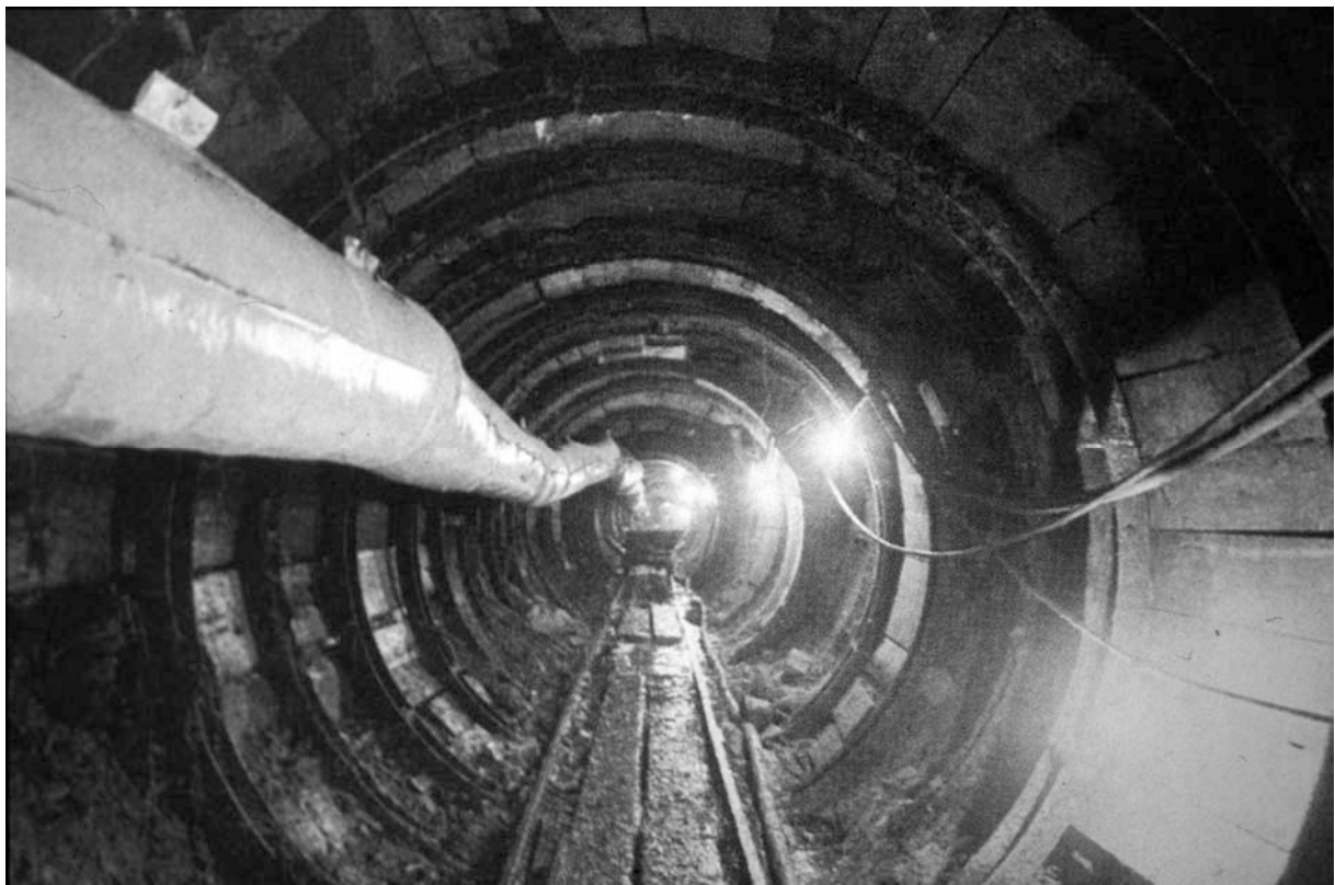
Fig. 4. La galerie dite « des anciens » dénoyée en 1989. Un siècle après son creusement, cette galerie d'un diamètre de 2,14 m apparaît encore en bon état. Cette galerie d'essai fut forée par un tunnelier rudimentaire mis au point par le colonel de Beaumont entre le 2 septembre 1882 et
