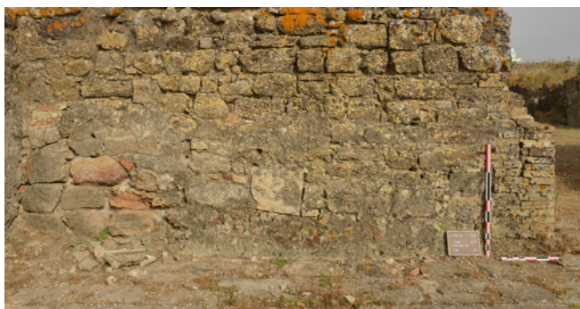
Fig. 13 : Muro de las termas suroccidentales de Banasa: opus uittatum irregular y ladrillo (HAR2015-64392-C4-1-P).
