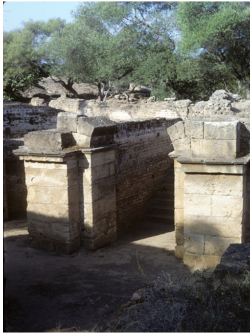
Fig. 22 : Muro tardío con hiladas de bloques irregulares y enlucido simulando hiladas regulares (P. A. Février-Centre Camille Jullian/CNRS/AMU).
