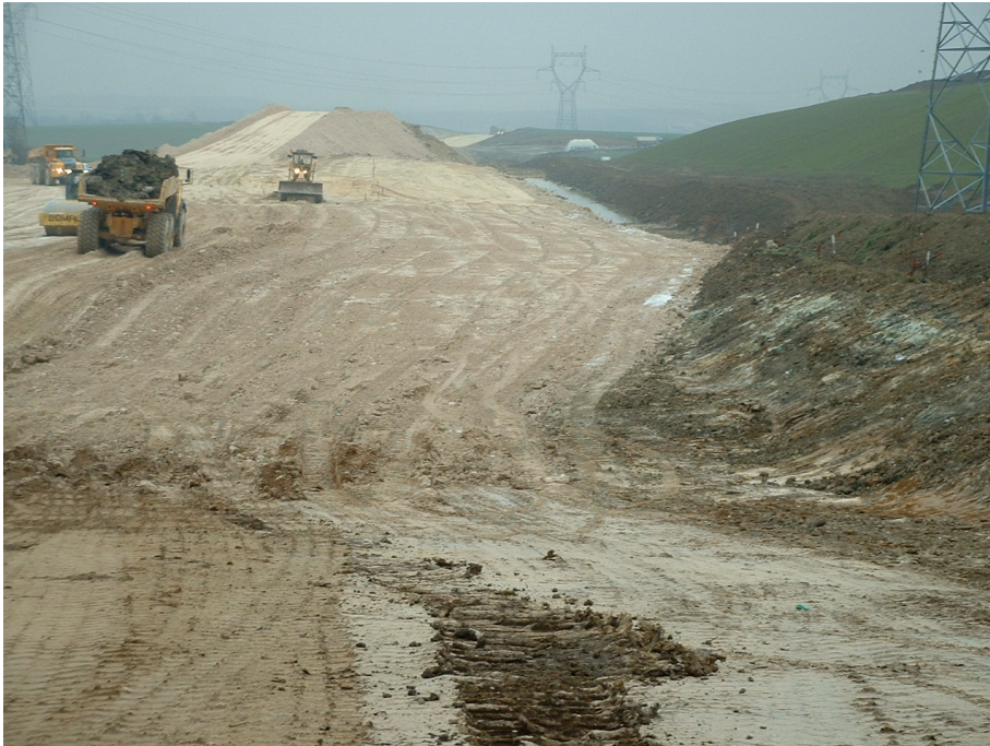
Fig. 1. Les Monts Gardés durant le chantier de la LGV : une topographie et un sol entièrement remodelés.
