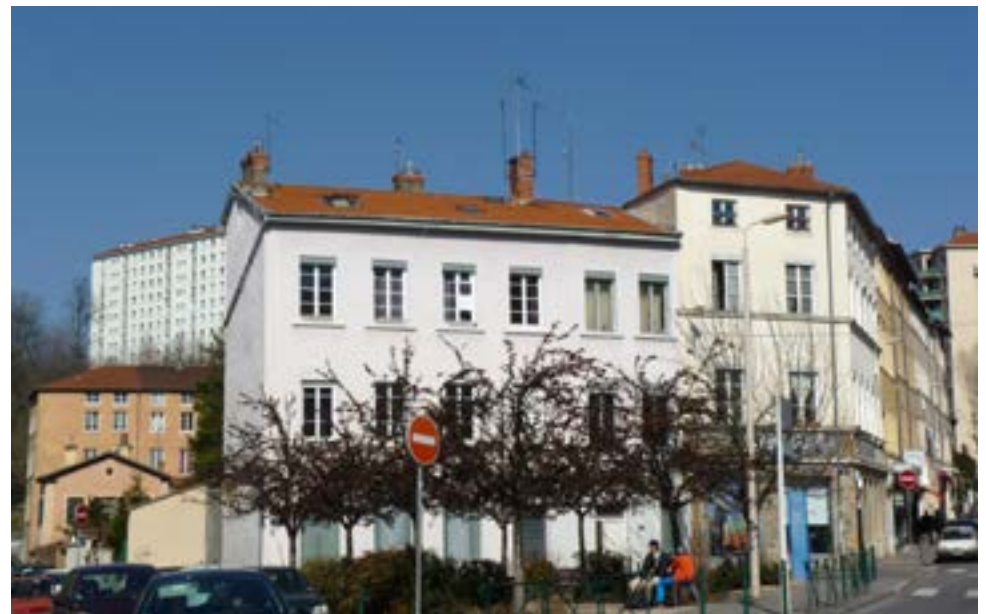
Lyon : Quartier Saint Just, Immeuble en pisé à la jonction de la rue Benoist Mary et de la rue des 4 colonnes © Sébastien Moriset, CRAterre
