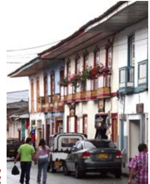
Constructions en terre faites de pisé à la base et de torchis (bahareque) à l'étage
