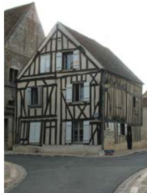
Construction en bois et torchis dans la ville médiévale de Provins
