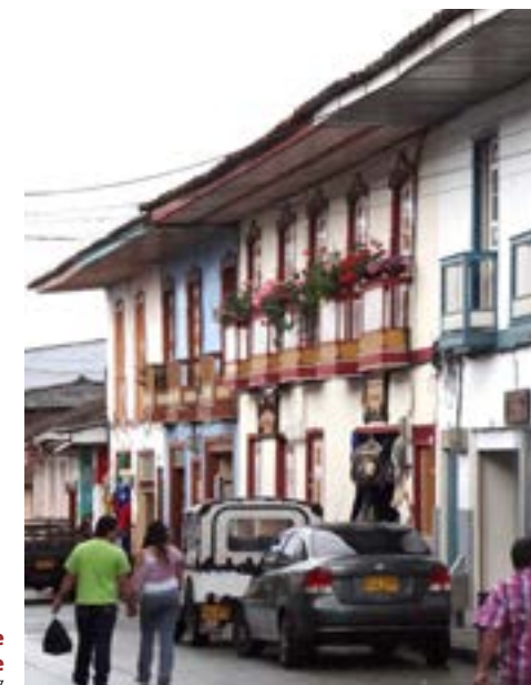
Constructions en terre faites de pisé à la base et de torchis (bahareque) à l'étage © Beatriz Helena Ramirez Gonzalez
