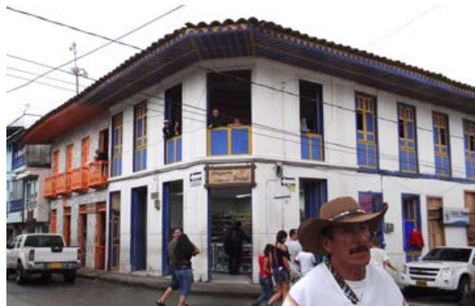
Constructions en terre faites de pisé à la base et de torchis (bahareque) à l'étage © Beatriz Helena Ramirez Gonzalez
