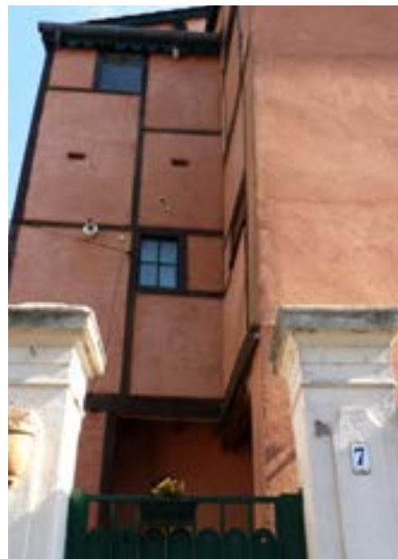
Lyon : Quartier Saint Just, constructions en colombage, rue Saint Fiacre © Sébastien Moriset, CRAterre
