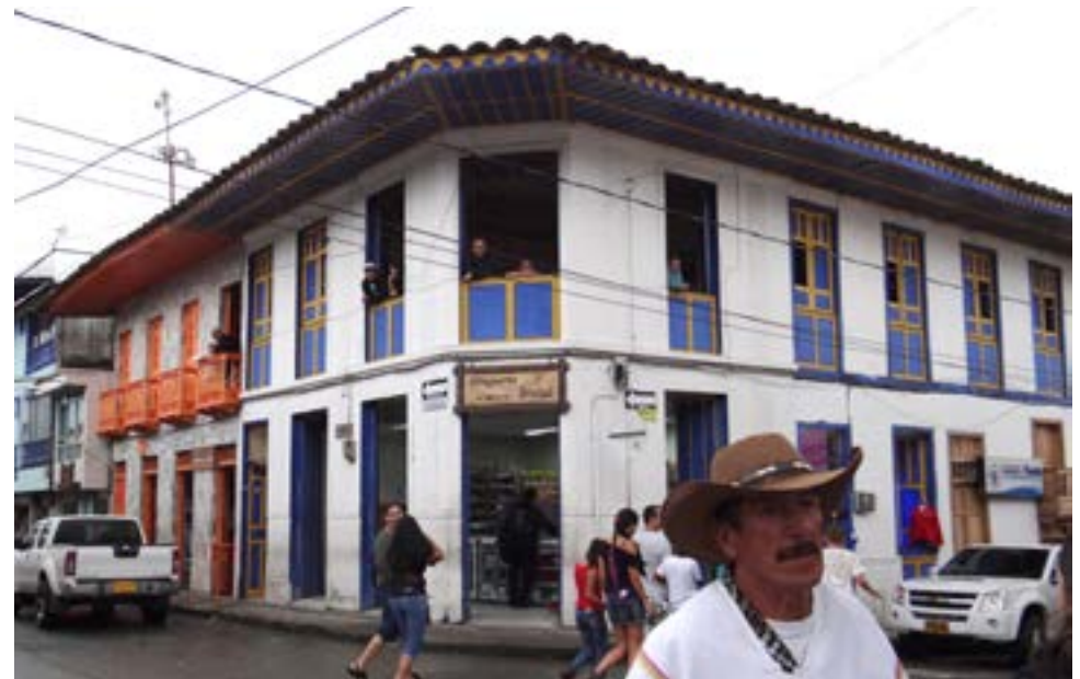
Constructions en terre faites de pisé à la base et de torchis (bahareque) à l'étage
