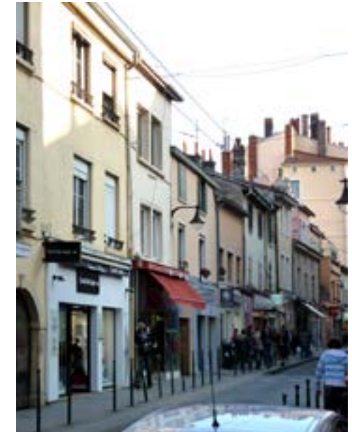
Lyon, quartier de la Croix-Rousse. La plupart des constructions de la rue sont encore en pisé. © Sébastien Moriset, CRAterre
