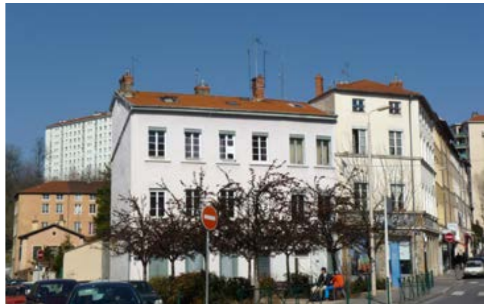
Lyon : Quartier Saint Just, Immeuble en pisé à la jonction de la rue Benoist Mary et de la rue des 4 colonnes © Sébastien Moriset, CRAterre
