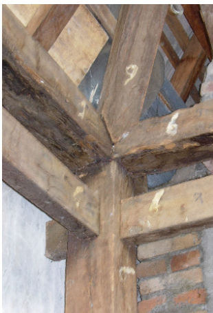
Indonesia Conexión posterior al marco Sistema sísmico
