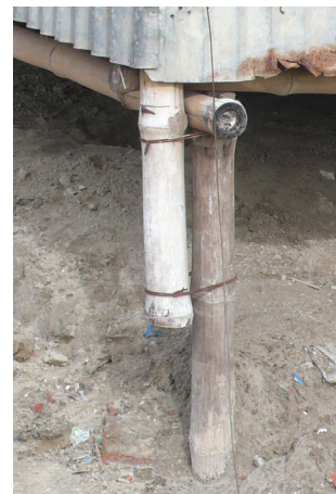
Bangladesh Piezas de ajuste de pilotes reemplazables Sistema resistente a inundaciones
