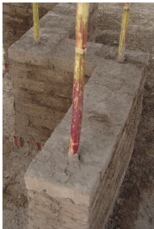
Perú Refuerzo vertical Sistema sísmico
