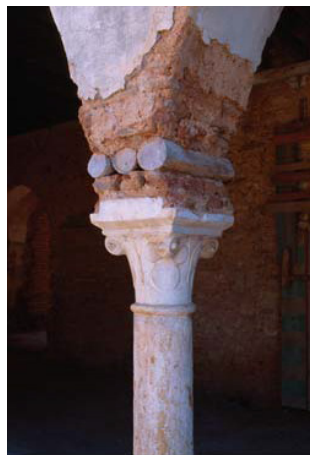
Argelia Troncos de madera sobre la columna Sistema sísmico
