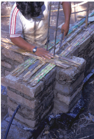
El Salvador Refuerzo horizontal Sistema sísmico
