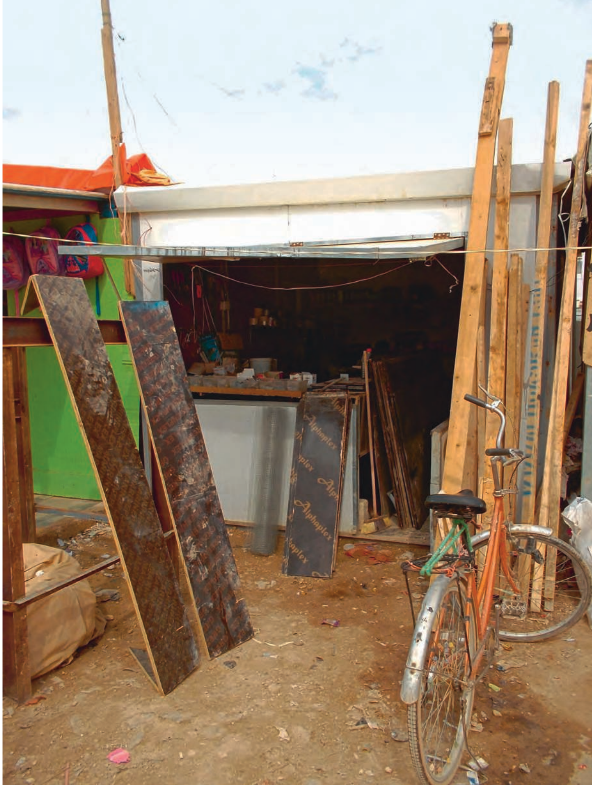
Fig. 4 Camp de Zaatari. Un atelier de menuiserie transformant les éléments de structure et les panneaux de bois reconstitué provenant des «caravanes» démantelées © K. Dorai 2015.
