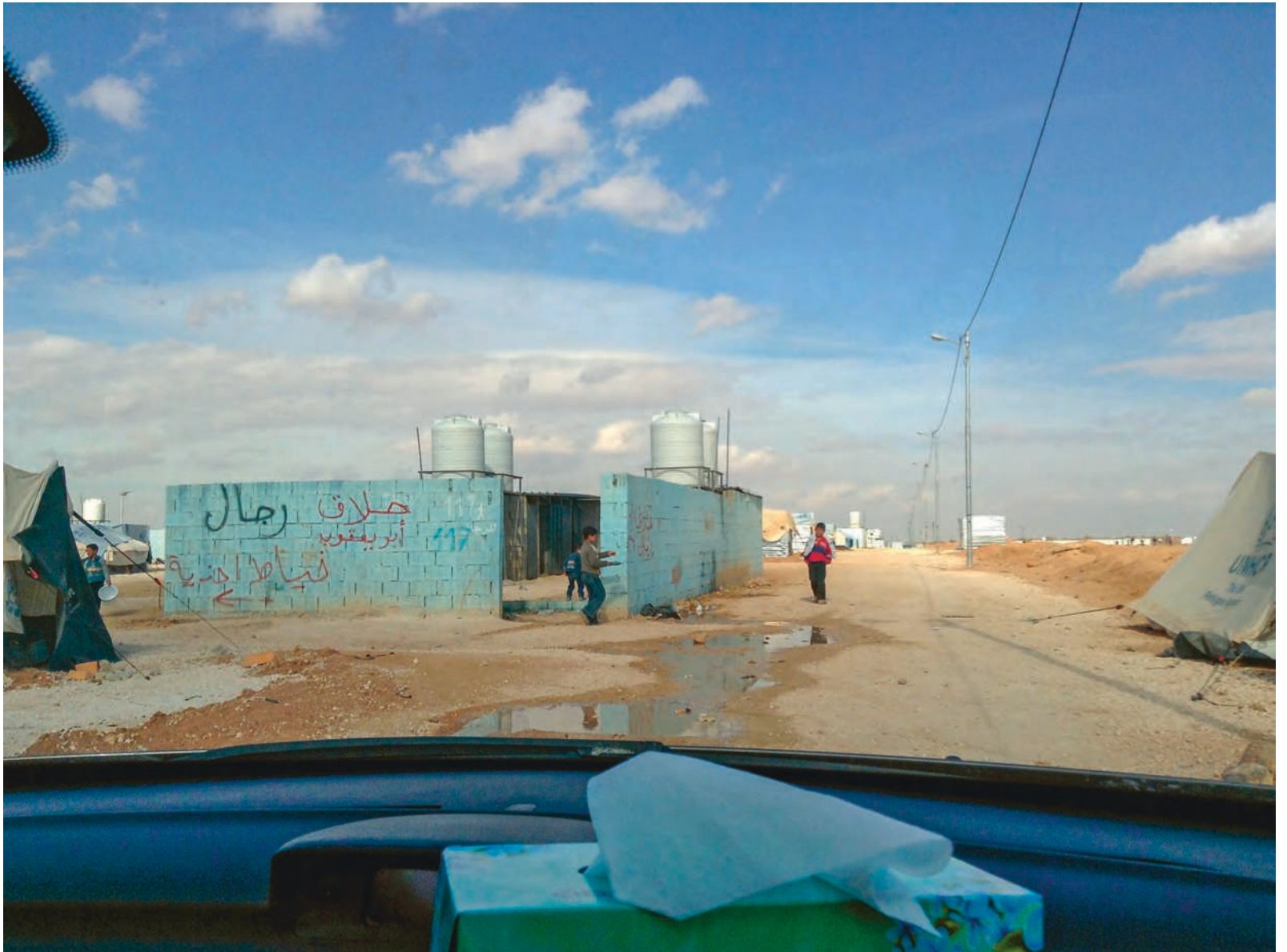
Fig. 1 Camp de Zaatari. Les blocs sanitaires en 2012 © P. Piraud-Fournet 2012.
