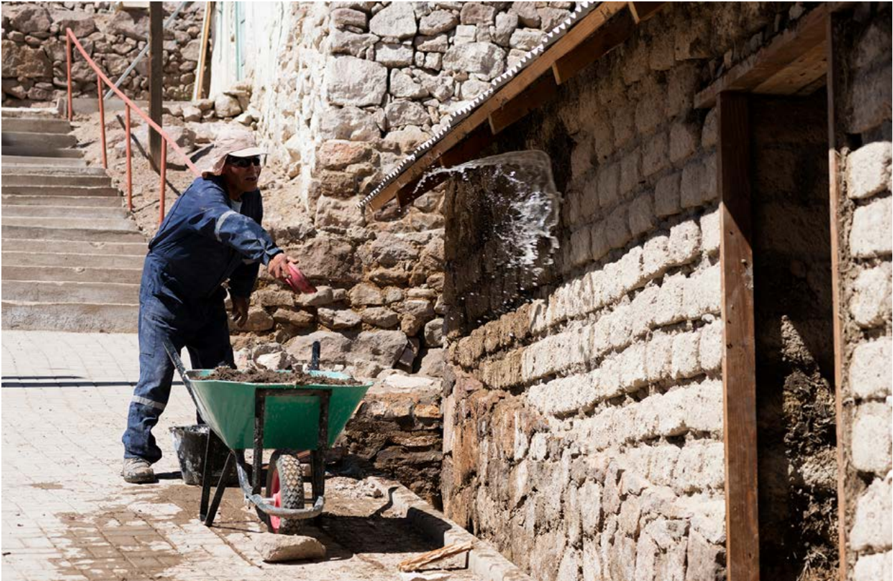
Fig 5 : École atelier formation communautaire restauration des façade patrimoniales de Timar
