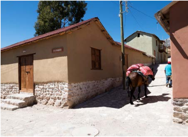
Fig 4 : Village de Belén, Putre, façades restaurées avec le programme de formation communautaire
