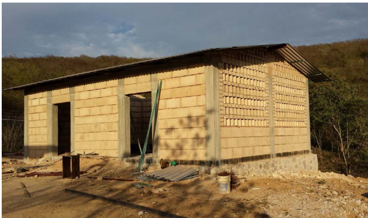
Fig.3 : Salle CCIM. Arévalo, I (2015). Source : PAP Architecture pour le Développement Durable.
