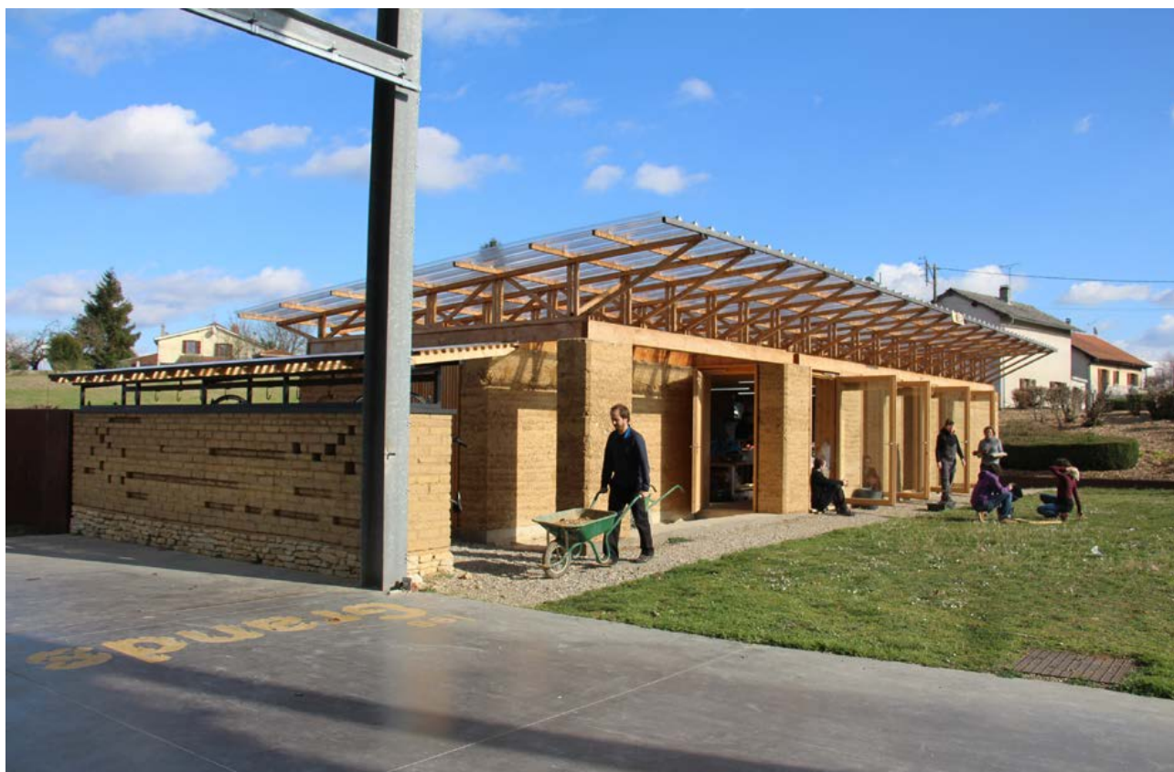
Fig.7 : Les chantiers-écoles, comme ici le bâtiment en pisé utilisé comme laboratoire d'expérimentation par amàco, sont l'occasion d'expérimenter le « faire ensemble », de la conception jusqu'à la réalisation, et favorisent une meilleure cohabitation du monde.
