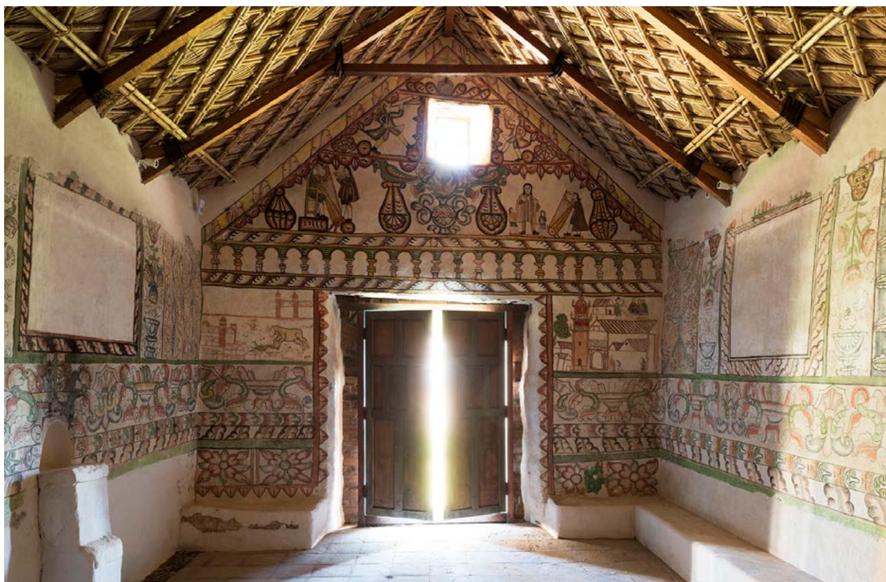
Fig.1 : Église de Pachama, Putre, Arica y Parinacota, restauré avec la communauté en 2016
