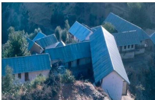
Fig4 : Couverture en zinc
