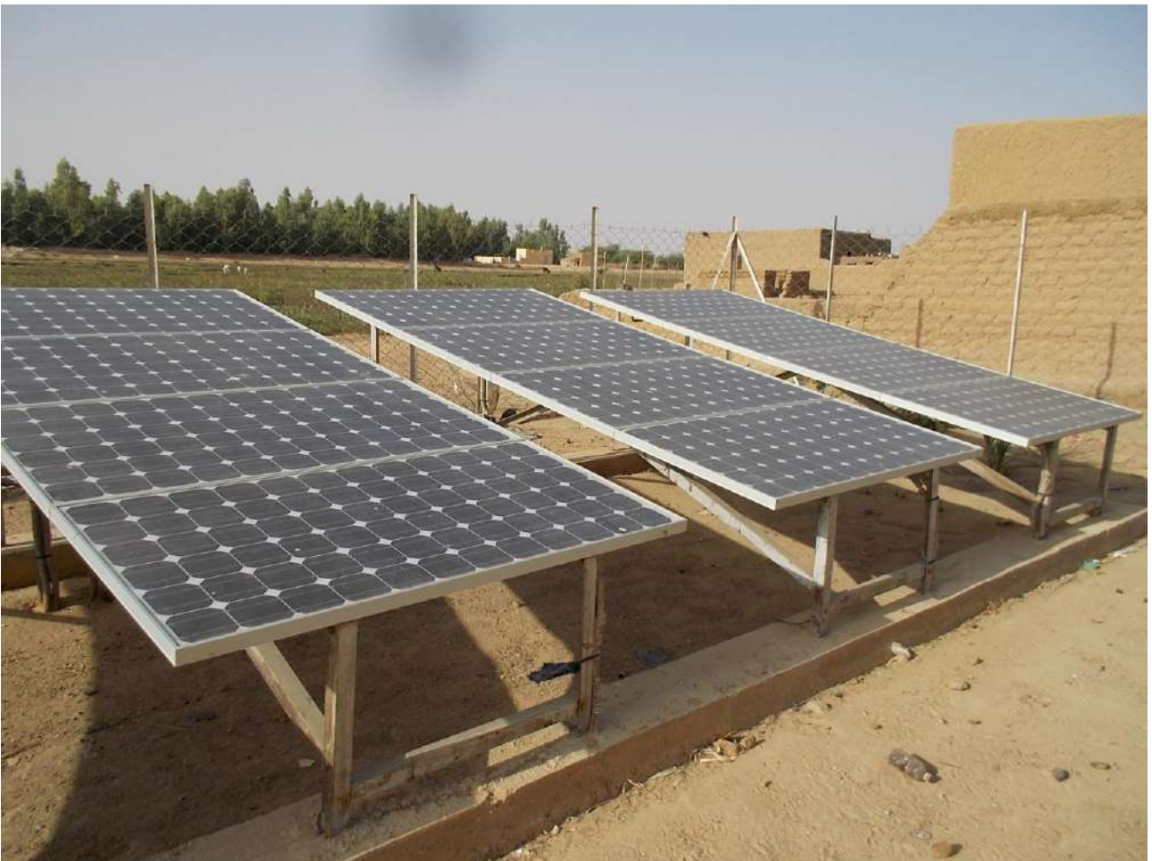
Système d'exhaure solaire pour l'abreuvement du Betail (Gao, Mali).
