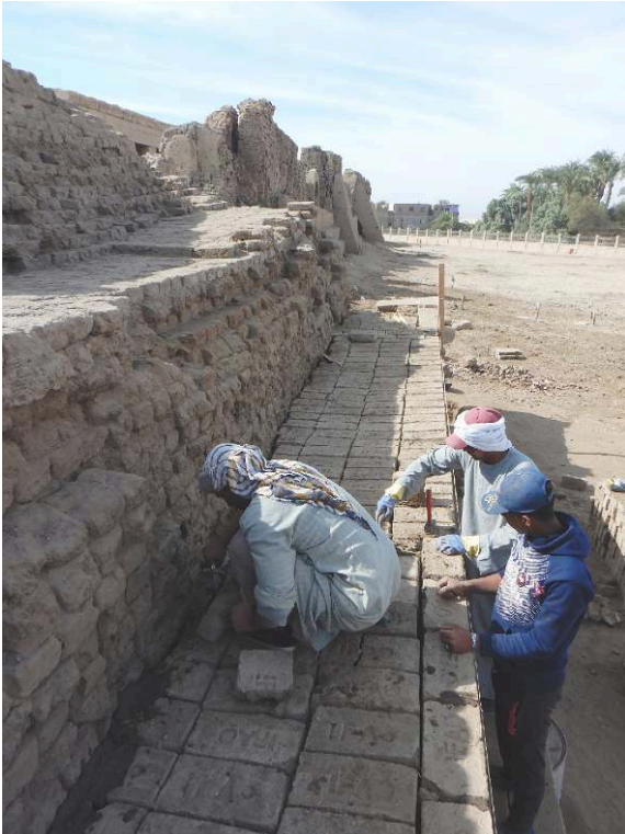
Fig. 3. Restauration du parement du mur du téménos (M. Vanpeene).
