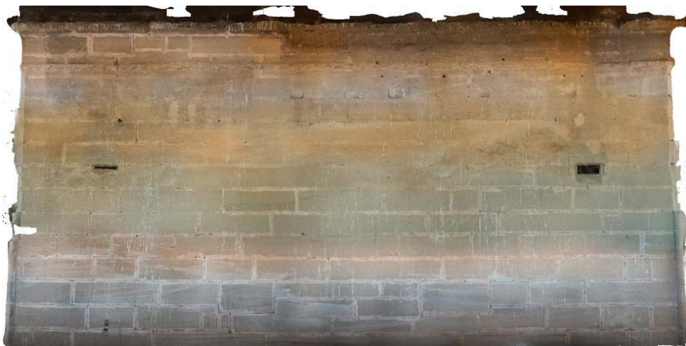
Fig. 7. Mammisi « romain », vue en ortho-photographie de la partie supérieure de l'élévation extérieure du sanctuaire (travail en cours) (C. Wolff).
